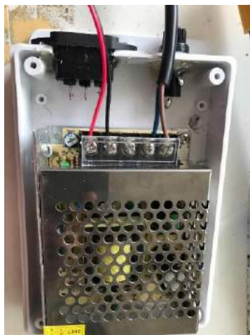
รูปที่ 5 การติดตั้งเพาเวอร์ซัพพลาย AC OUTLET และกระบอกฟิวส์ + ฟิวส์
