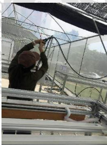
รูปที่ 16 การตัดสายเคเบิลใยของเก่าออก
