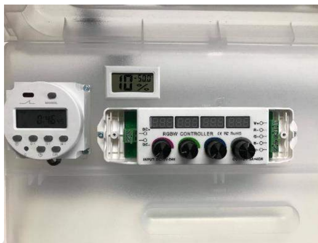
รูปที่ 3 การติดตั้งปุ่มควบคุมแบบอาร์จีบี (RGB Control)
