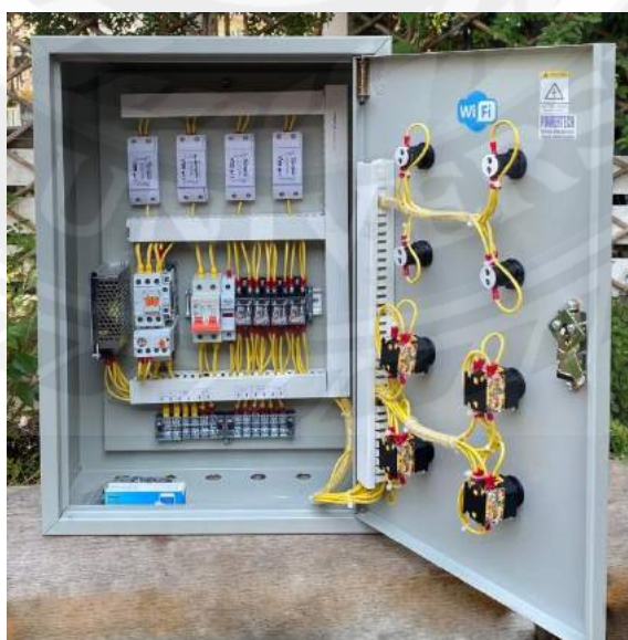
รูปที่ 2.21 แสดงข้างในของตู้บังคับ Smart Farm
