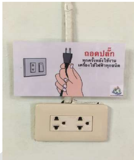
รูปที่ 4.5 ป้ายเตือน ถอดปลั๊กทุกครั้งหลังใช้งานเครื่องใช้ไฟฟ้าทุกชนิด ที่มา : คณะผู้จัดทำ
