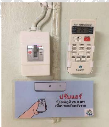
รูปที่ 4.6 ป้ายเตือน ให้ปรับแอร์ที่อุณหภูมิ 25 องศา เพื่อประหยัดพลังงาน ที่มา : คณะผู้จัดทำ
