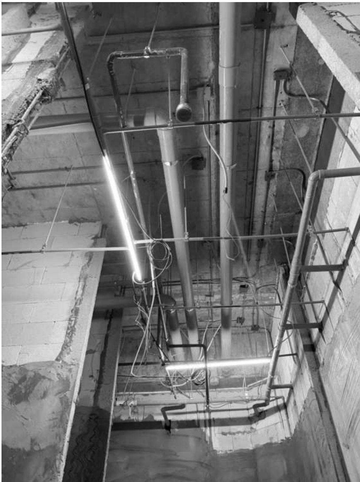
รูปที่ 2 ตรวจสอบการวางท่อสปริงเกอร์ ท่อน้ำดินน้ำเสียตามแบบหน้างาน
