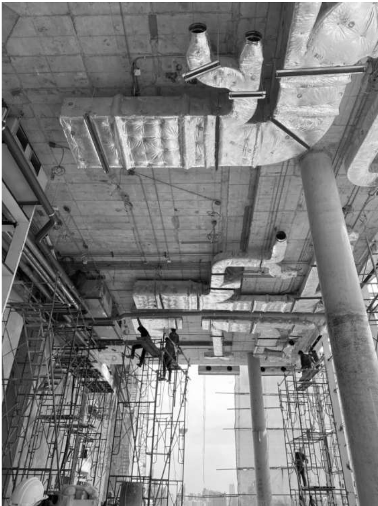
รูปที่ 1 ตรวจสอบการวางท่อแอร์ตามแบบหน้างาน
