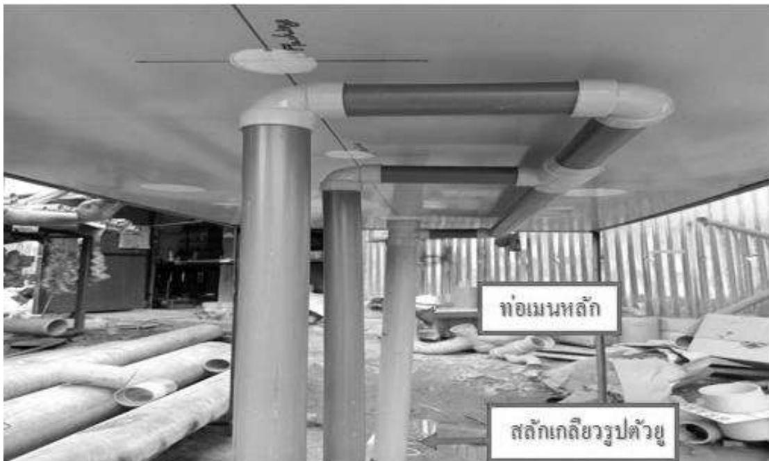
รูปที่ 3.12 การยึดท่อเมนหลักด้วยสลักเกลียวรูปตัวยู
