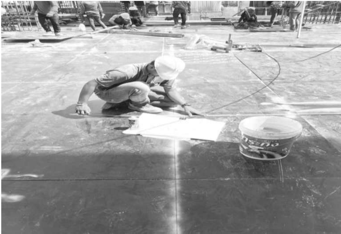
รูปที่ 1 การวัดระยะเพื่อวางท่อสลีฟก่อนเทพื้นคอนกรีต
