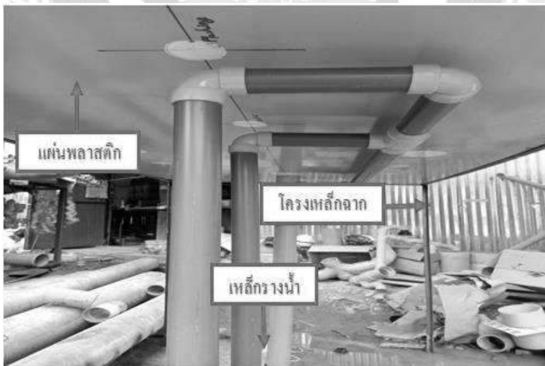
รูปที่ 3.11 การติดตั้งแผ่นพลาสติกกับโครงเหล็กฉาก และการยึดเหล็กรางน้ำ
