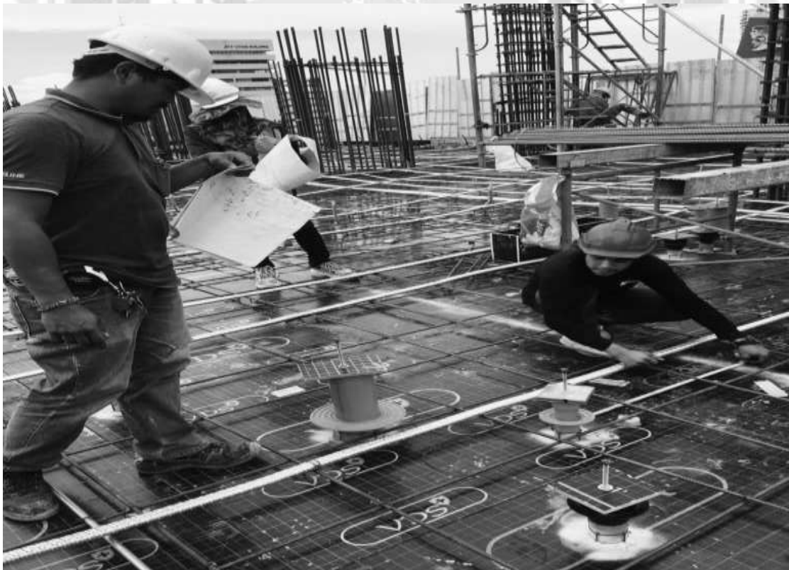
รูปที่ 2 ส่งงานระยะการวางท่อสลีฟก่อนเทคอนกรีต
