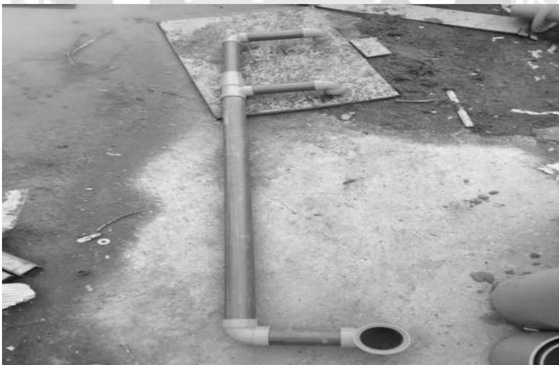
รูปที่ 3.17 ลักษณะการประกอบท่ออากาศตามแบบนวัตกรรม ห้องคู่ (T04)
