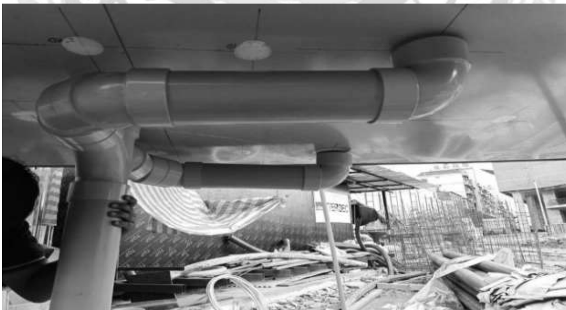
รูปที่ 3.13 การประกอบท่อไฮโดรค็อกที่ต่อจากท่อเมนหลัก ห้องคู่ (T04)
