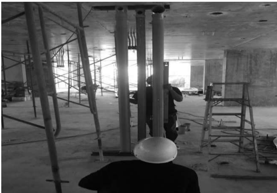
รูปที่ 3.8 การติดตั้งท่อเมนหลักของท่อไฮโดรคิก ท่อน้ำทิ้งและท่ออากาศ ห้องคู่ (T04) 3.8.4 ทำการประกอบและติดตั้งท่อที่ต่อจากท่อเมนหลักของท่อไฮโดรคิก ท่อน้ำทิ้งและท่ออากาศ
