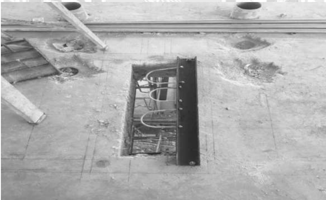
รูปที่ 3.7 การติดตั้งเหล็กทรงน้ำและสลักเกลียวรูปตัวยู 3.8.3 ทำการประกอบและติดตั้งท่อเมนหลักของท่อโสโครก ท่อน้ำทิ้งและท่ออากาศโดย วักระยะการติดตั้งจากแบบหน้างานจริง
