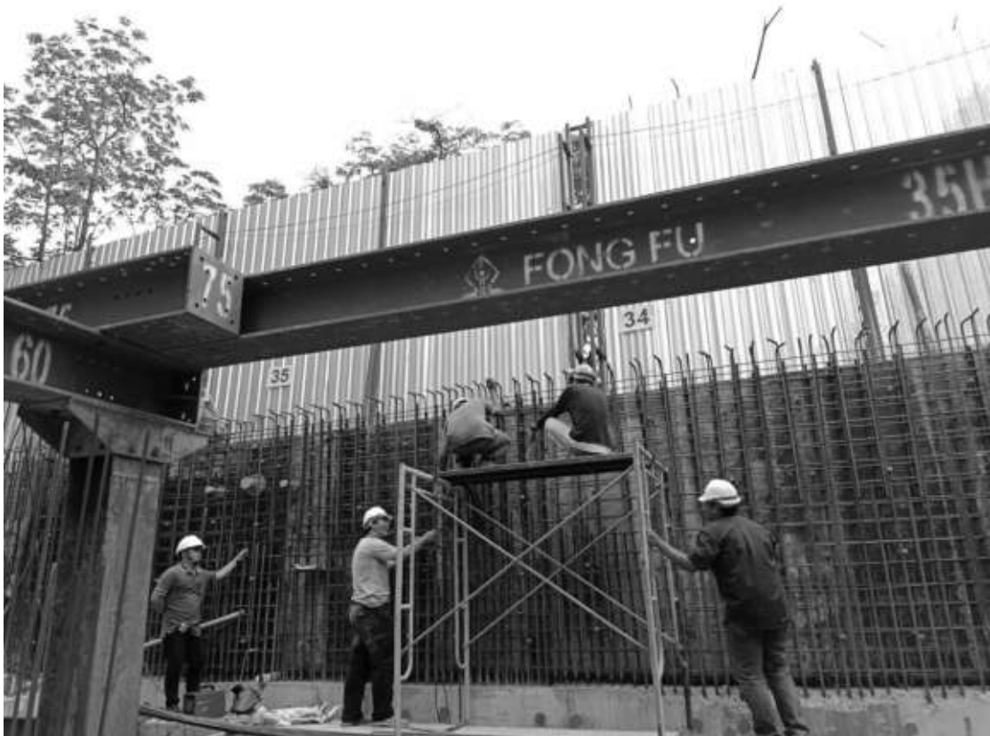
รูปที่ 3 การวางท่อสลีฟที่ผนังบ่อบำบัดน้ำเสีย
