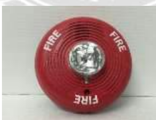
รูปที่ 2.29 อุปกรณ์แจ้งเตือนด้วยเสียงและแสง (Horn / Strobe)
