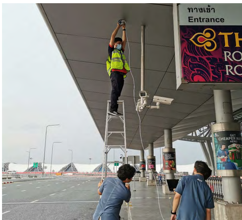
รูปที่ 4.1.2 ทดสอบมุมมองภาพก่อนติดตั้งจริง
