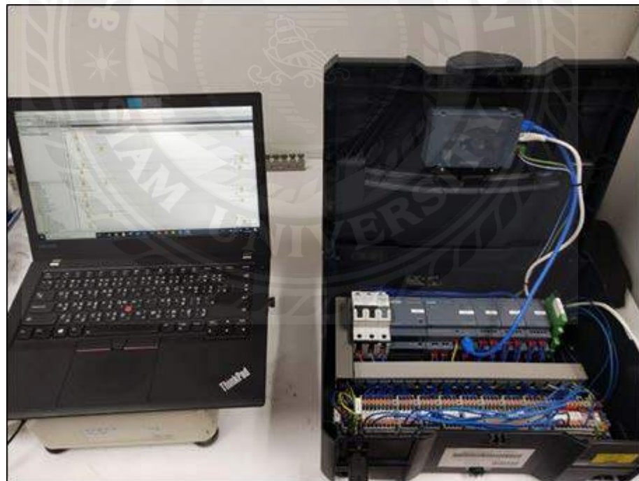
ทำการประกอบตู้ควบคุมไฟฟ้า
