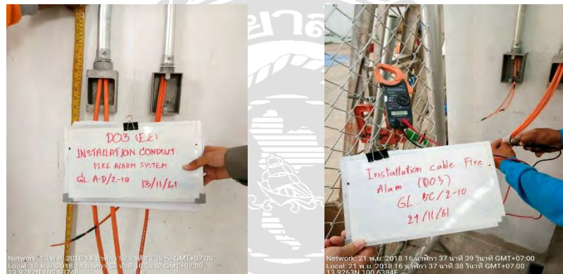
รูปที่ 4.7 การส่งงานทดสอบสาย Fire Alarm
