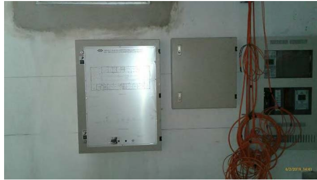
รูปที่ 4.6 การติดตั้งตู้ Annunciator
