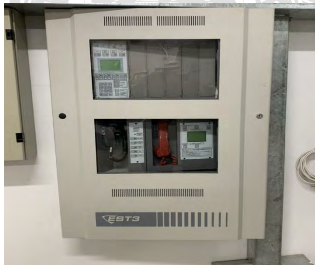
รูปที่ 4.5 การติดตั้งตู้ FCP
