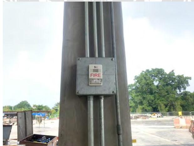
รูปที่ 4.3 การติดตั้ง Alarm Bell
