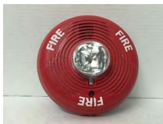
รูปที่ 2.28 อุปกรณ์แจ้งเตือนด้วยเสียงและแสง (Horn / Strobe)
