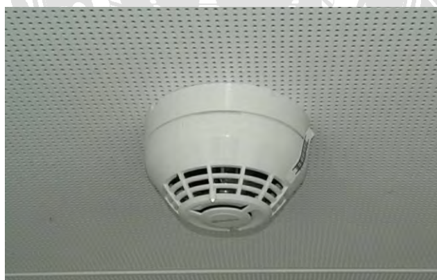
รูปที่ 4.1 การติดตั้งหัว Smoke Detector และ Heat Detector บนห้องฝ้า
