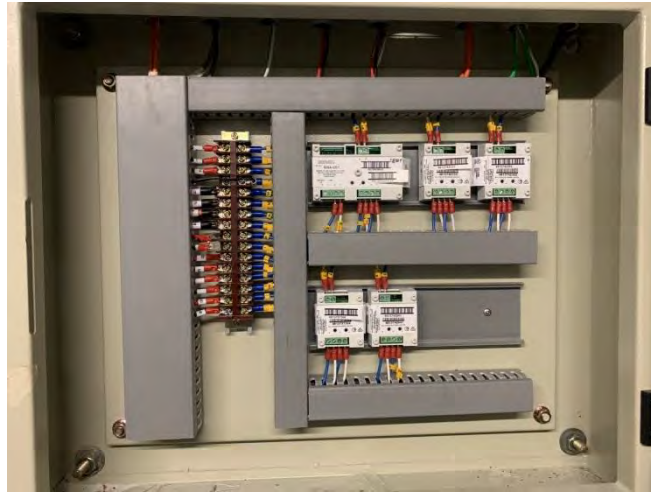
รูปที่ 4.4 การติดตั้งตู้ Fire Alarm Terminal Box
