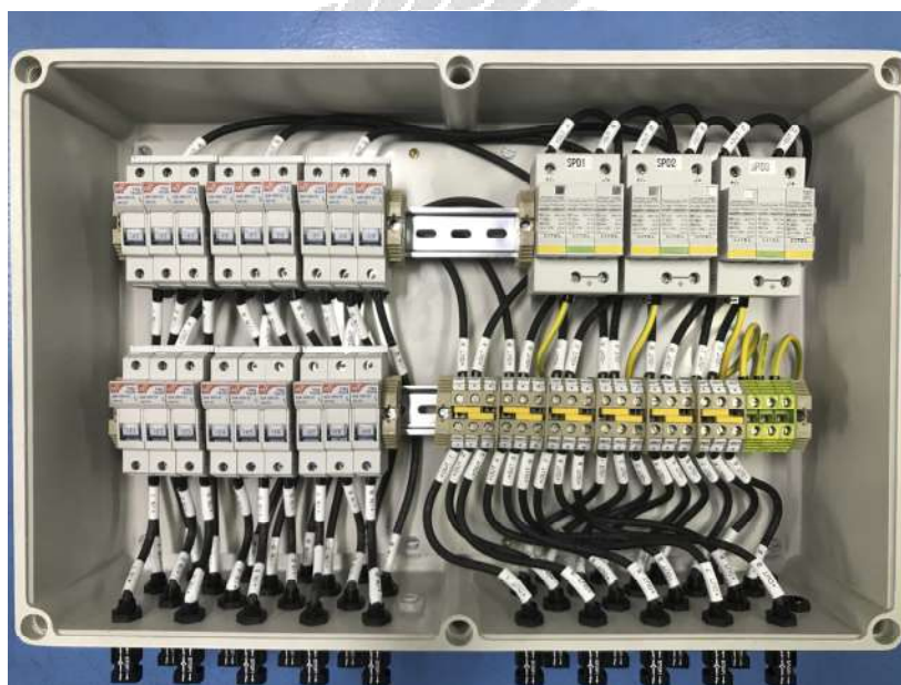
รูปที่ 2.5 ตู้ควบคุมไฟฟ้ากระแสตรง (DC Combiner Box)
