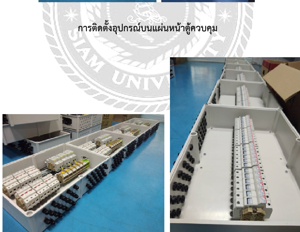
การนำแผ่นหน้าตู้ควบคุมมาติดตั้งในตู้ควบคุม
