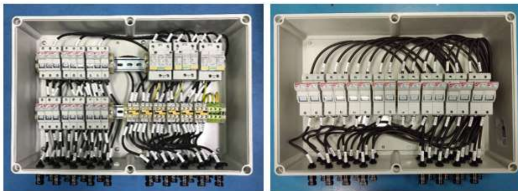
การเดินสายไฟสำหรับแผงเซลล์แสงอาทิตย์
