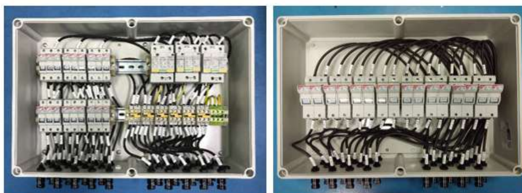
รูปที่ 4.12 การเดินสายไฟสำหรับแผงเซลล์แสงอาทิตย์
