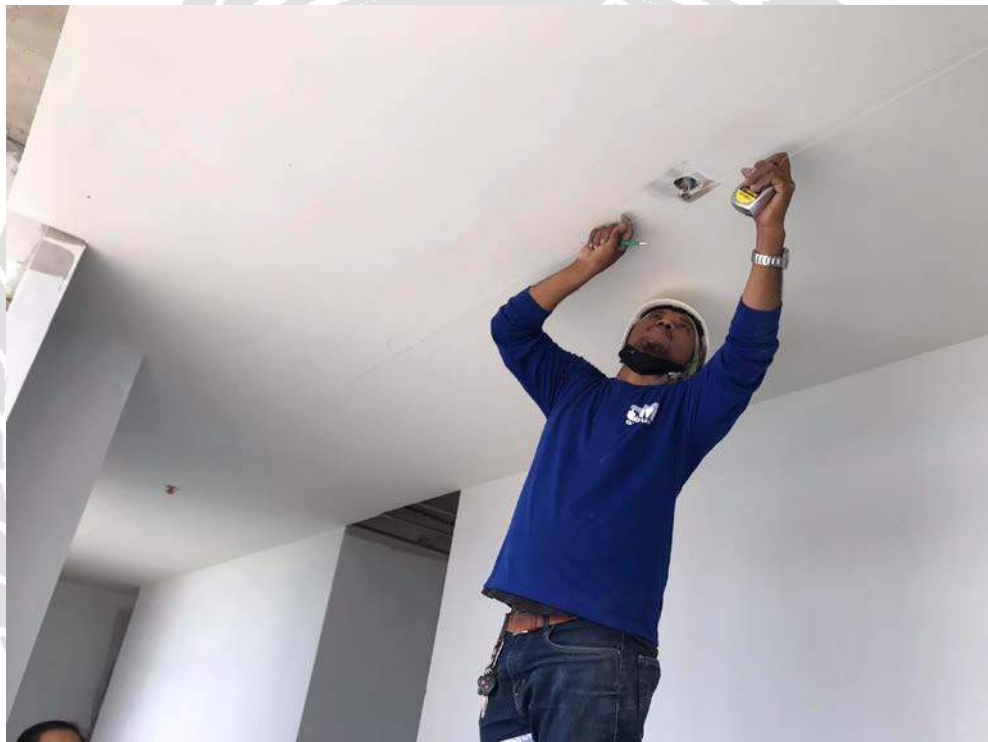
รูปที่ 4.9 การติดตั้งระบบเสียงประกาศ ชั้นที่ 2 อาคารศาลอาญาทุจริต เขตตลิ่งชัน
