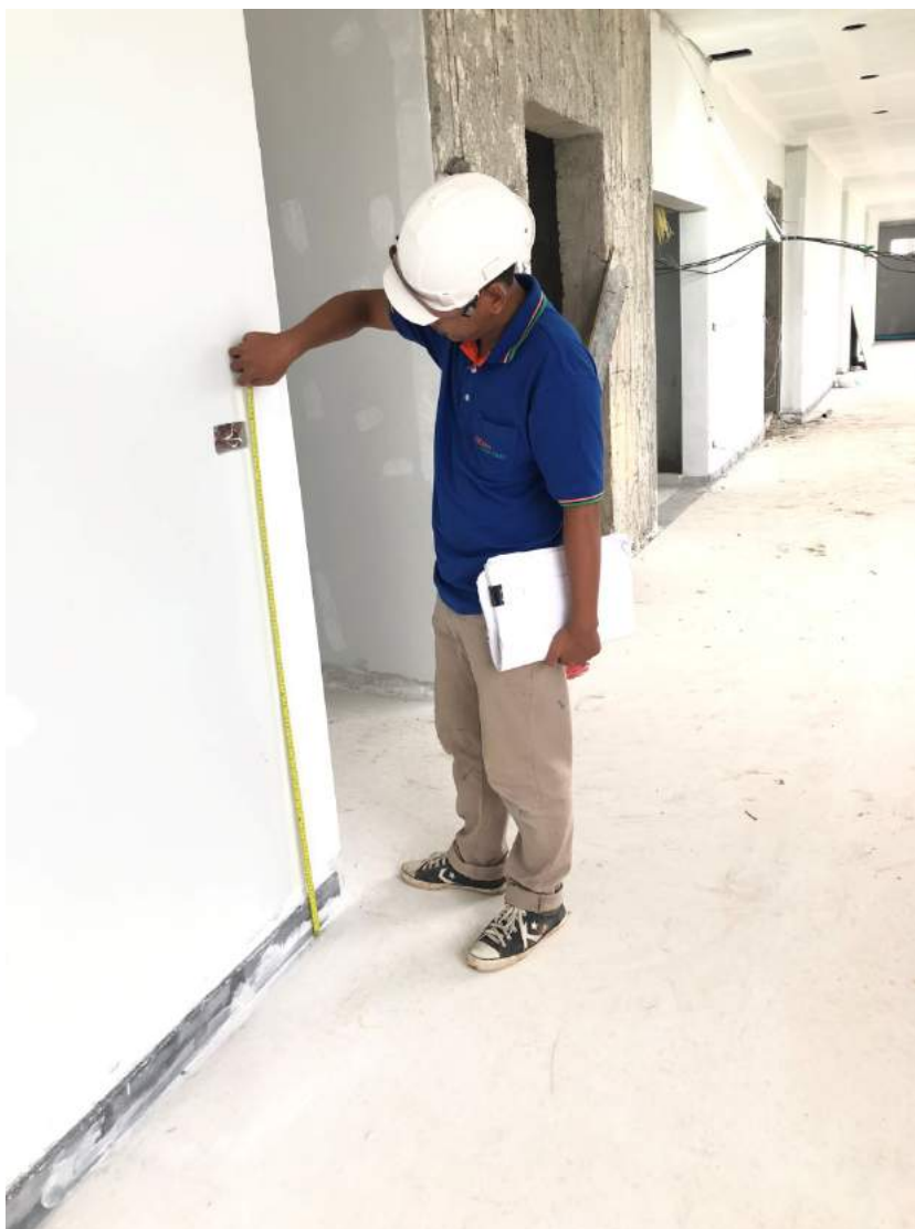
รูปที่ 2 การตรวจเช็คตำแหน่งบล็อกไฟ
