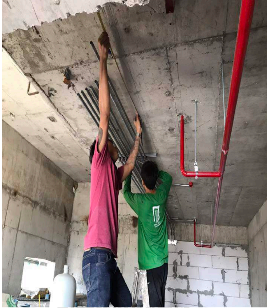
รูปที่ 6 การติดตั้งท่อไฟ
