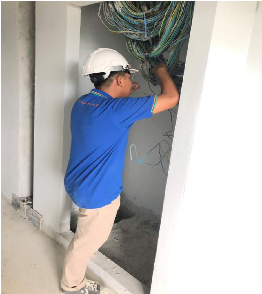
รูปที่ 7 การตรวจเช็คสายไฟ
