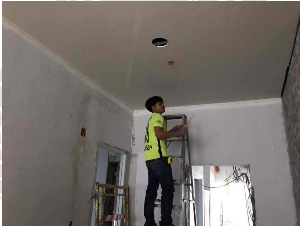
รูปที่ 4.8 การติดตั้งระบบแจ้งเหตุเพลิงไหม้ ชั้นที่ 2 อาคารศาลอาญาทูลกระหม่อมฯ เขตตลิ่งชัน
