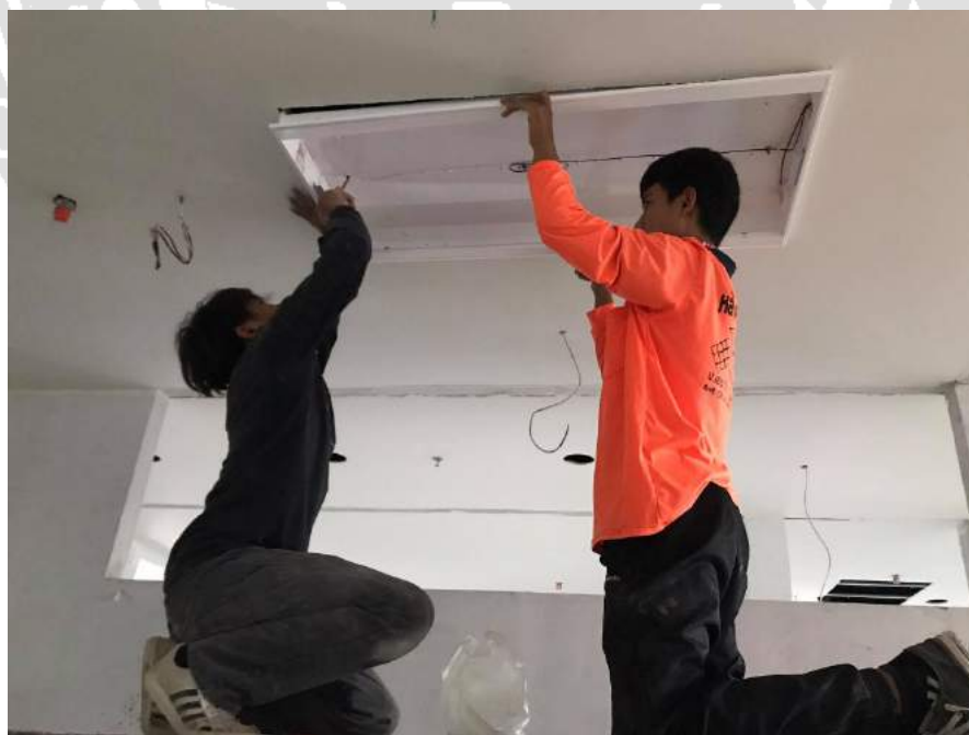
รูปที่ 4.6 การติดตั้งระบบไฟฟ้าแสงสว่าง ชั้นที่ 2 อาคารศาลาอัญญาทุจริต เขตตลิ่งชัน
