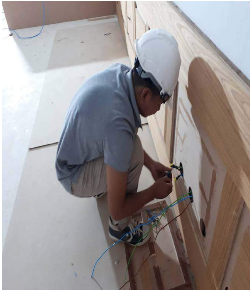
รูปที่ 3 การต่อสายไฟ
