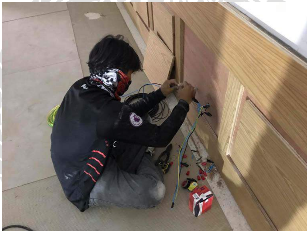
รูปที่ 4.7 การติดตั้งระบบเต้ารับ ชั้นที่ 2 อาคารศาลาอาญาทุจริต เขตตลิ่งชัน
