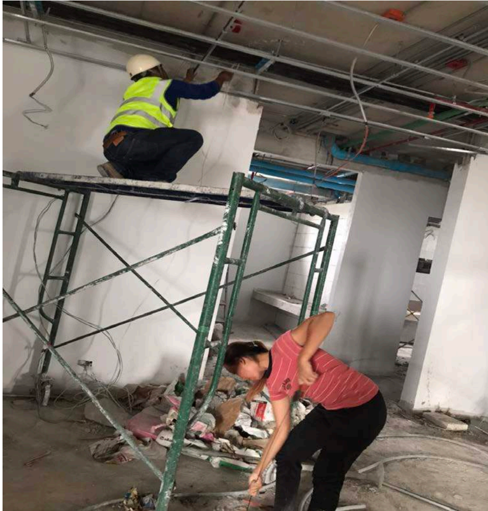
รูปที่ การร้อยสาย 5ไฟเข้าท่อ
