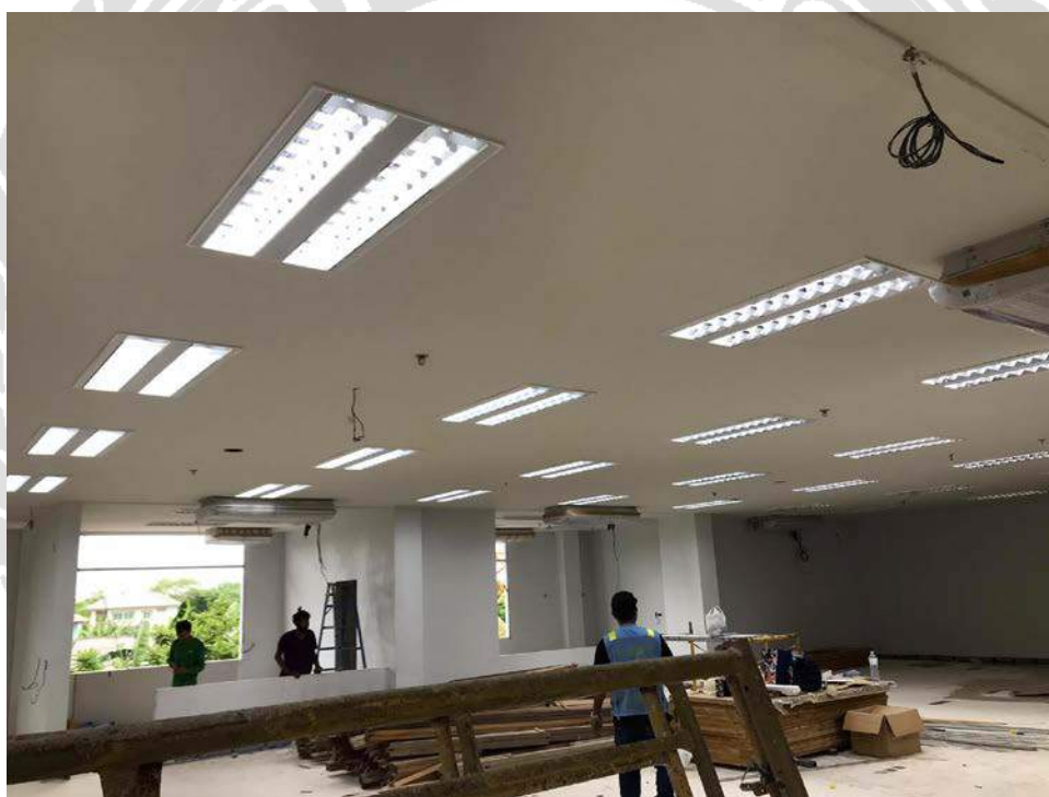
รูปที่ 4.10 การตรวจเช็คโคมตะแกรงฝ้าฝ้า
