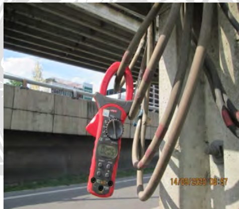
รูปที่ 6 วัดค่ากระแสแอมป์มิเตอร์
