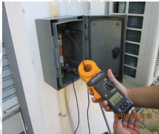
รูปที่ 14 วัดค่ากราวด์ Test Box
