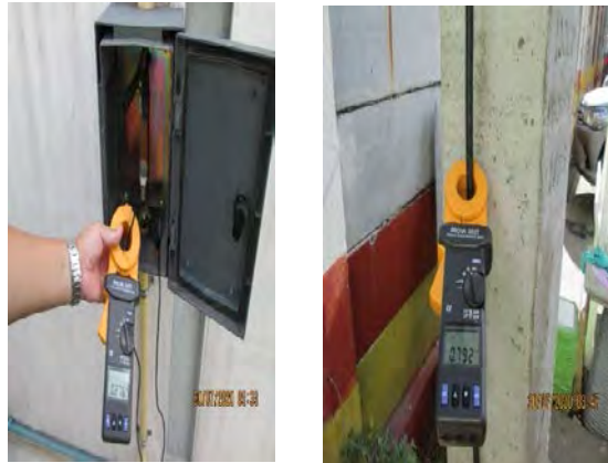
รูปที่ 4.28 Earth Resistance Clamp Meter
