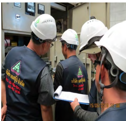
รูปที่ 3.4 การตรวจสอบอุปกรณ์
