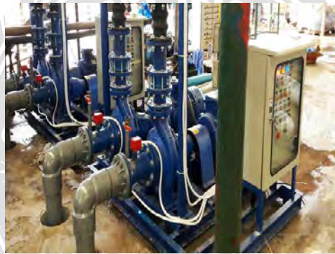
รูปที่ 3.9 ปั๊มน้ำ
