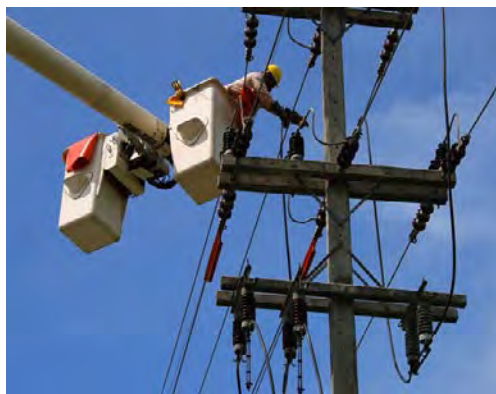
รูปที่ 3.10 การติดตั้งระบบไฟฟ้าแรงสูง
