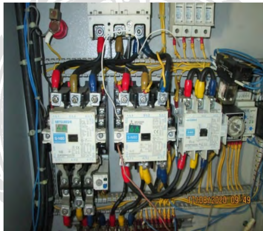
รูปที่ 12 Magnetic Contactor
