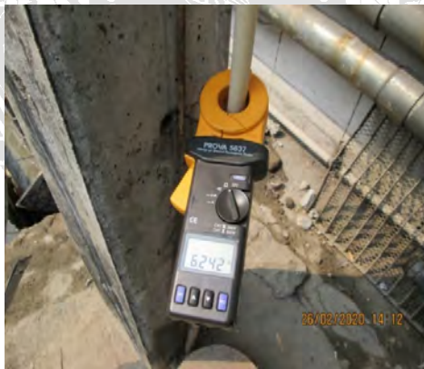
รูปที่ 4 วัดค่าแรงดันหม้อแปลง
