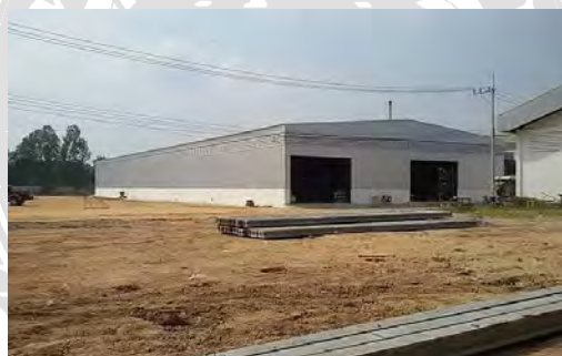
รูปที่ 3.11 โกดังที่กำลังก่อสร้าง
