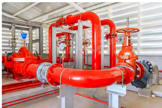
รูปที่ 3.12 ระบบดับเพลิง
