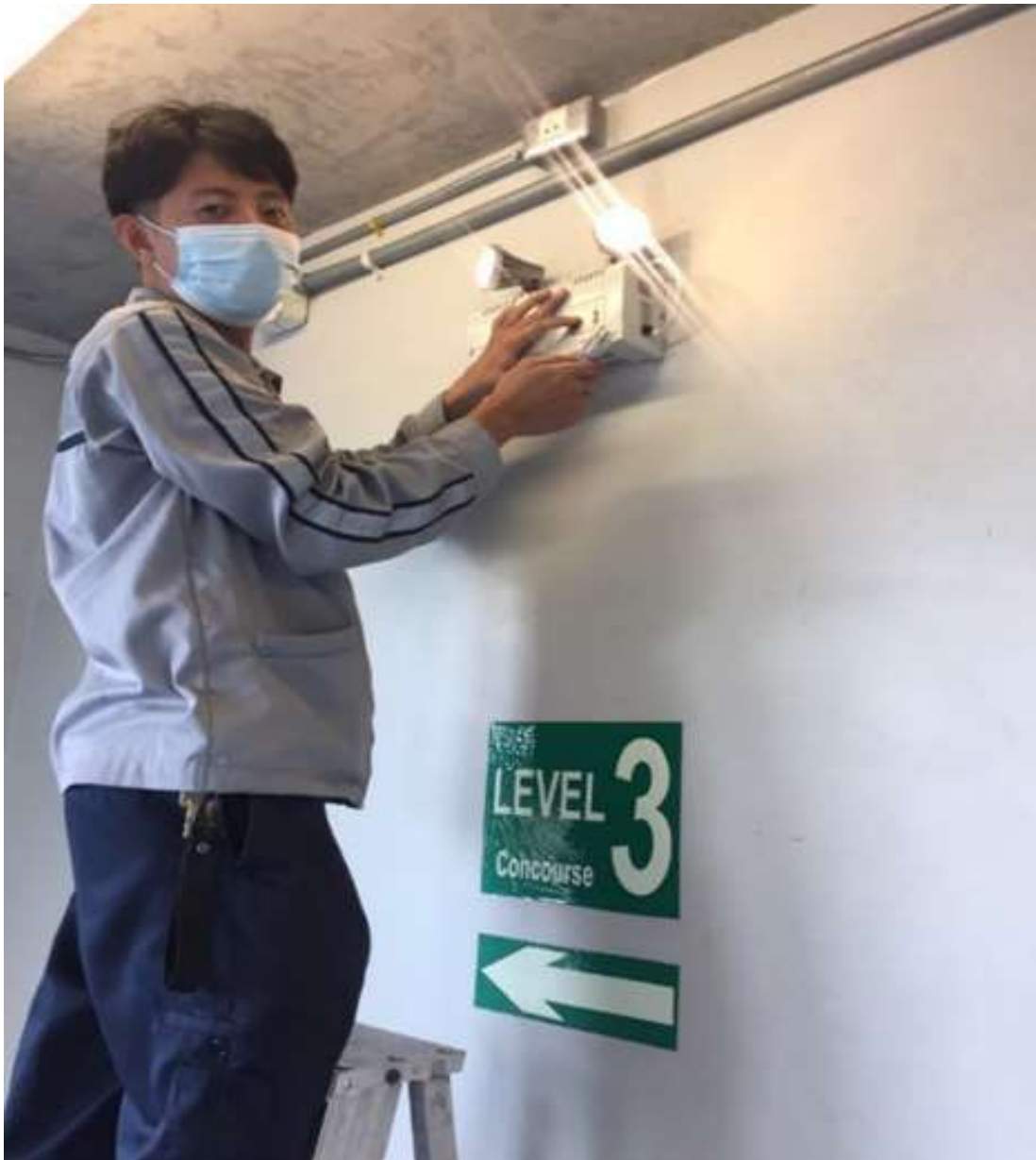
รูปที่ 4.4 ทดสอบระบบแสงสว่างฉุกเฉิน (Emergency Light) ระบบไฟฟ้าผิดปกติ
