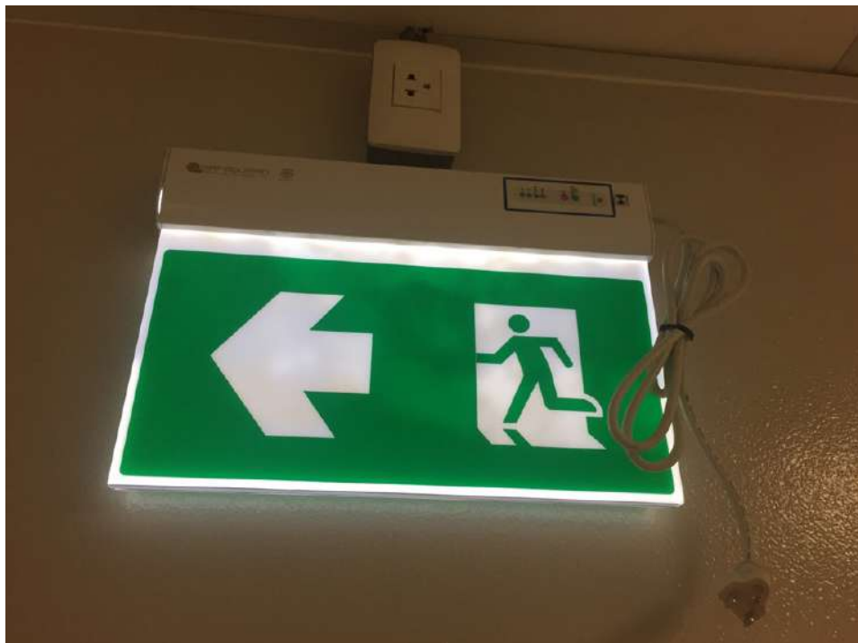
รูปที่ 2.14 โคมไฟฟ้าป้ายทางออกฉุกเฉินที่ห้องค์ประกอบภาพ 2 ชั้น
