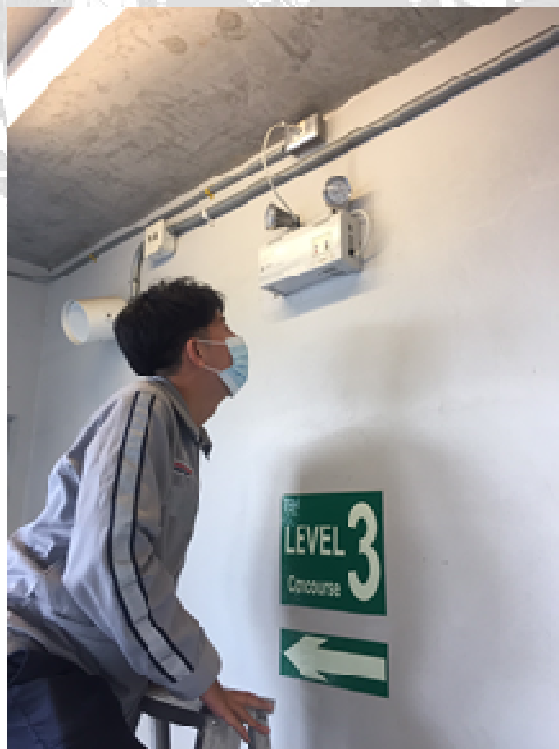
ตรวจสอบ Emergency Light ตำแหน่งทางเข้าจุดขายตั๋ว (สถานีมักกะสัน)
