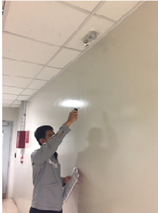
ตรวจสอบ Emergency Light (แบบฝังเพดาน) ตำแหน่งทางเข้าห้องนายสถานี (สถานีมักกะสัน)
