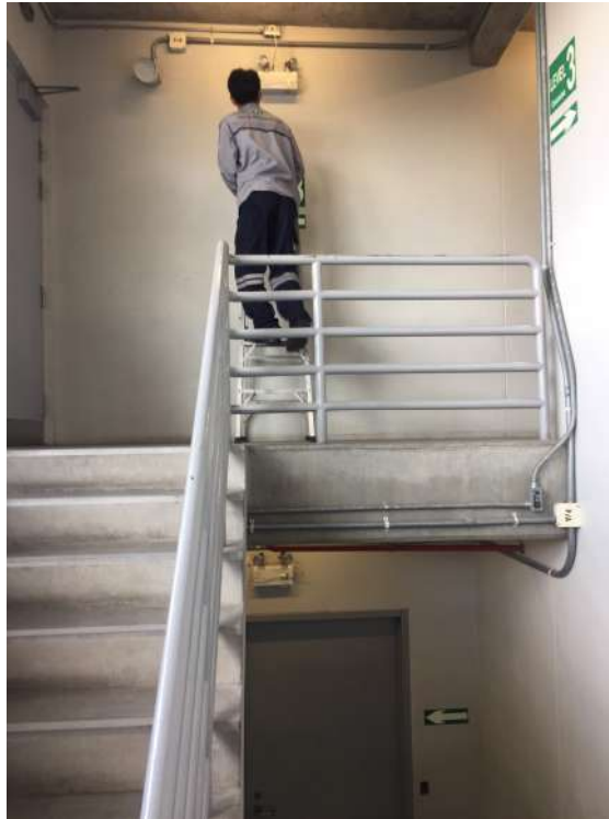
ตรวจสอบ Emergency Light ตำแหน่งทางบันไดหนีไฟ (สถานีมักกะสัน)
