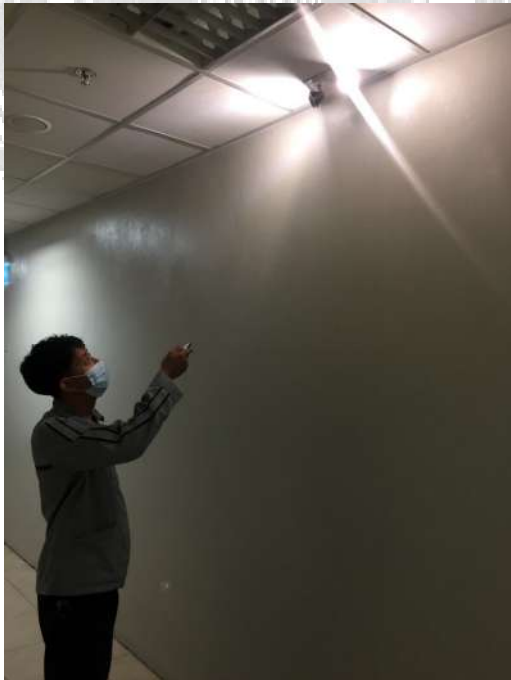
ตรวจสอบ Emergency Light (แบบฝังเพดาน) ตำแหน่งทางเข้าห้องControl (สถานีมักกะสัน)
