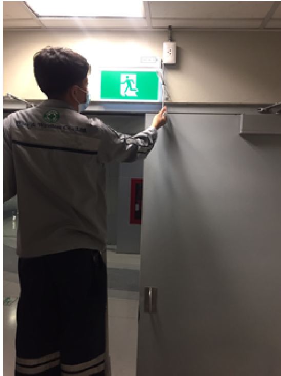
ตรวจสอบ Emergency Exit ตำแหน่งทางเข้าห้องนายสถานี (สถานีมักกะสัน)
