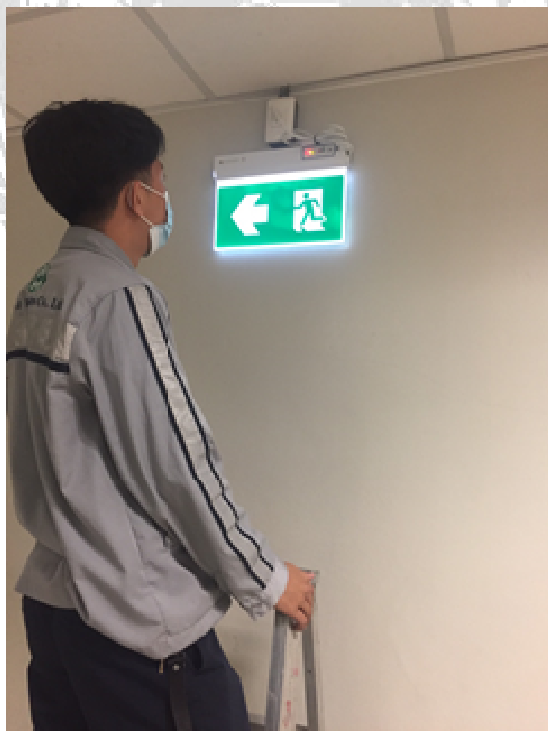
ตรวจสอบ Emergency Exit ตำแหน่งทางเข้าห้องControl (สถานีมักกะสัน)
