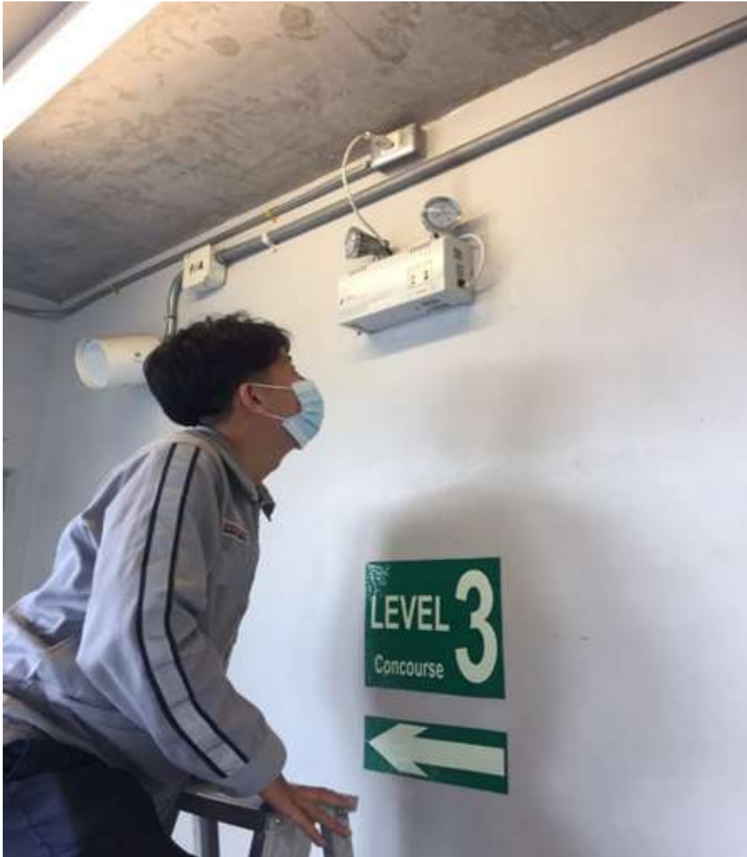
รูปที่ 4.3 ทดสอบระบบแสงสว่างฉุกเฉิน (Emergency Light) ระบบไฟฟ้าปกติ
