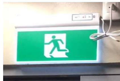
รูปที่ 2.9 โคมไฟฟ้าป้ายทางออกฉุกเฉินที่ใช้องค์ประกอบภาพ 1 ชั้น
