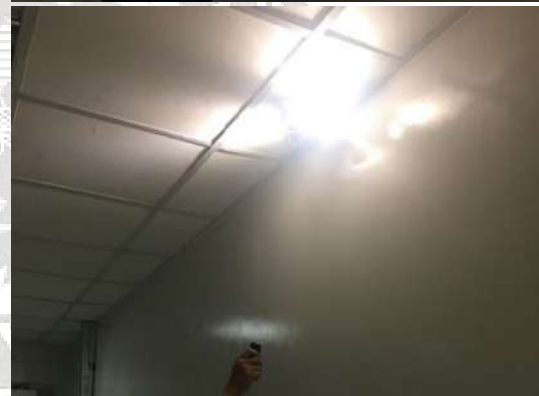
รูปที่ 4.6 ทดสอบระบบแสงสว่างฉุกเฉิน (Emergency Light) โดยใช้รีโมท (กดแล้ว)
