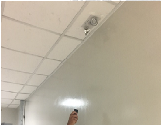
รูปที่ 4.5 ทดสอบระบบแสงสว่างฉุกเฉิน (Emergency Light) โดยใช้รีโมท (ยังไม่กด)
