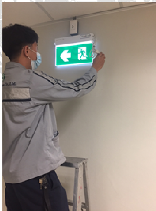
ตรวจสอบ Emergency Exit ตำแหน่งบันไดหนีไฟ (สถานีมักกะสัน)
