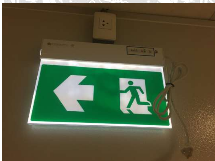
รูปที่ 4.9 ทดสอบป้ายทางออกฉุกเฉินเมื่อไม่มีไฟเข้า
