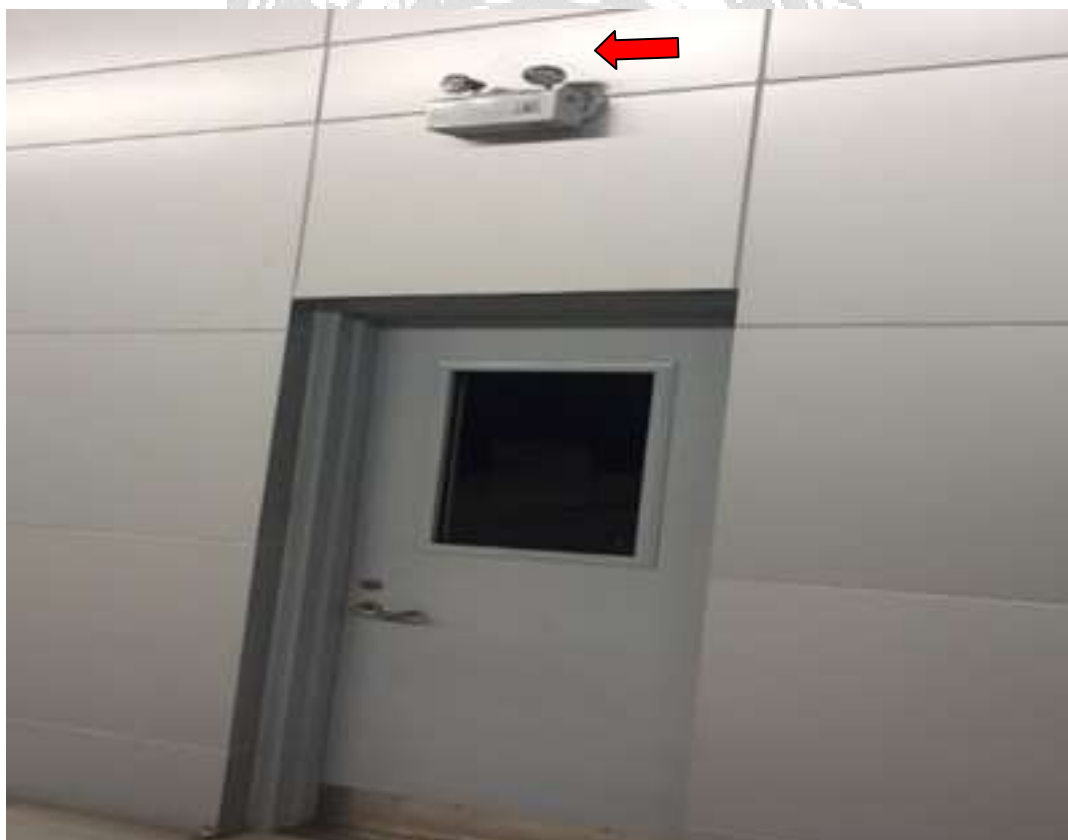
รูปที่ 2.2 การติดตั้งโคมไฟฉุกเฉินแบบแบตเตอรี่แห้งภายในอาคาร
