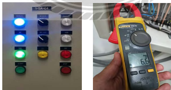
รูปที่ 4.12 ตรวจสอบวัดกระแสไฟฟ้า
