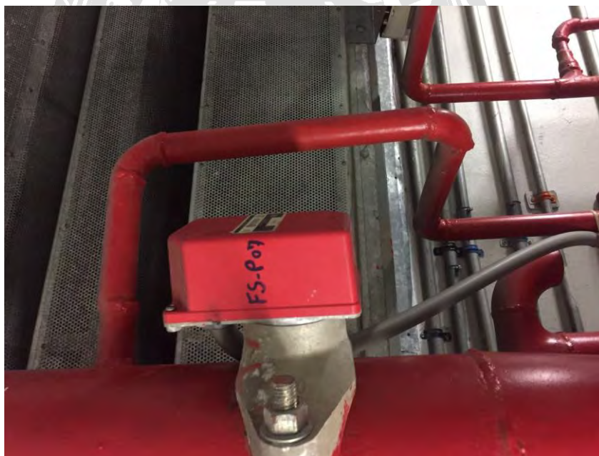
รูปที่ 4.12 อุปกรณ์ตรวจสอบน้ำไหล ( Water Flow switch )
