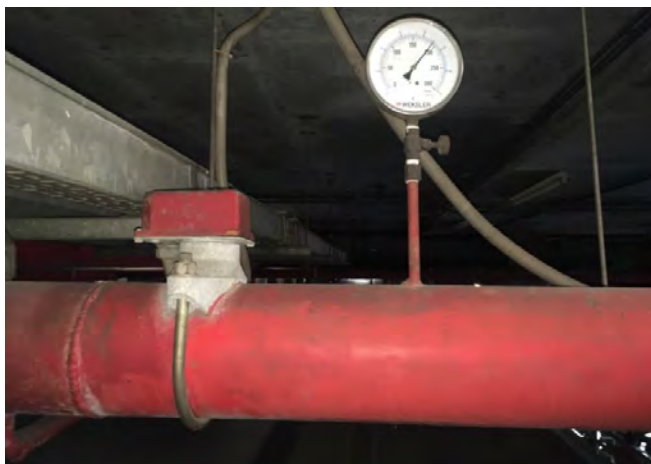
รูปที่ 2.17 อุปกรณ์ตรวจสอบน้ำไหล ( Water Flow switch )
