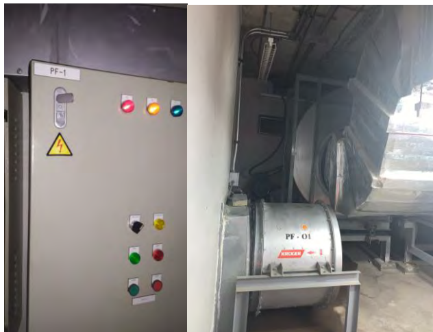
รูปที่ 4.16 ตรวจสอบการทำงานของ Pressurized fan
