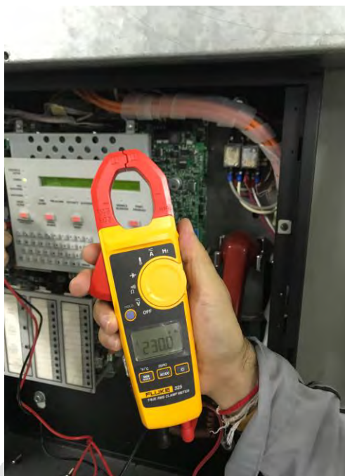
รูปที่ 4.4 วัดแรงดันของชุดจ่ายไฟ (Power Supply)
