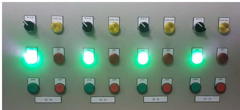
รูปที่ 4.18 ตรวจสอบการทำงานของ Smoke Extract Fan
