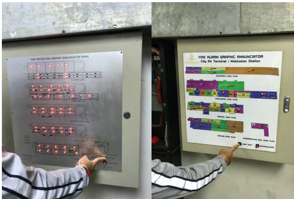
รูปที่ 4.2 Test Lamp Graphic Annunciator
