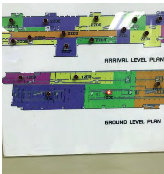
รูปที่ 4.10 ตู้ Graphic Annunciator แสดงผลจุดที่ ทดสอบ Smoke Detector
