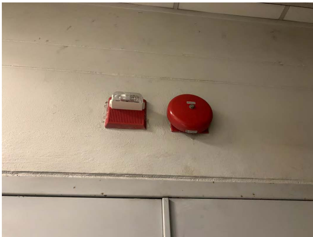
รูปที่ 2.19 อุปกรณ์แจ้งสัญญาณด้วยแสงและเสียง
