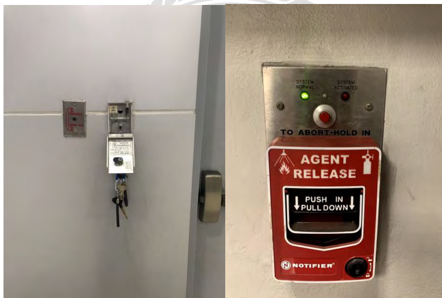
รูปที่ 2.10 Manual Push Station
