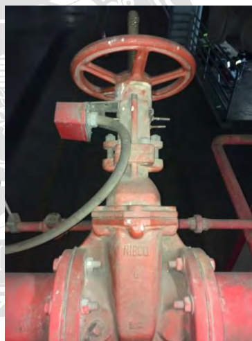
รูปที่ 2.18 อุปกรณ์ตรวจสอบสถานะของวาล์วน้ำ ( Supervisory Switch )
