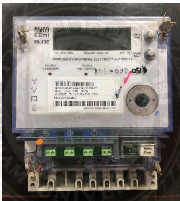
รูปที่ 2.18 มิเตอร์ 3 เฟส 3 สาย ประกอบด้วย ซีที วีที แรงสูง ทีโอยู
