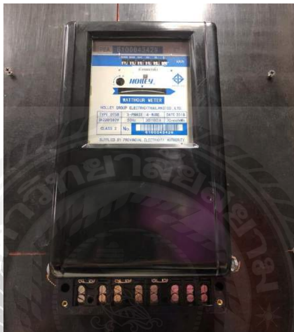
รูปที่ 2.13 มิเตอร์ 3 เฟส 4 สาย แบบต่อตรง ชนิดงานหมุน
