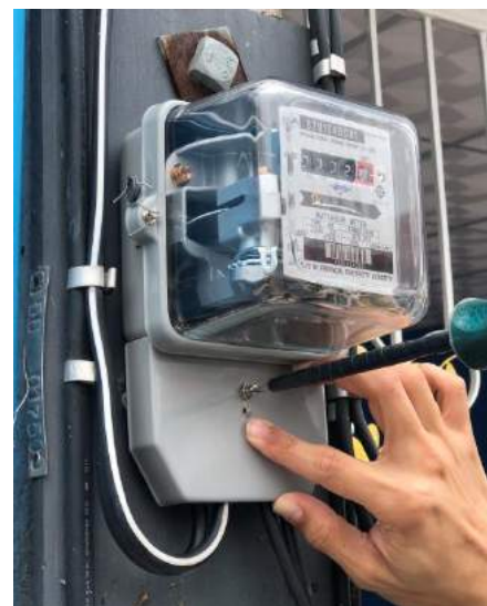
รูปที่ 4.2 การติดตั้งมิเตอร์ประเภท 1 เฟส 2 สาย
