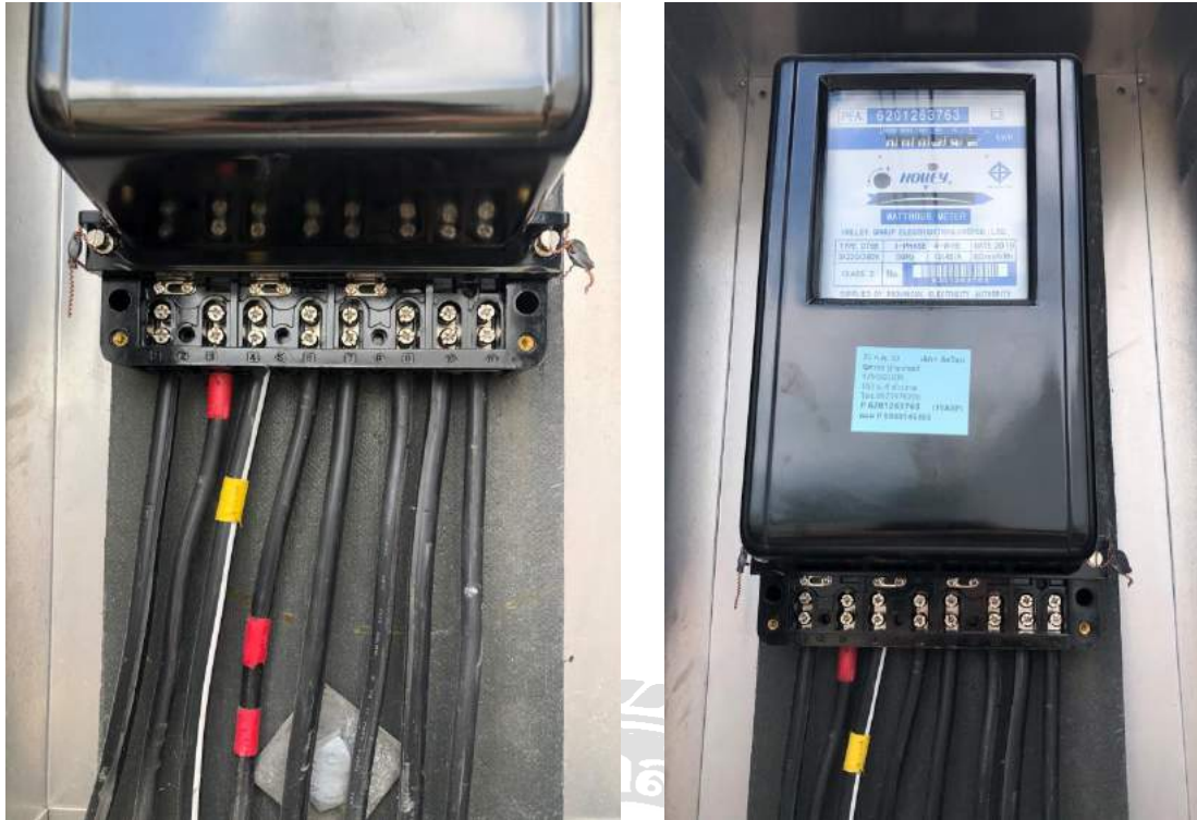
รูปที่ 4.4 การติดตั้งมิเตอร์ประเภท 3 เฟส 4 สาย
