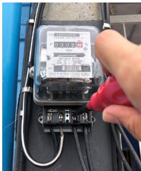
รูปที่ 4.2 การติดตั้งมิเตอร์ประเภท 1 เฟส 2 สาย
