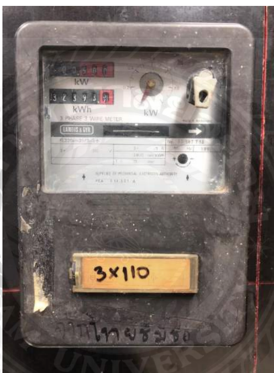
รูปที่ 2.17 มิเตอร์ 3 เฟส 3 สาย ประกอบด้วย ซีที วีที แรงสูง ชนิดจานหมุน
