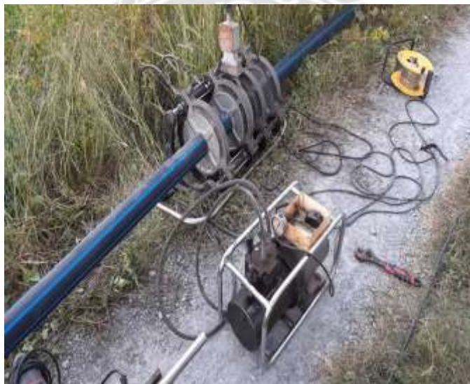
รูปที่ 16 การเชื่อมต่อ PE ด้วยเครื่องไฮโดรลิก
