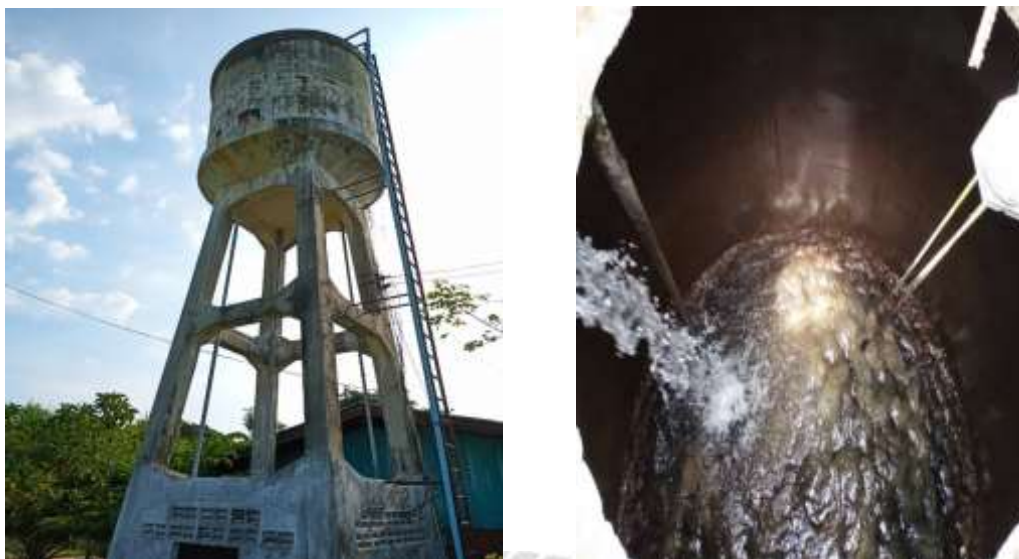
รูปที่ 4.5 ตรวจสอบเขื่อนน้ำบนแท่งค้เมื่อเกิดปัญหาน้ำไหลอน
