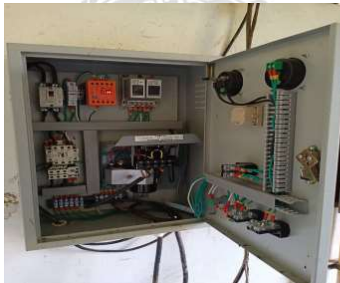
รูปที่ 22 การทำงานของตู้ควบคุมทำงานที่ปกติ
