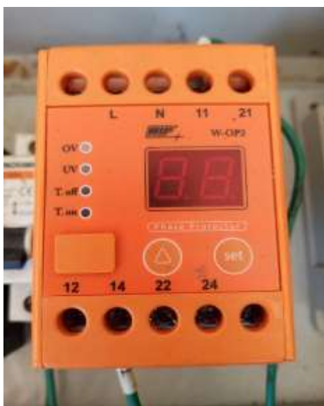
รูปที่ 2.4 เฟสโปรเทคชั่นรีเลย์(Phase Protection Relay)
