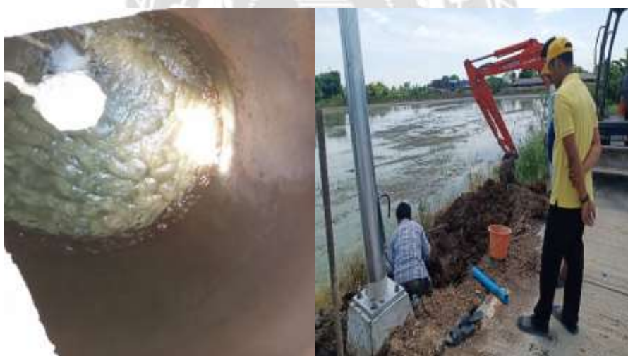
รูปที่ 4.4 ท่อน้ำประปาแตก
