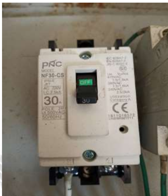
รูปที่ 2.5 Breaker เซอร์กิตเบรกเกอร์ (Circuit Breaker)
