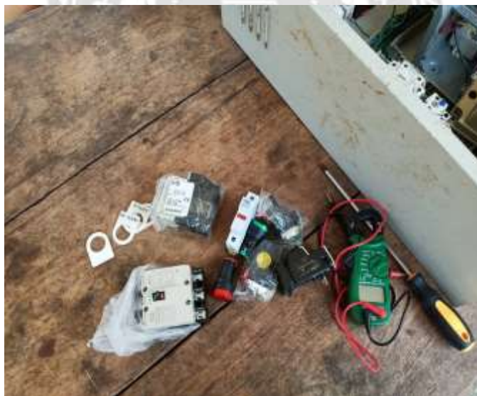
รูปที่ 2 อุปกรณ์ไฟฟ้าที่ติดตั้งในตู้แทนอุปกรณ์ที่เสียหาย
