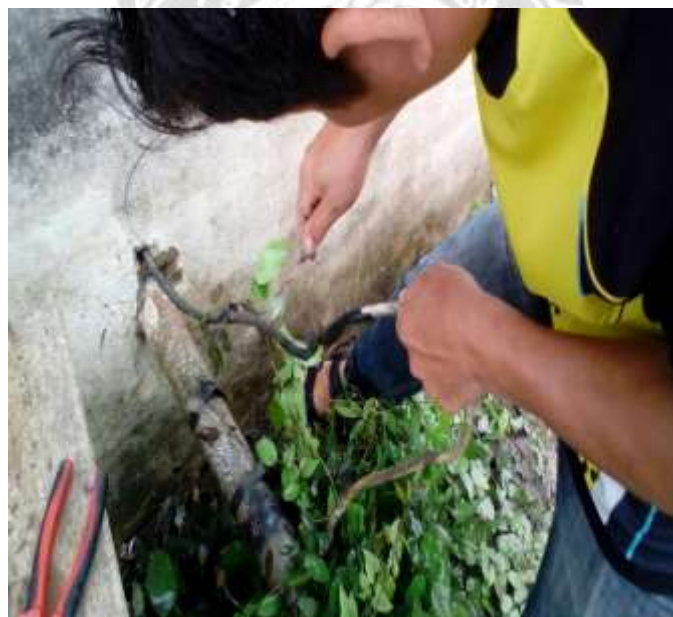
รูปที่ 10 เปลี่ยนสายไฟป้อนน้ำบาดาลที่ชำรุดจากการใช้งานที่เป็นเวลานาน
