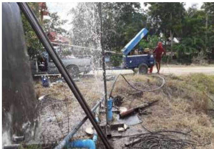
รูปที่ 19 การเป่าอบบาดาลเนื่องจากมีทรายเยอะ
