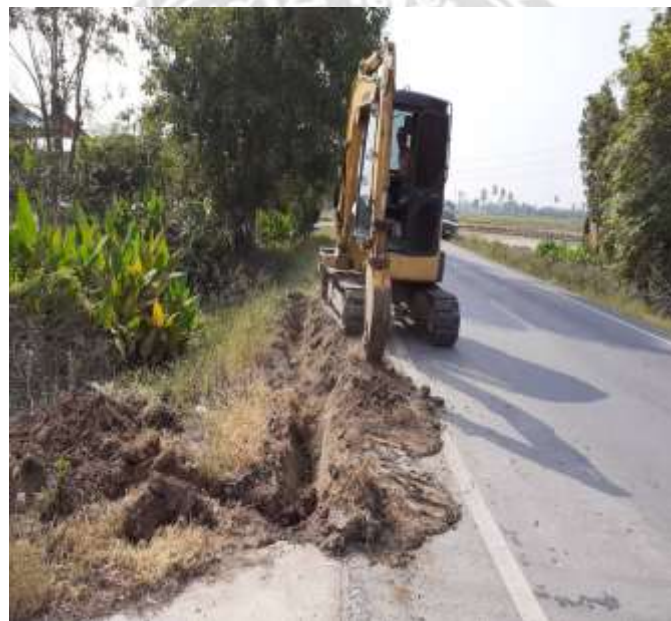
รูปที่ 14 การขุดแนวฝังวางท่อลึกประมาณ 30 เซนติเมตร
