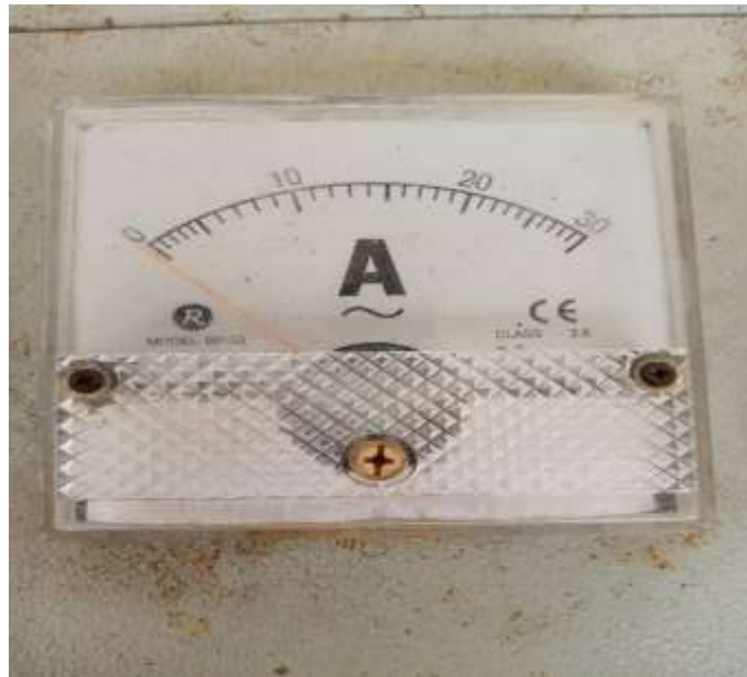
รูปที่ 9 เปลี่ยนแอมมิเตอร์เข็มสเกลไม่ทำงาน
