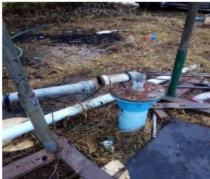
รูปที่ 18 ถอดท่อเพื่อนำปั้มน้ำบาดาลขึ้นมา
