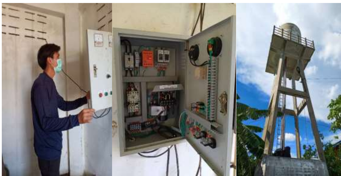
รูปที่ 4.15 การตรวจสอบประจำปี
