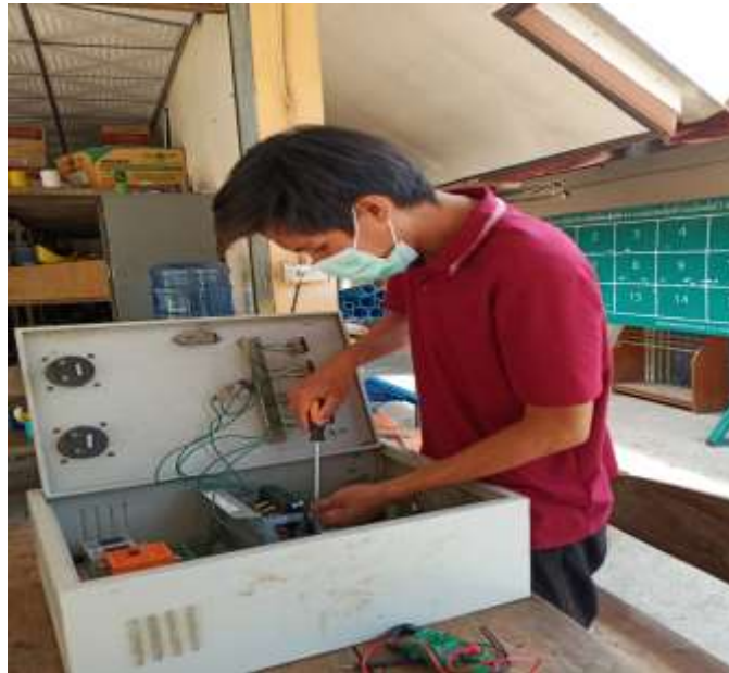
รูปที่ 1 การถอดเปลี่ยนอุปกรณ์ในตู้ที่ชำรุด
