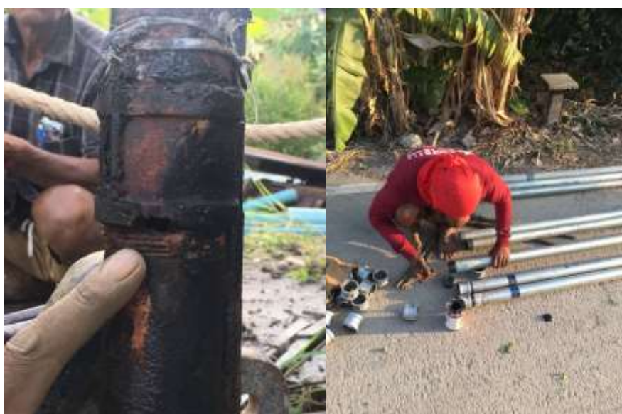
รูปที่ 4.8 เปลี่ยนท่อน้ำบาดาลเมื่อเกิดการทะลุเสียหายตามอายุการใช้งาน
