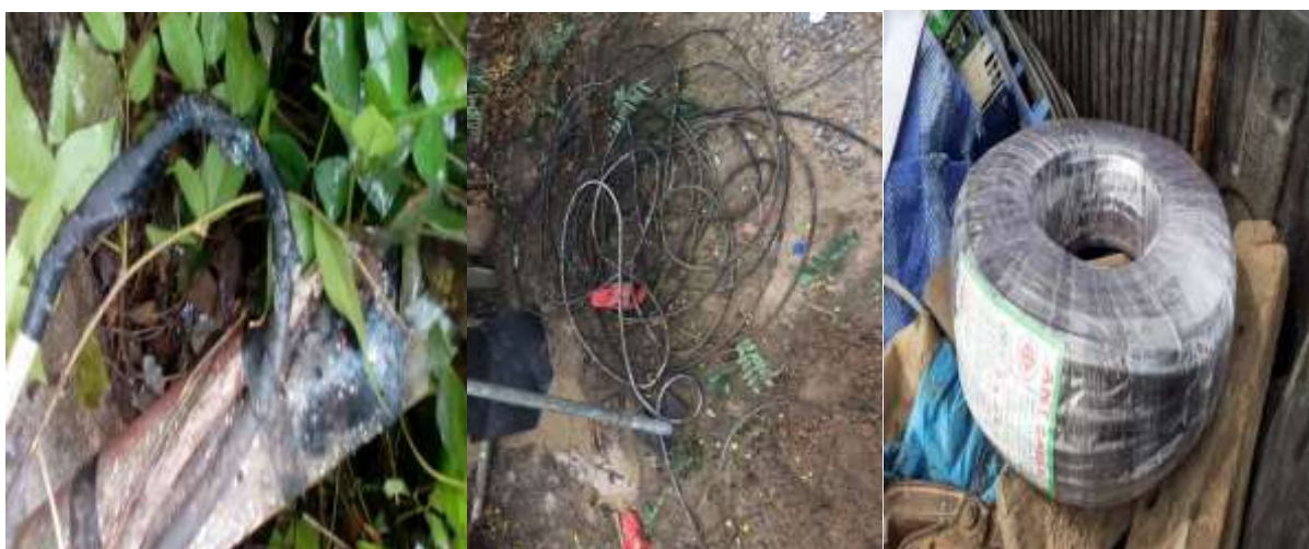
รูปที่ 4.9 สายไฟป้อนน้ำบาดาลชำรุด
