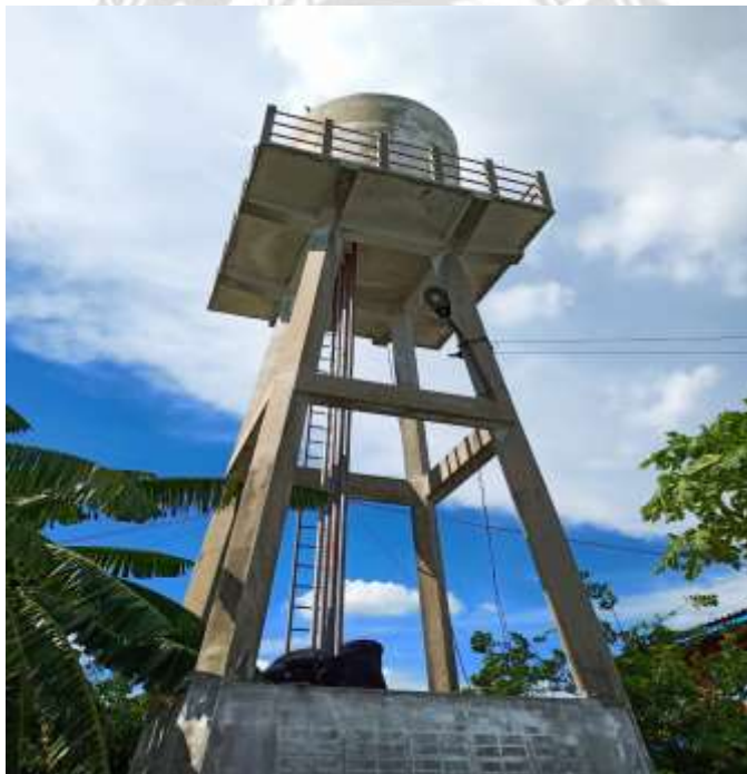
รูปที่ 26 ถังน้ำบาดาลบรรจุน้ำได้ 15 คิวหรือ 15000 ลิตร
