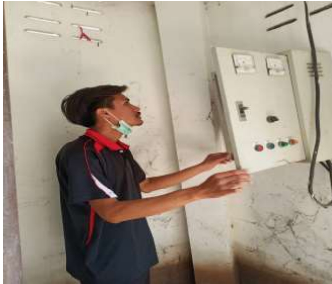
รูปที่ 21 ตรวจสอบการทำงานของตู้ควบคุม
