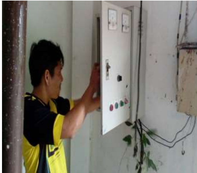
รูปที่ 7 เซ็คอุปกรณ์ไฟฟ้าในตู้ควบคุมที่ไม่ทำงาน
