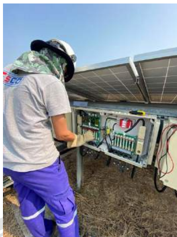
รูปที่ 4.16 การติดตั้งกล่องSSM
