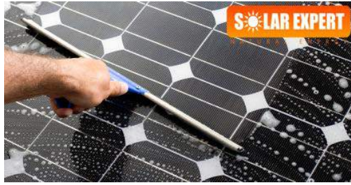
รูปที่ 2.20 แผงที่กำลังทำความสะอาดแบบถูกต้อง
