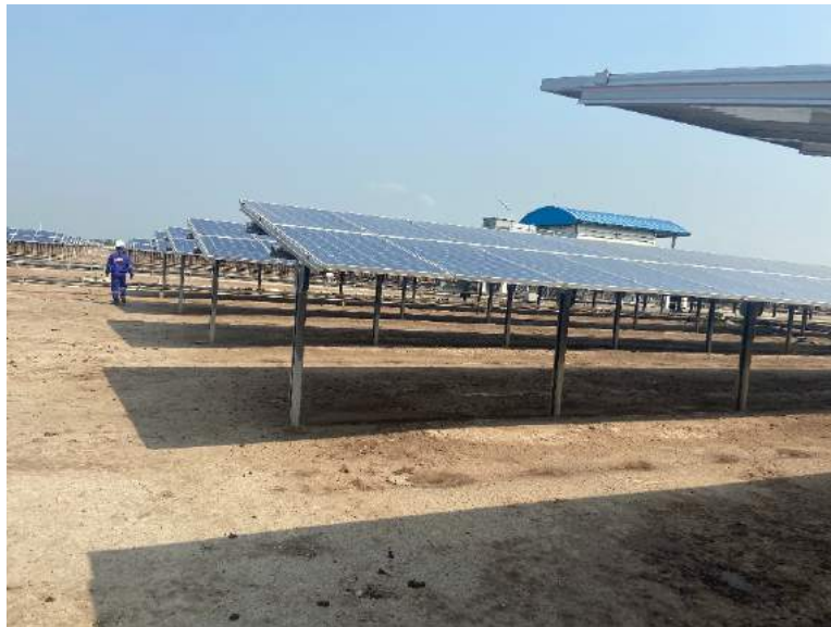
รูปที่ 9 ตรวจสอบความสะอาดแผงโซลาร์เซลล์
