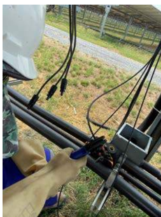
รูปที่ 3 เปลี่ยนสายใต้แผงโซล่าเซลล์เนื่องจากสายโดยปลวกกัด
