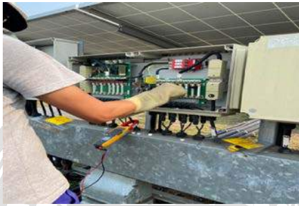
รูปที่ 5 ปลดฟิวส์ในกล่อง ssm แล้วปลดฟิวส์เพื่อทำการเปลี่ยนสาย
