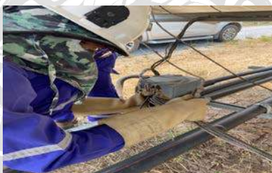
รูปที่ 2 เปลี่ยนสายใต้แผงโซล่าเซลล์เนื่องจากสายโดยปลวกกัด
