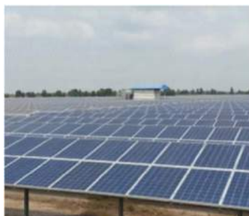
รูปที่ 4.18 แสดงแผงที่ติดตั้งของโรงไฟฟ้าพลังงานแสงอาทิตย์ โซลาร์ โก ไทรเพชร 1
