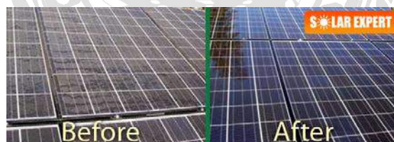
รูปที่ 2.19 แผงโซลาร์เซลล์ตอนยังไม่ทำความสะอาดกับแผงโซลาร์เซลล์ที่ทำความสะอาดแล้ว
