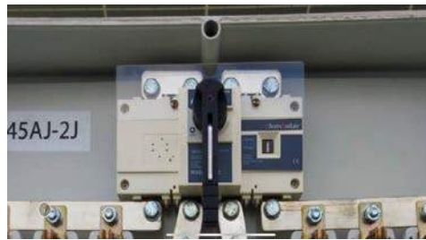
รูปที่ 2.12 เซอร์กิตเบรกเกอร์
