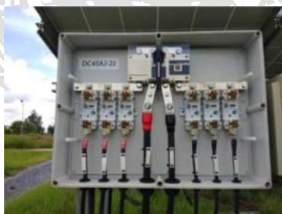
รูปที่ 4.17 การติดตั้งกล่อง AJ Box
