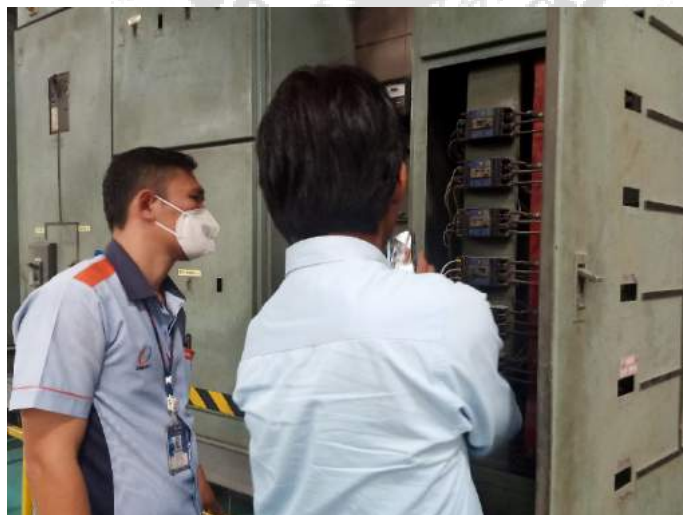
รูปที่ 4.18 ตรวจสอบระบบตู้ไฟฟ้า
