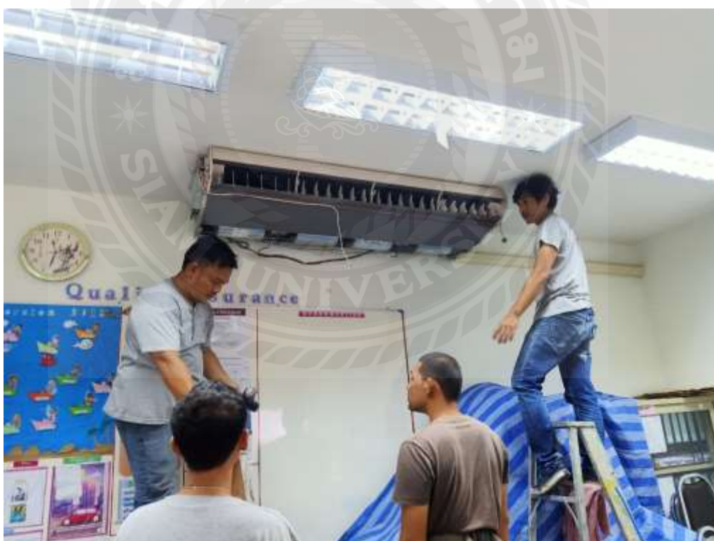
การควบคุมดูแลช่างภายนอกในการเซอร์วิสล้างเครื่องปรับอากาศภายในสำนักงาน
