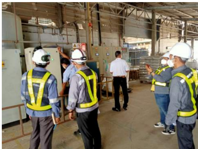
รูปที่ 4.17 ตรวจสอบเครื่องจักรที่ใช้พลังงานไฟฟ้า
