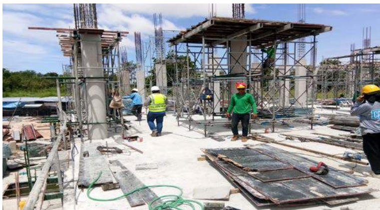
รูปที่ 4 ตรวจ Progress โครงสร้าง
