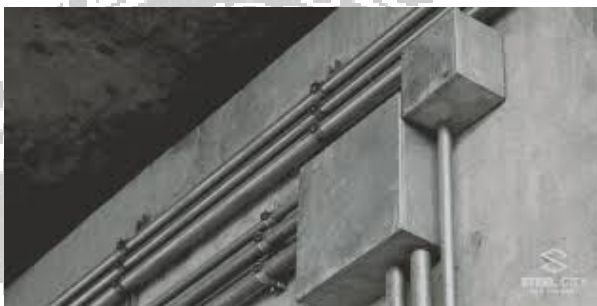
รูปที่ 2.23 กล่องดึงสายชนิดดึงตรง
