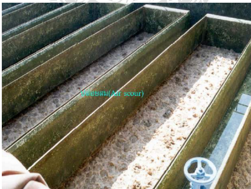
รูปที่ 3.23 ล้างย้อนด้วยลม
