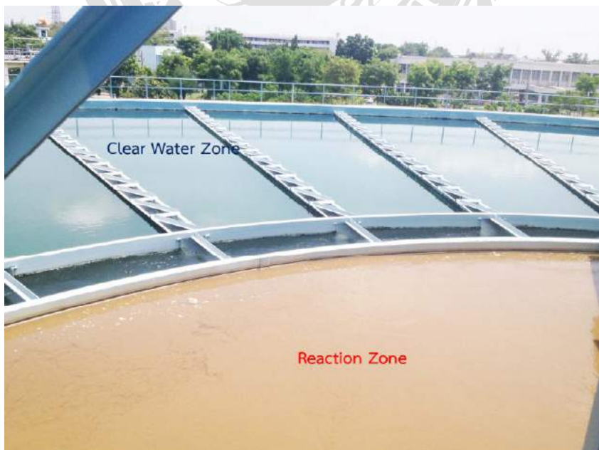
รูปที่ 3.18 Reaction Zone and Clear Water Zone[2]
