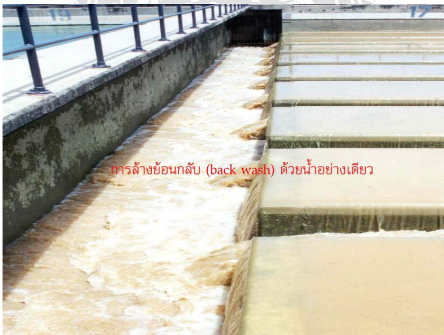
รูปที่ 3.25 ล้างย้อนด้วยน้ำ
