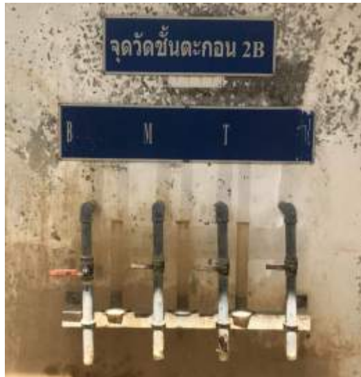
รูปที่ 3.19 จุดวัดตะกอน
