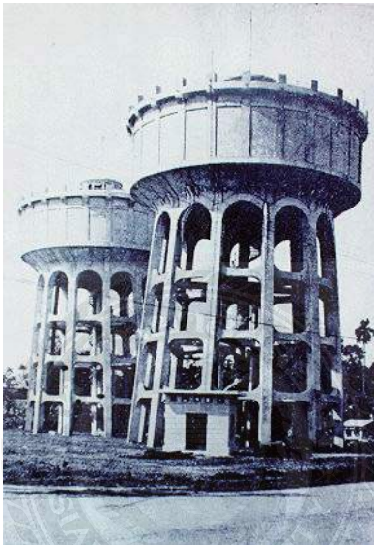
รูปที่ 2.3 ถังช่วยแรงส่งน้ำรูปหอคอย 2 ถัง[4]
