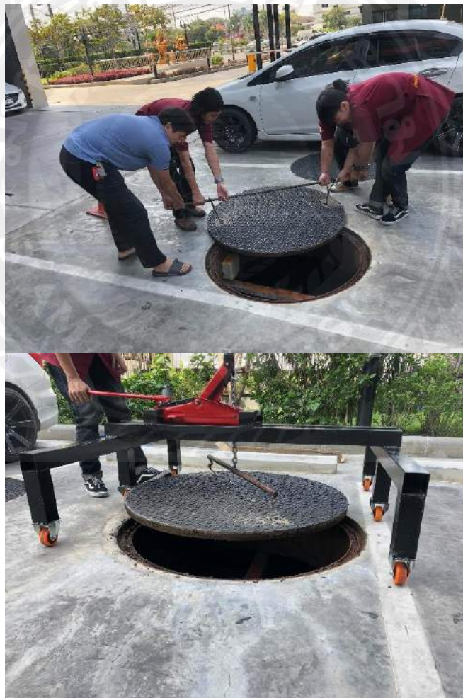
รูปที่ 4.1 การยกฝาแม่แรงก่อนและหลังมีอุปกรณ์
