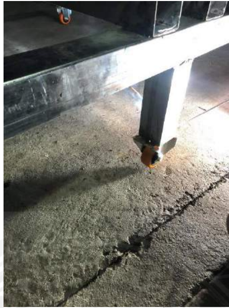
รูปที่ 3.26 การตัดล้อยื่นงาน
