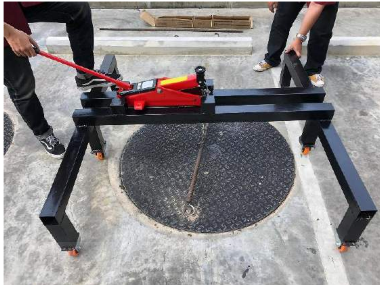
รูปที่ 4.6 การปิดฝาท่อบำบัดน้ำเสีย
