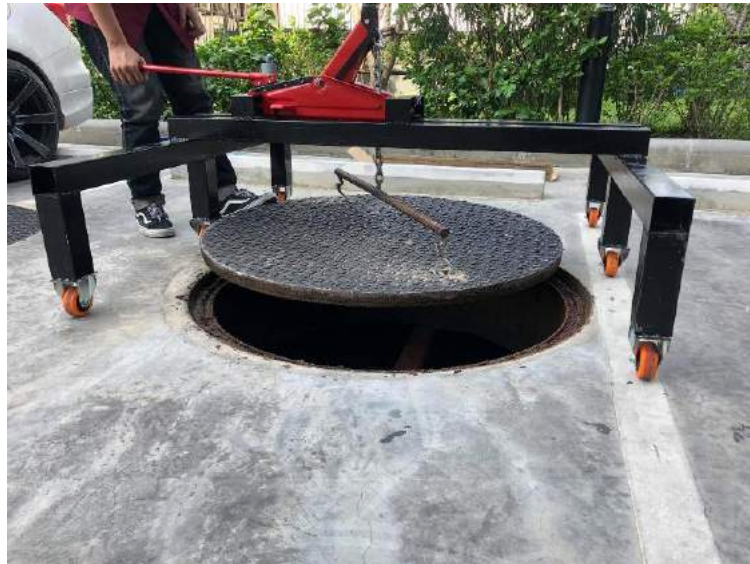
รูปที่ 4.4 การปั๊มแม่แรง
