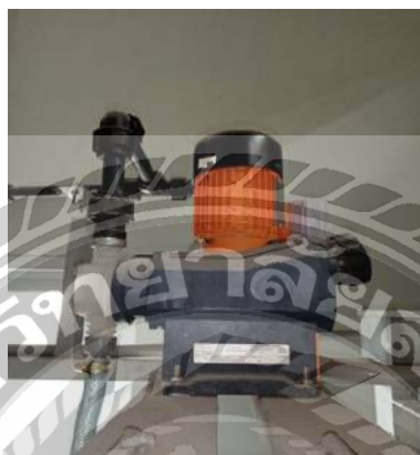
รูปที่ 3.7 METERING PUMP
