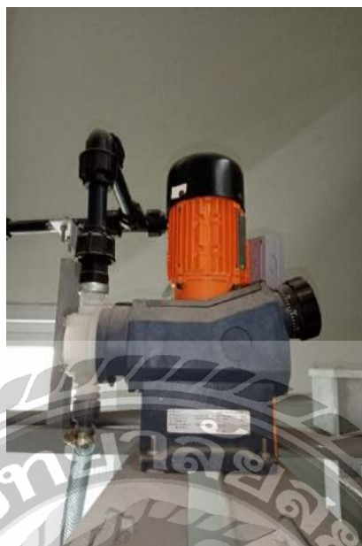
รูปที่ 4.18 Agitator or Mixer Pump
