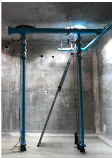
รูปที่ 4.15 การติดตั้ง Submersible Pump แบบแช่น้ำ
