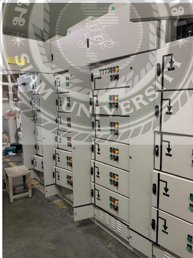
รูปที่ 4.19 Motor Control Center
