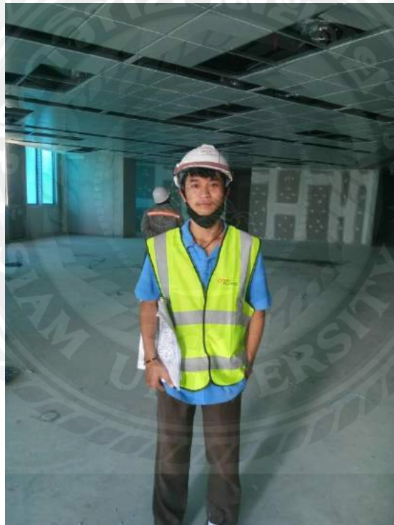
ขณะตรวจสอบตำแหน่งในการติดตั้งท่อ
