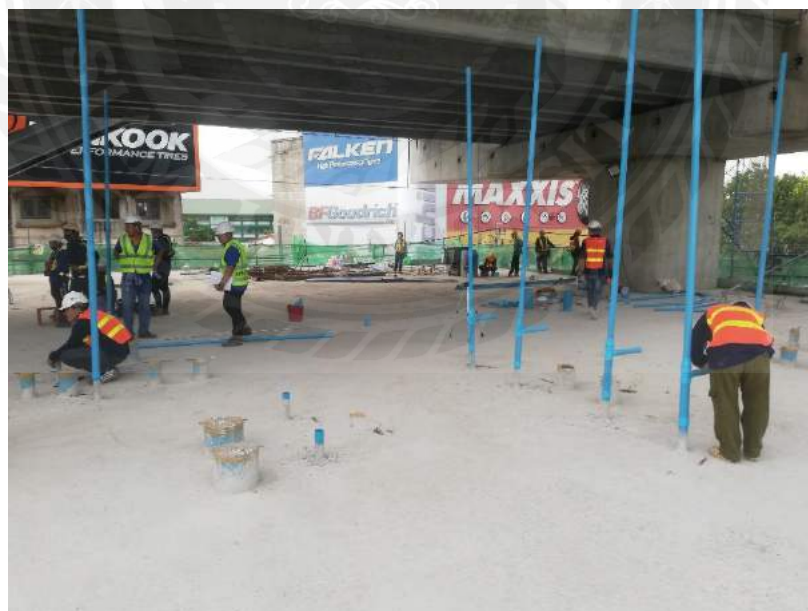
รูปที่ 4.22 ขณะตรวจงานการวางท่อฝังพื้น
