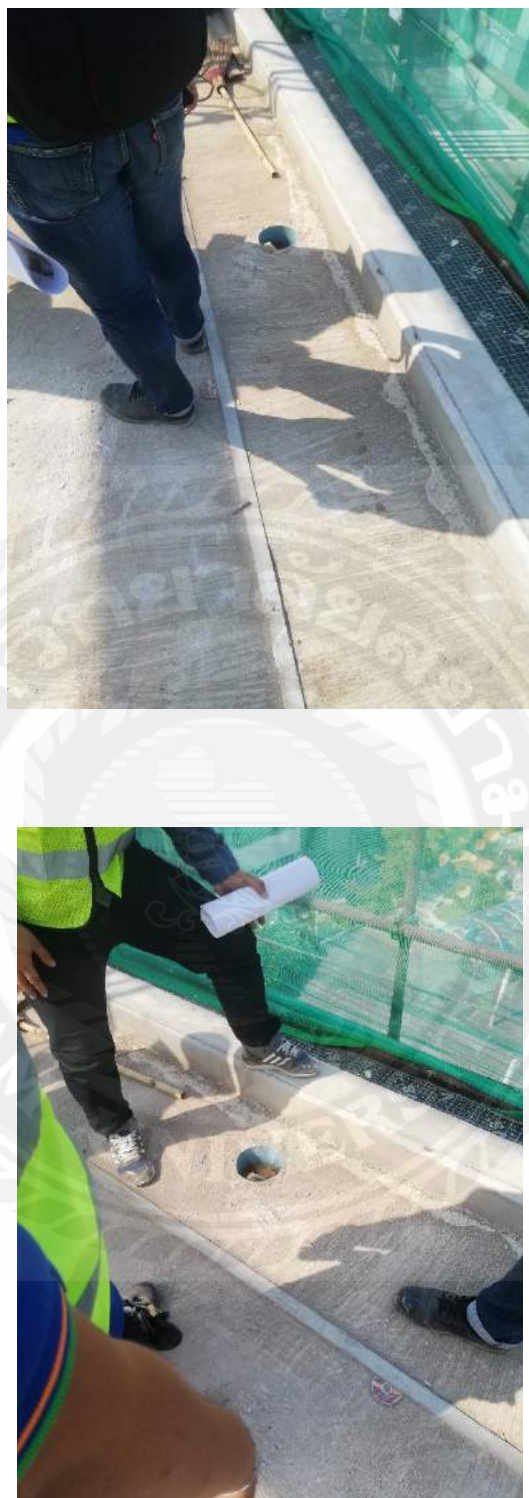
รูปที่ 4.23 ขณะแก้ไขงานวางท่อฝังพื้น
