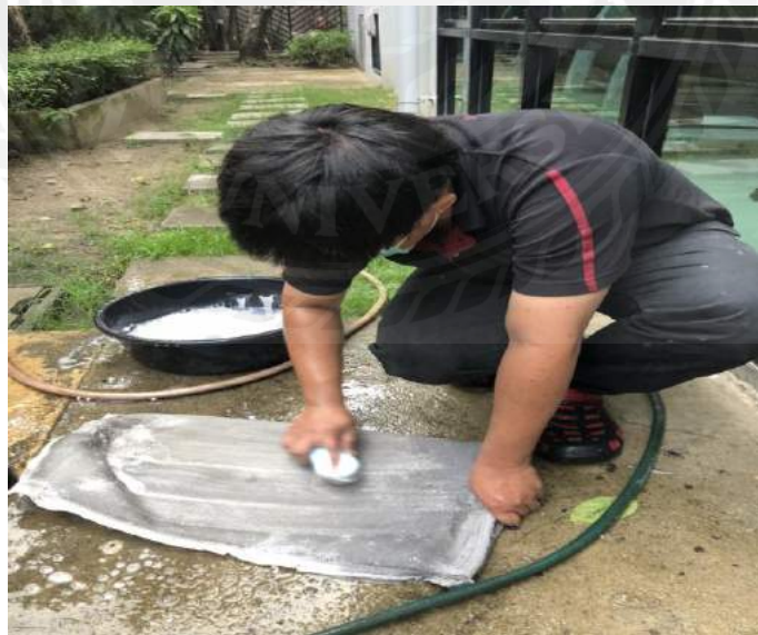
รูปที่ 3.29 การซักถุงผ้ากรองสระว่ายน้ำสกินเมอร์
