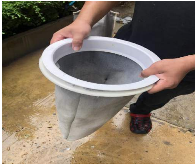
รูปที่ 3.30 กรองสระว่ายน้ำสгимเมอร์
