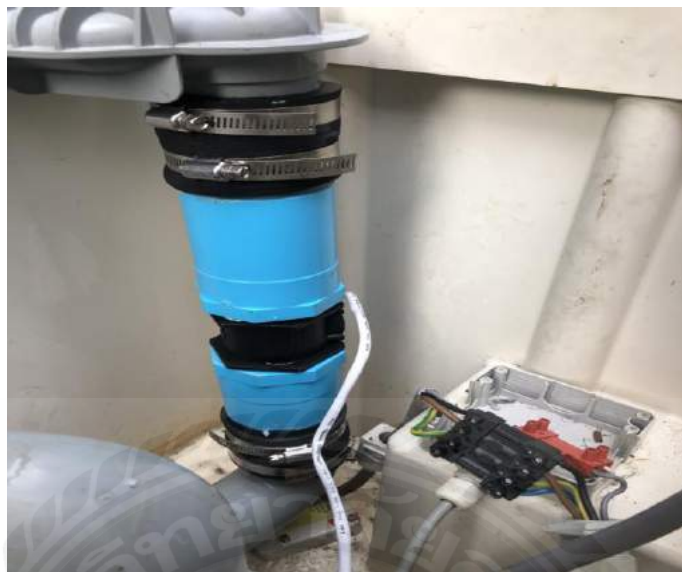
รูปที่ 3.22 สวิตซ์การไหลแบบใบพัดที่ติดตั้งไปที่ตัวอุปกรณ์ปั้มน้ำ
