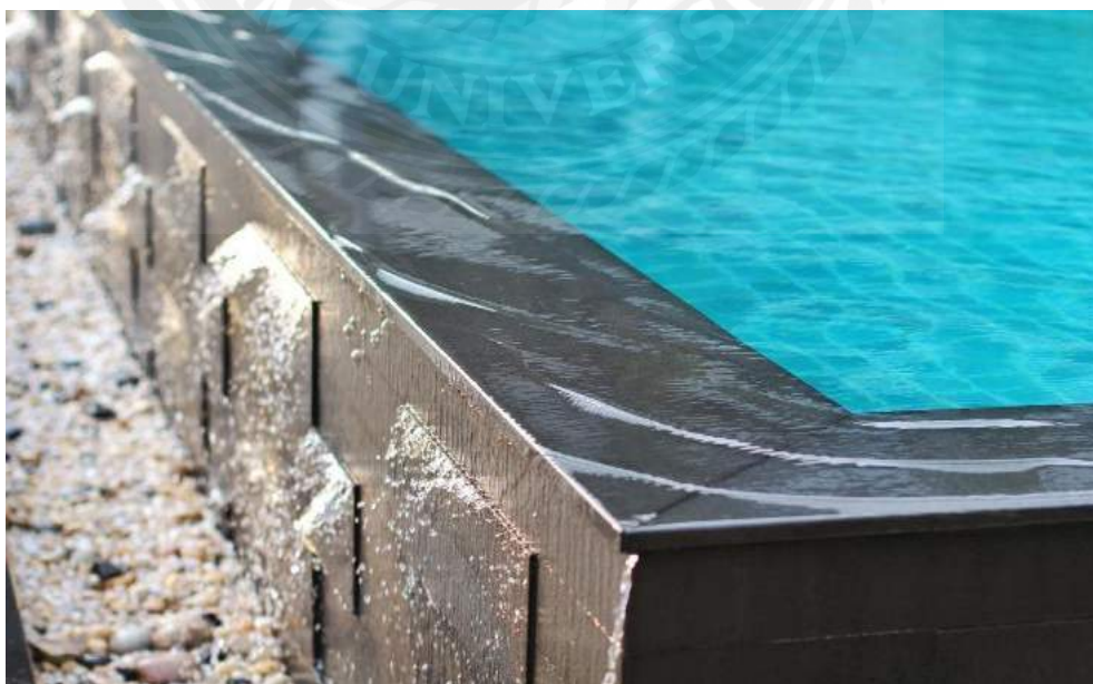
รูปที่ 2.6 ภาพจริงระบายน้ำระบบน้ำล้น
