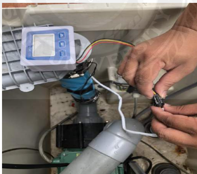
รูปที่ 3.23 ประกอบหน้าปิดดิจิทัลแบบพกพาเข้ากับสวิตซ์การไหลแบบใบพัด
