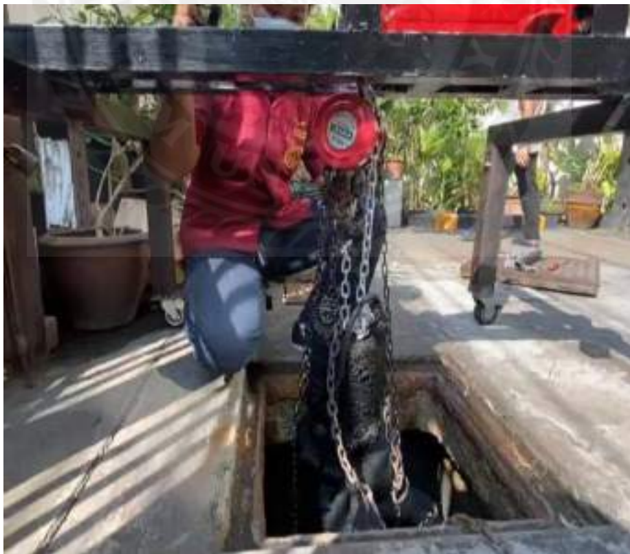
รูปที่ 4.18 การยกปั๊มขึ้นจากบ่อบำบัด
