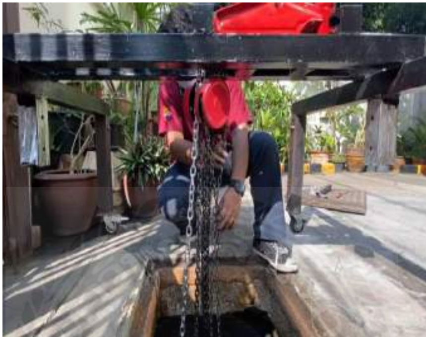
รูปที่ 4.9 การติดตั้งรอกโซ่มือสาว
