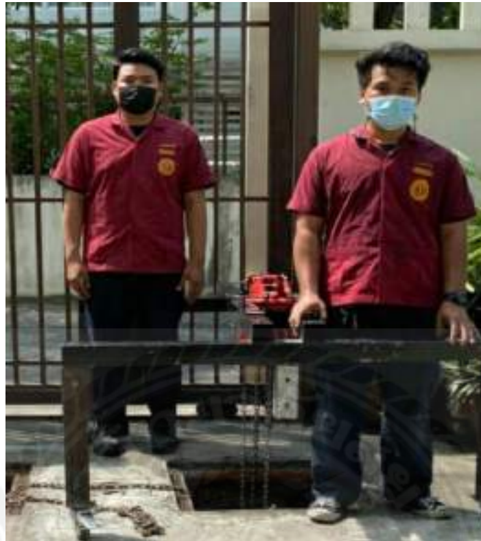
รูปการแต่งการขณะปฏิบัติงานงานในพื้นที่อาคาร
