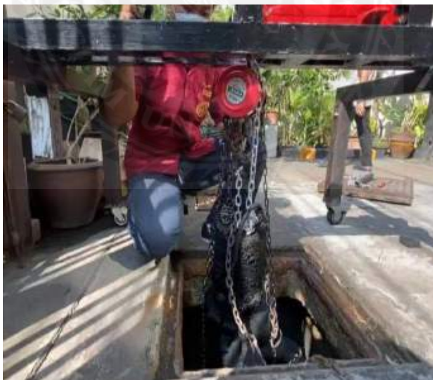
รูปที่ 4.10 ใช้รอกโซ่ยกปั๊มเขในบ่อบำบัดขึ้นมาซ่อมบำรุง
