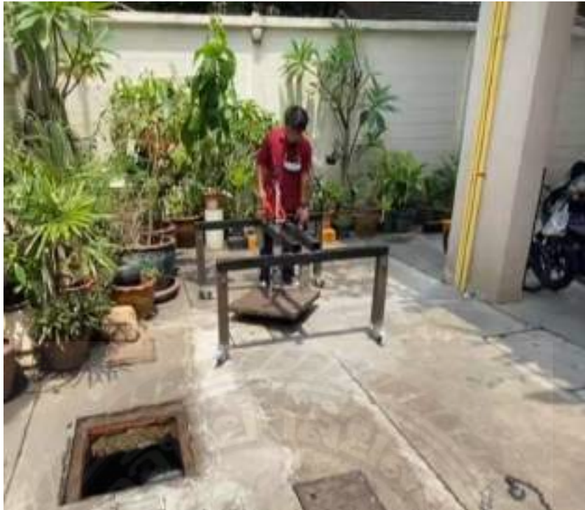
รูปที่ 4.19 การนำอุปกรณ์ยกฝาท่อมาปิดบ่อน้ำบาด
