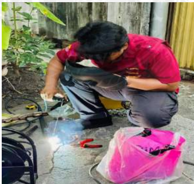
รูปที่ 3.50 การเชื่อมโซ่เหล็กเข้ากับท่อเหล็กดำ
