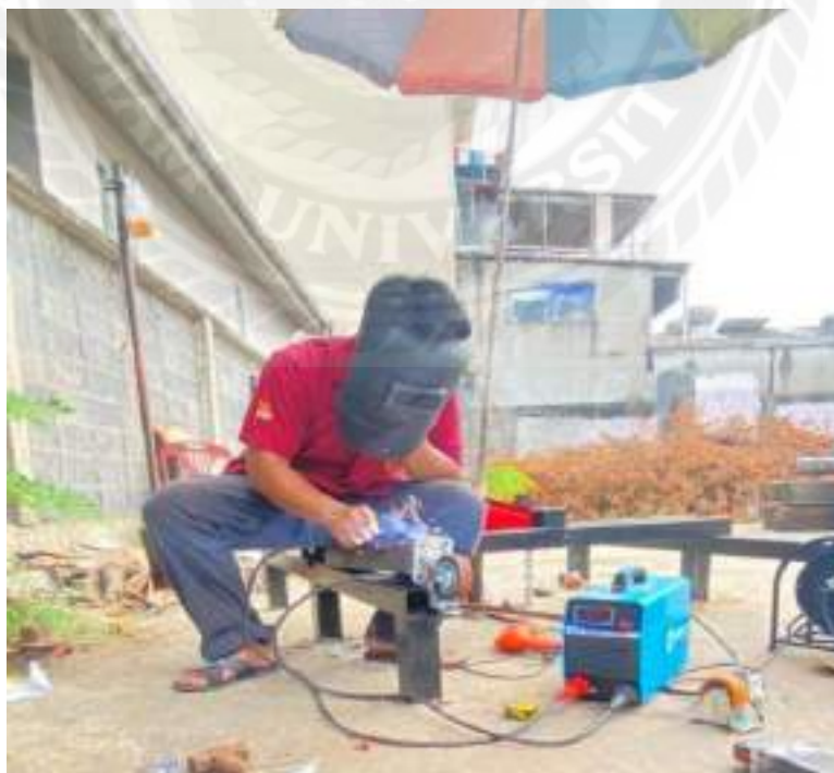
รูปที่ 3.44 การเชื่อมล๊อกับเหล็กกล่อง
