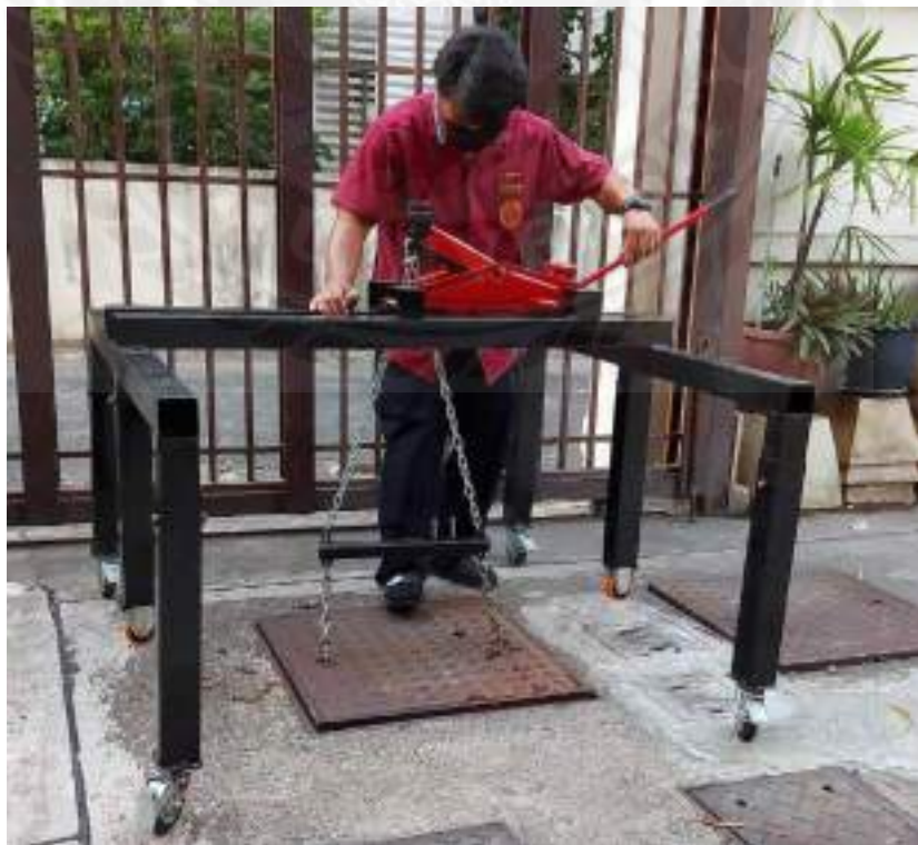
รูปที่ 4.20 การปล่อยแม่แรงเพื่อปิดฝาบ่อน้ำบาด
