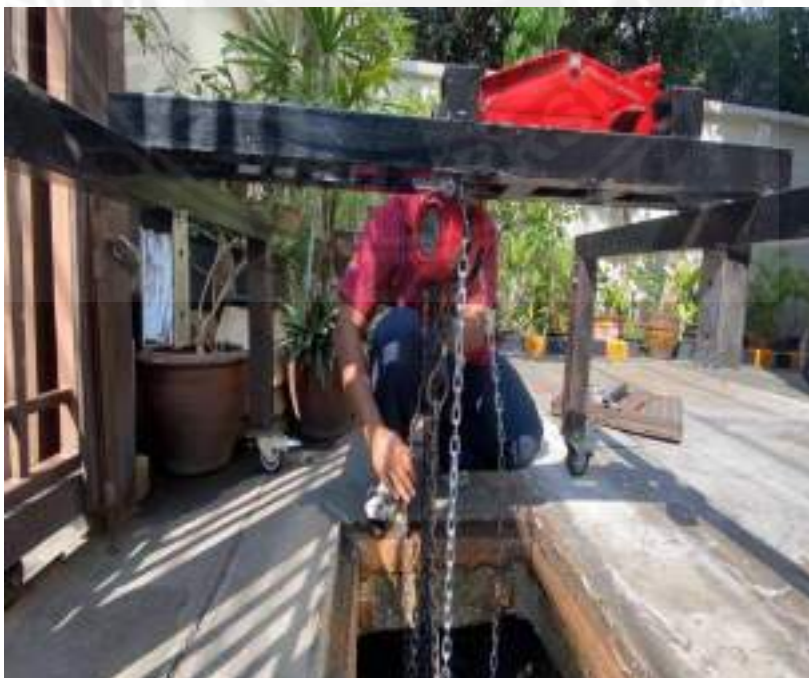
รูปที่ 3.54 การติดตั้งรอกโซ่มือสาว
