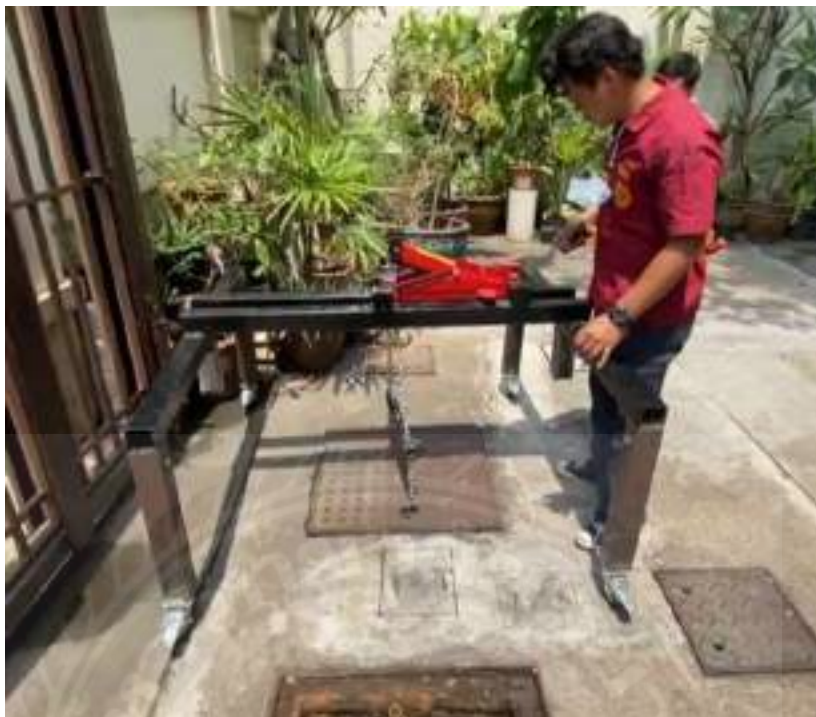
รูปที่ 4.11 การนำอุปกรณ์ไปคร่อมที่ฝาบ่อบำบัดที่ต้องการเปิด
