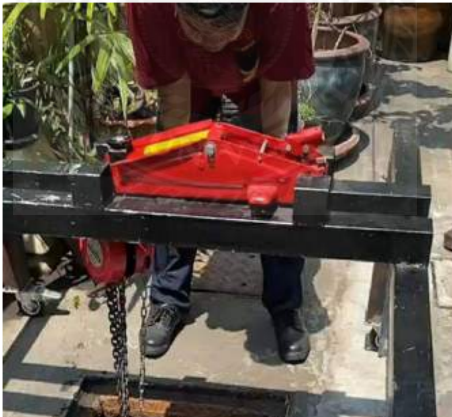
รูปที่ 4.16 การติดตั้งรอกโซ่
