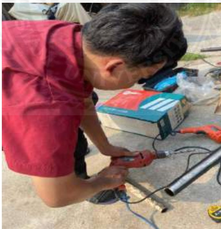
รูปที่ 3.48 การเจาะรูท่อเหล็กดำและตาปเกลียว
