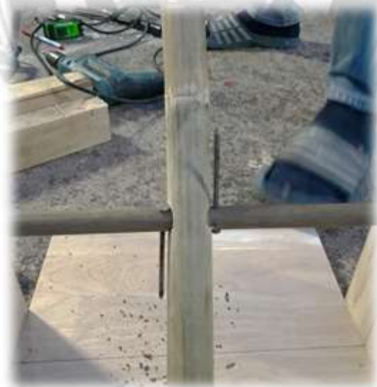
รูปที่ 4.19 ตอกตะปูตอกไม้ขนาด 2 นิ้ว ตรงรูที่ทำการเจาะไว้ ที่มา : ผู้จัดทำ (2564)
