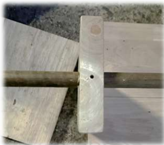
รูปที่ 4.20 เจาะแผ่นไม้ B กับแท่งไม้ C ให้มีรูตรงกันเพื่อที่จะยึดตะปูเกลียว ที่มา : ผู้จัดทำ (2564)
