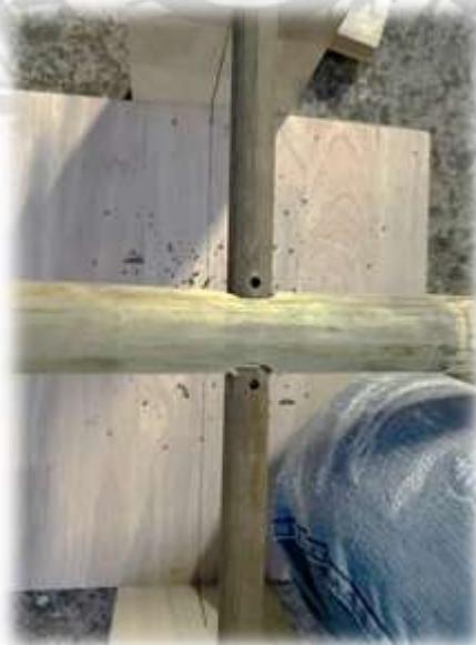
รูปที่ 4.17 เจาะไม้แท่ง C ที่จะใส่ตะปูตอกไม้ เพื่อให้ไม้ไม่ไผ่ขยับ
