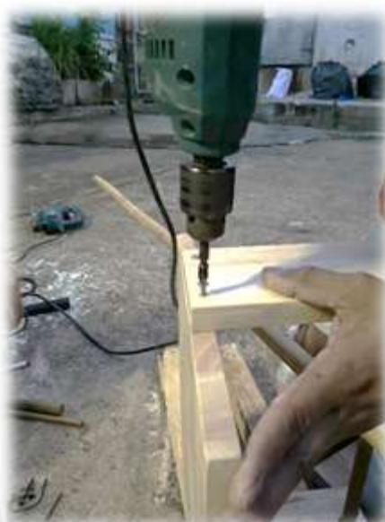
รูปที่ 4.16 นำแผ่นไม้ A กับ B ประกอบเข้าด้วยกัน โดยใช้ตะปูเกลียว ขนาด 1 นิ้ว เป็นตัวยึด
