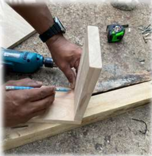
รูปที่ 4.9 วัดขนาดแผ่นไม้ B ทั้งสองแผ่น เพื่อทำการเจาะรูที่จะใส่ตะปู ที่มา : ผู้จัดทำ (2564)
