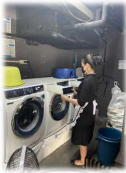
ภาพขณะปฏิบัติงาน Laundry Room (ดูแลทำความสะอาด ชัก อบ ริด ผ้า)
