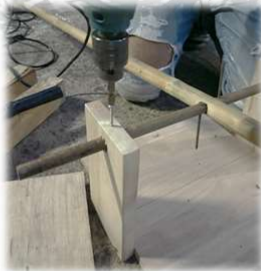
รูปที่ 4.21 ยึดแผ่นไม้ B กับแท่งไม้ C ด้วยตะปูเกลียว ที่มา : ผู้จัดทำ (2564)
