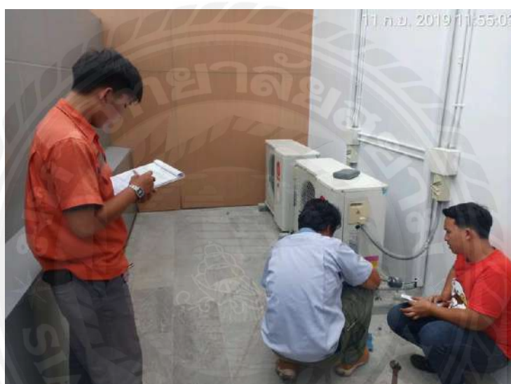
รูปที่ 3.21 ขณะตรวจสอบระบบปรับอากาศ
