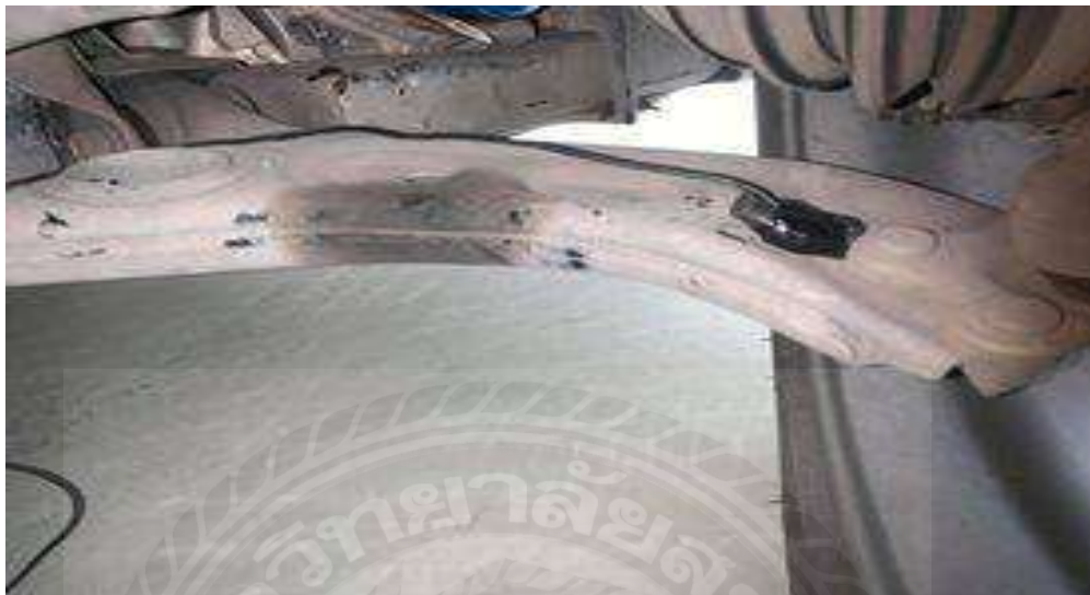
รูปที่ 3.11 การติดตั้งเครื่องวิเคราะห์เสียงผิดปกติส่วนปีกนกข้างขวา
