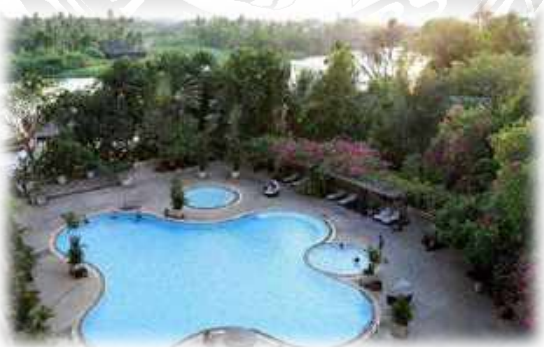
รูปที่ 2.12 สระว่ายน้ำระบบโอโซน
