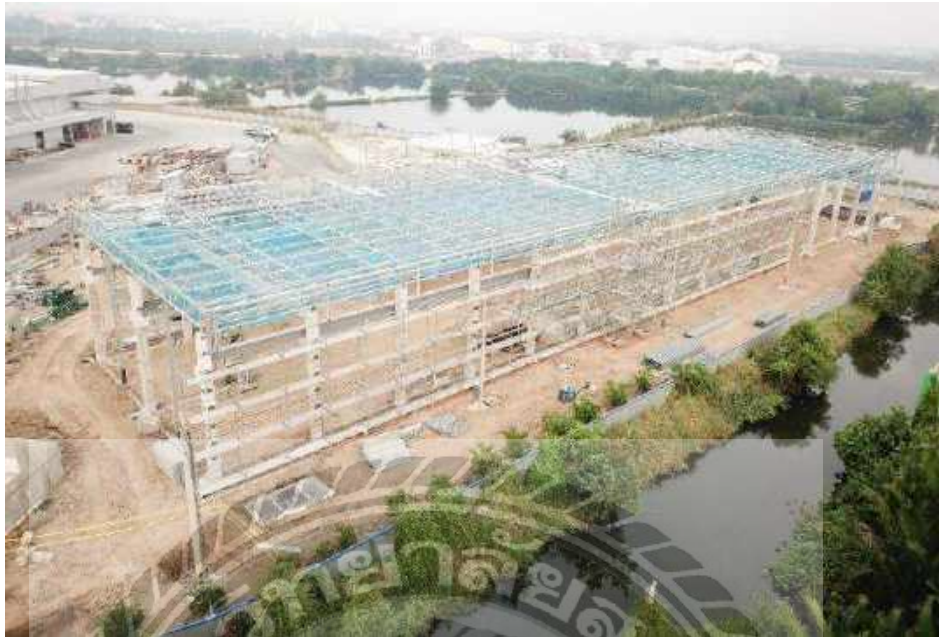
รูปที่ 3.54 แสดงการยกโครงถักหลังคาแล้วเสร็จทั้งหมด
