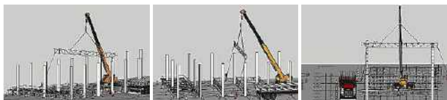
รูปที่ 3.28 แสดงการย้ายโครงถักจากรถบรรทุกเพื่อประกอบ ณ ตำแหน่งเตรียมยก (ต่อ)
