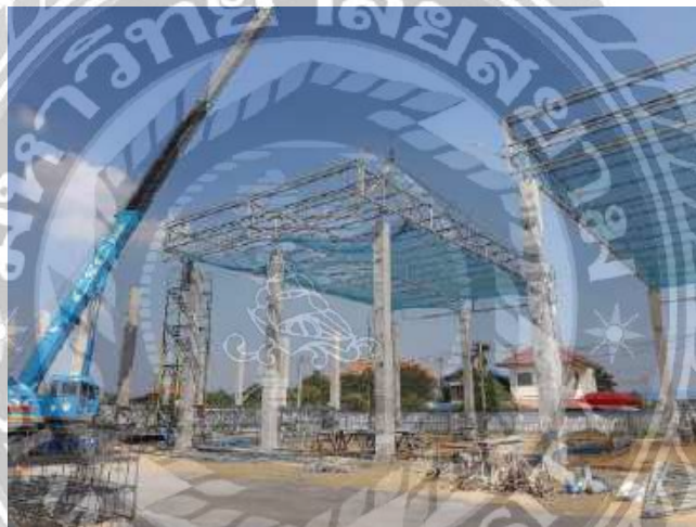
รูปที่ 3.49 แสดงการยกโครงถักหลังคาแบบกลุ่มหรือ ช่วง (3)
