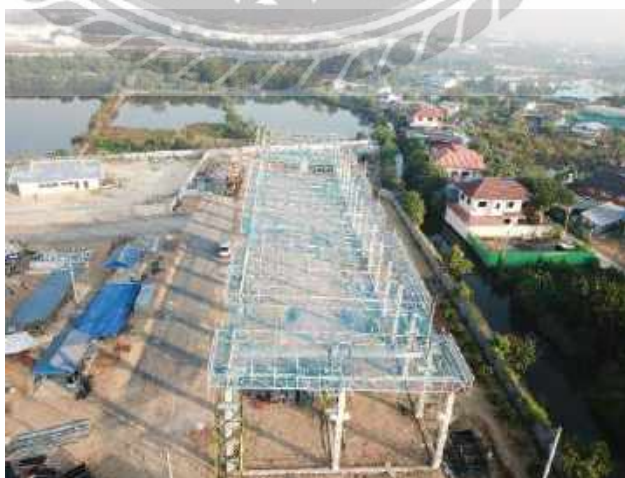
รูปที่ 3.53 แสดงการยกโครงถักหลังคาแบบกลุ่มหรือ ช่วง (7)
