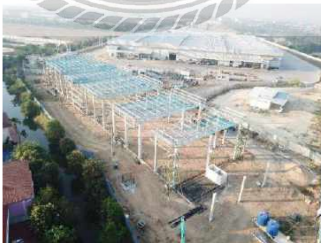
รูปที่ 3.50 แสดงการยกโครงถักหลังคาแบบกลุ่มหรือ ช่วง (4)
