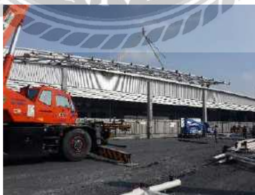
รูปที่ 3.10 ภาพแสดงการยกโครงถักลงเพื่อจัดเก็บและแยกเบอร์โครงถักไว้เพื่อง่ายต่อการติดตั้ง (วันที่ 1)
