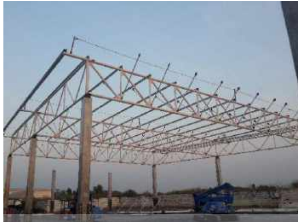
รูปที่ 3.14 ระหว่างติดตั้งแป (Purlin) (วันที่ 3)
