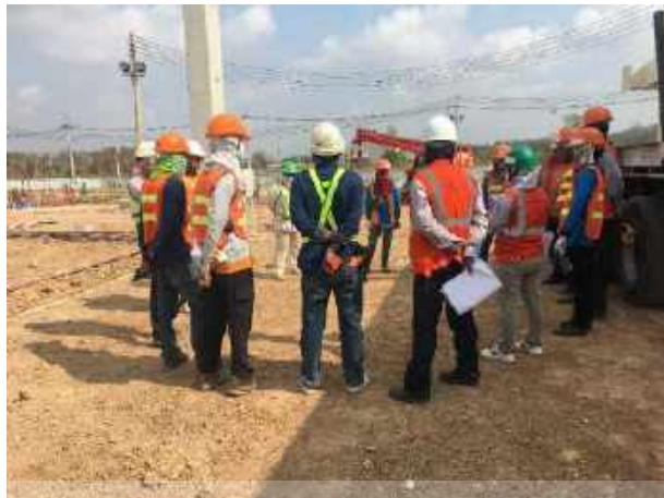
รูปที่ 3.46 การประชุมติดตั้ง ก่อนทำการยกโครงถักหลังคา
