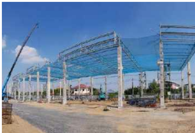
รูปที่ 3.51 แสดงการยกโครงถักหลังคาแบบกลุ่มหรือ ช่วง (5)
