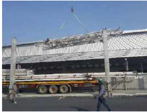
รูปที่ 3.11 ภาพแสดงการยกโครงถักลงเพื่อจัดเก็บและแยกเบอร์โครงถักไว้เพื่อง่ายต่อการติดตั้ง (วันที่ 1) (ต่อ)
