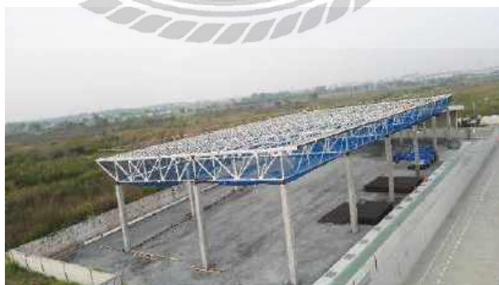
รูปที่ 3.19 สิ้นสุดขั้นตอนในการติดตั้งโครงถักหลังคา (วันที่ 6)
