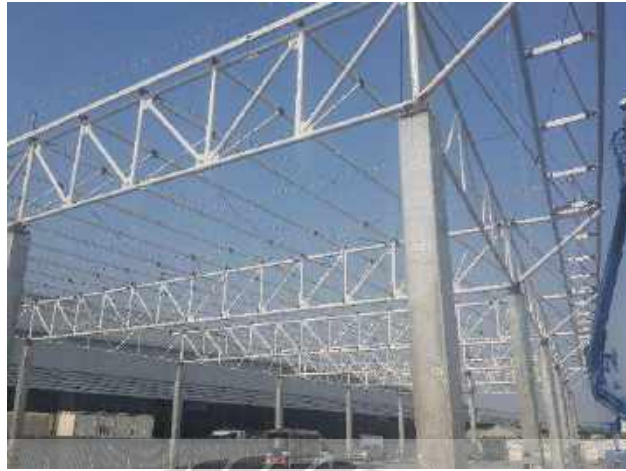
รูปที่ 3.17 การติดตั้งโครงถักหลังคาแล้วเสร็จ (วันที่ 5) (ต่อ)
