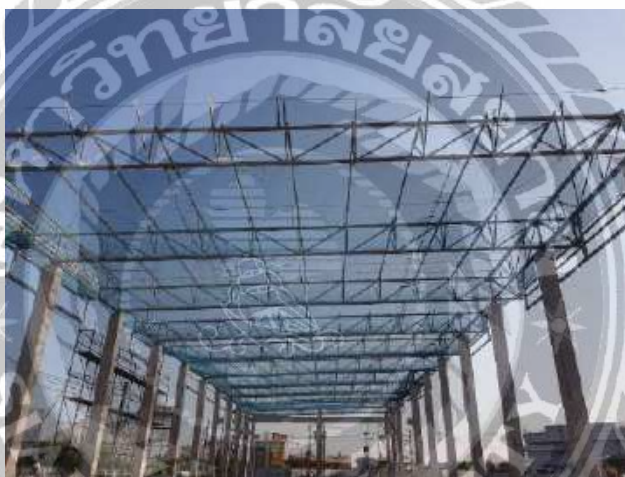
รูปที่ 3.52 แสดงการยกโครงถักหลังคาแบบกลุ่มหรือ ช่วง (6)
