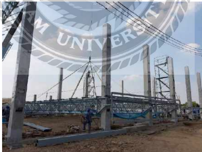
รูปที่ 3.47 แสดงการยกโครงถักหลังคาแบบกลุ่มหรือ ช่วง (1)
