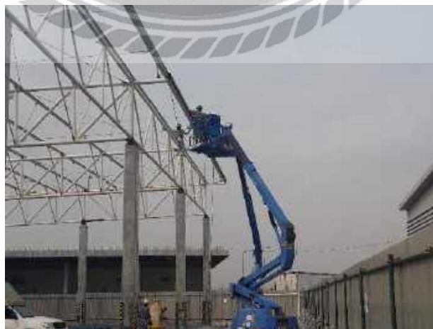
รูปที่ 3.16 การติดตั้งโครงถักหลังคาแล้วเสร็จ (วันที่ 5)
