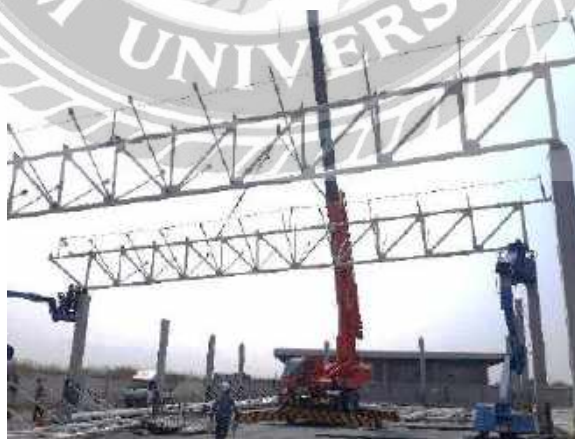
รูปที่ 3.13 เริ่มการติดตั้ง Main of Truss (วันที่ 2) (ต่อ)
