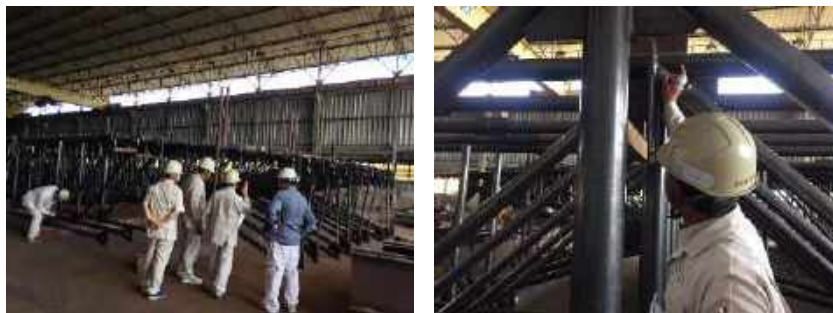
รูปที่ 3.37 ตรวจสอบสภาพ รูปทรง ความโค้ง บิดงอ รอยเชื่อม และอื่นๆโดยทั่วไปของโครงสร้างเหล็ก
