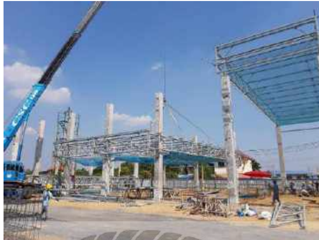
รูปที่ 3.48 แสดงการยกโครงถักหลังคาแบบกลุ่มหรือ ช่วง (2)
