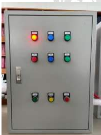
รูปที่ 4.9 ไฟสถานะ Stop ก่อนกลับทางหมุน
