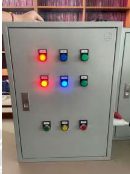
รูปที่ 4.44 ไฟสถานะ K2 ทำงานร่วมกับ K1 หลังจากหน่วงเวลา 5 sec ( PLC )
