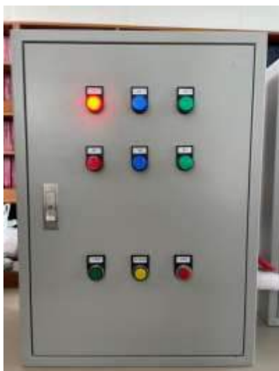
รูปที่ 4.7 ไฟสถานะก่อน Start วงจร Revers After Stop
