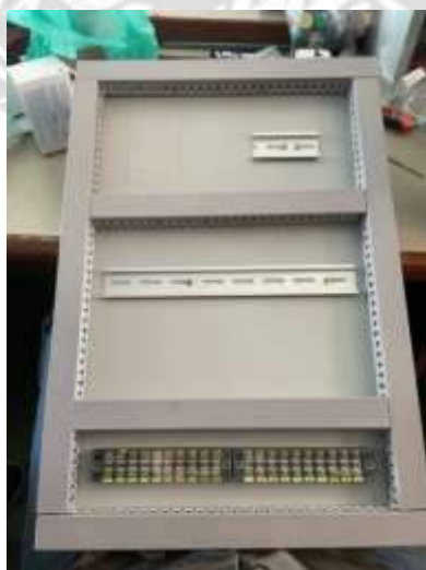
รูปที่ 3.9 ติดตั้งอุปกรณ์ ( รางอุปกรณ์ในตู้/ รางสายไฟ )
