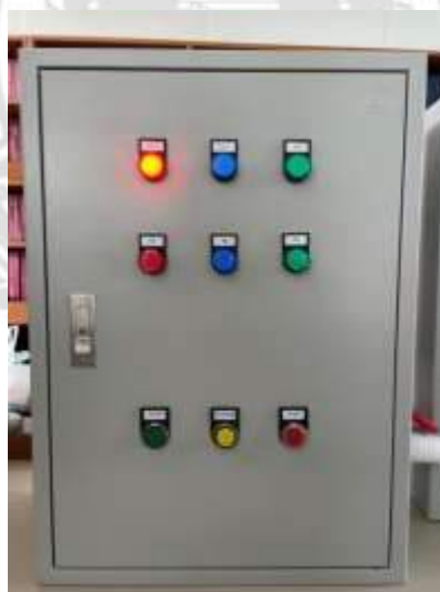
รูปที่ 4.18 ไฟสถานะก่อน Start วงจร Star - Delta Starting
