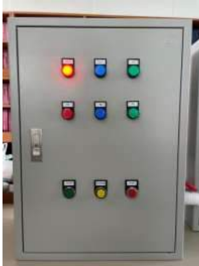
รูปที่ 4.25 ไฟสถานะก่อน Start วงจร DirectStar ( PLC )
