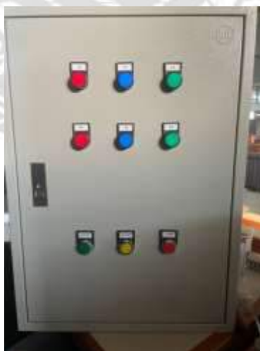
รูปที่ 3.7 ติดตั้งอุปกรณ์หน้าตู้
