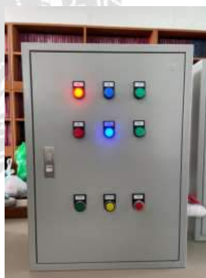
รูปที่ 4.10 ไฟสถานะ K2 ทำงานเมื่อกด Forward
