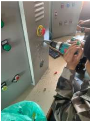
รูปที่ 3.6 เจาะรูข้างตู้เพื่อติดตั้งอุปกรณ์
