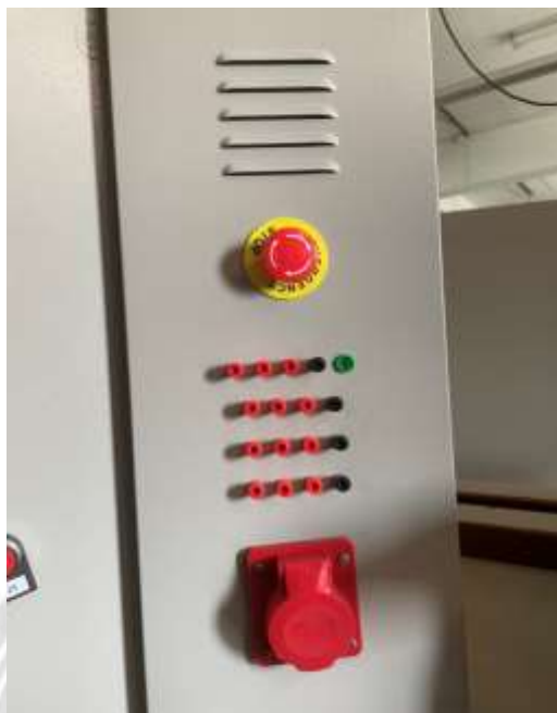
รูปที่ 3.8 ติดตั้งอุปกรณ์ข้างตู้
