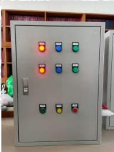
รูปที่ 4.26 ไฟสถานะ K1 ทำงานเมื่อ Start ( PLC )
