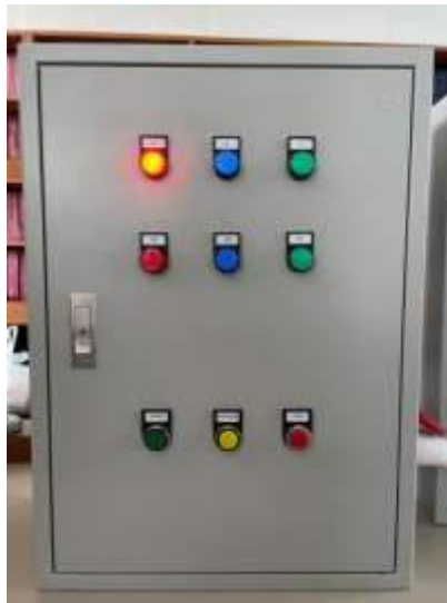
รูปที่ 4.3 ไฟสถานะก่อน Start วงจร DirectStart
