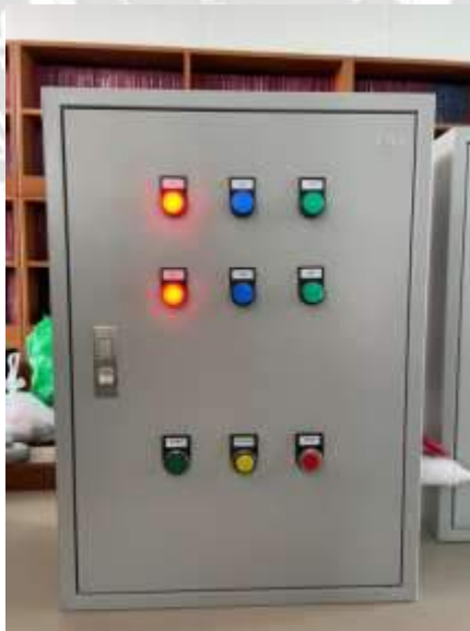
รูปที่ 4.43 ไฟสถานะ K1 ทำงานเมื่อกด Start ( PLC )
