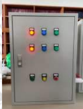
รูปที่ 4.33 ไฟสถานะ K1 ทำงานเมื่อกด Forward ( PLC )
