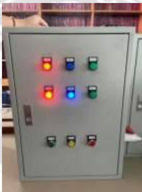
รูปที่ 4.53 ไฟสถานะ K1 , K2 ทำงานเมื่อกด Start ( PLC ) ( Run Star )
