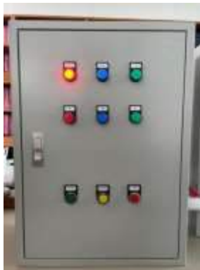
รูปที่ 4.52 ไฟสถานะก่อน Start วงจร Star - Delta Starting ( PLC )
