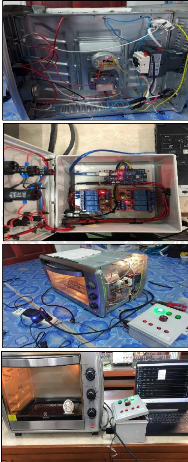
รูปที่ 3.2 การติดตั้งตู้ไมโครคอนโทรลเลอร์
