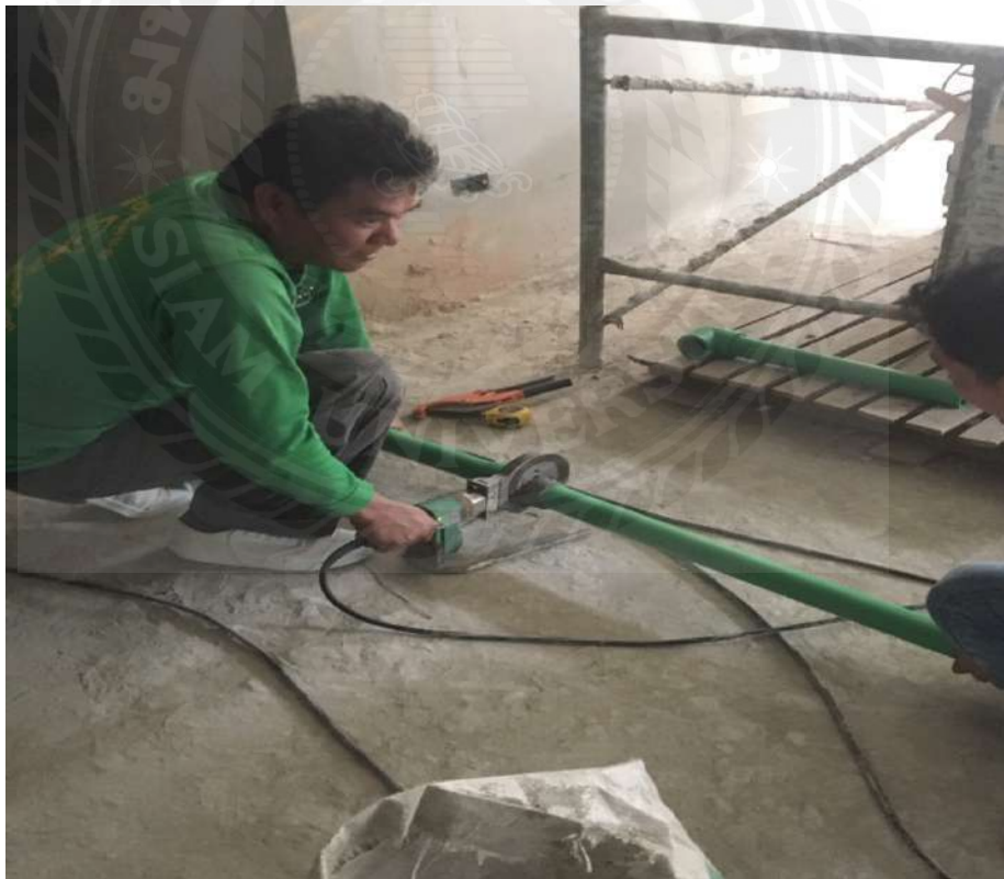
รูปที่ 2 ขั้นตอนตอนการเชื่อมต่อ PPR
