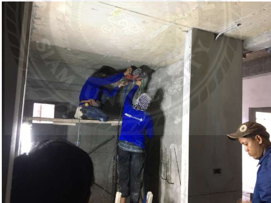
รูปที่ 4 ขั้นตอนการ Coring ผนัง เดินระบบท่อน้ำประปา
