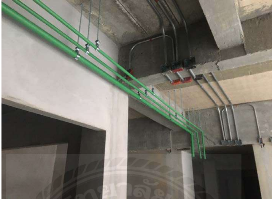
รูปที่ 3 ตรวจสอบส่งงานระบบท่อน้ำประปา
