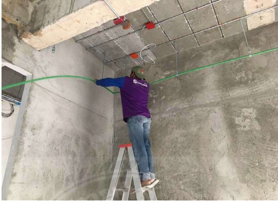
รูปที่ 1 ควบคุมติดตั้งระบบท่อน้ำประปา
