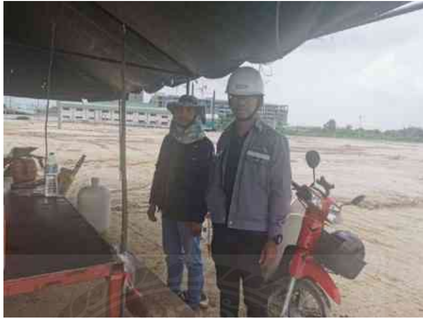
สำรวจพื้นที่ก่อสร้าง
