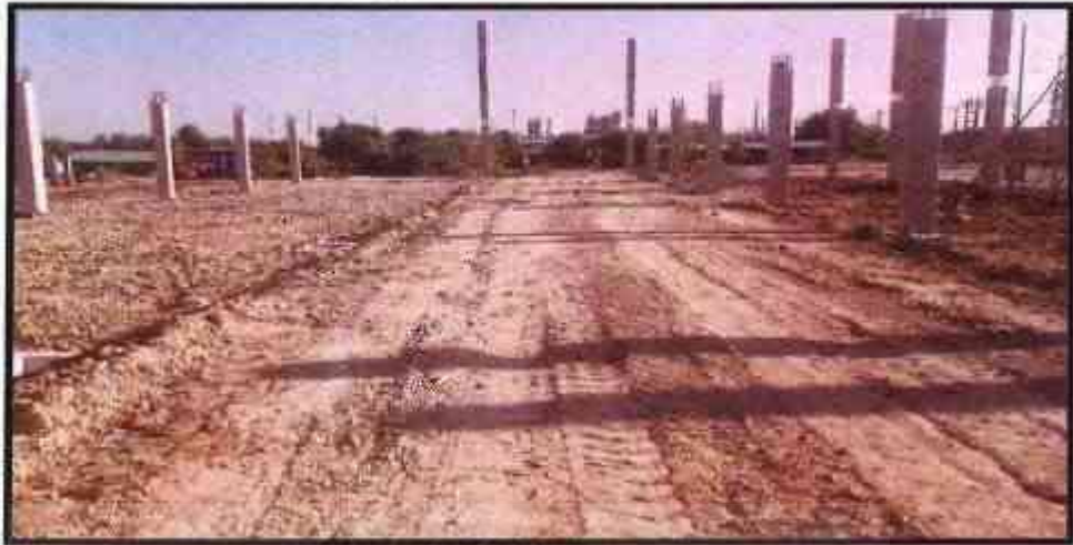
รูปถ่ายงานติดตั้งเสา 01015.4
