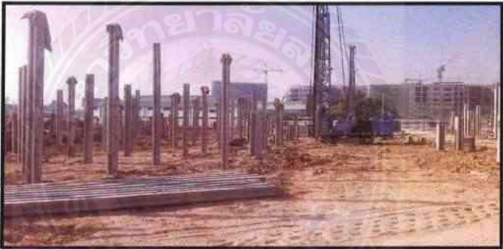
งานติดตั้งเสาเข็ม
