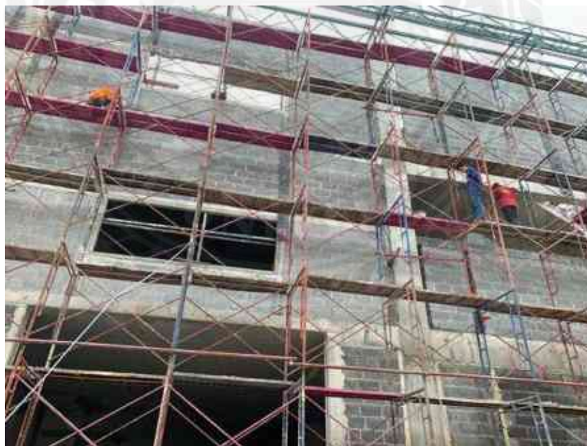
รูปที่ 4.24 แสดงภาพงานก่ออิฐผนัง
