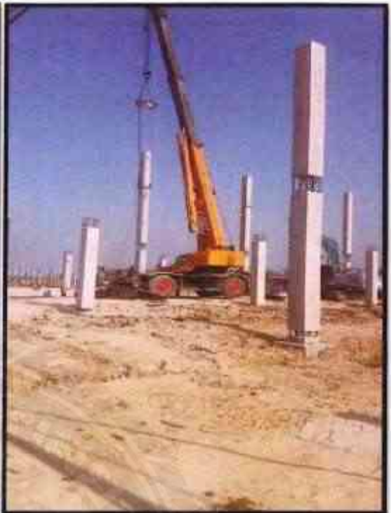
รูปถ่ายติดตั้งเสาแอมเวย์ 2
