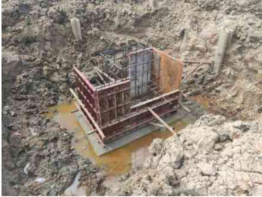
งานเข้าแบบวางเหล็กฐานราก
