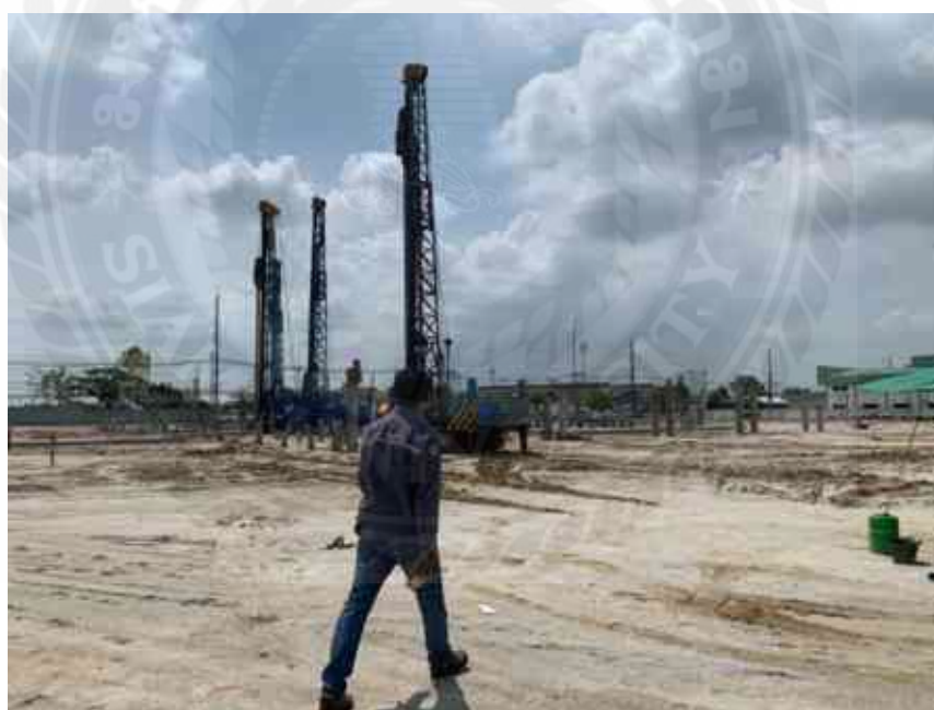
รูปที่ 4.2 แสดงภาพควบคุมงานตอกเสาเข็ม
