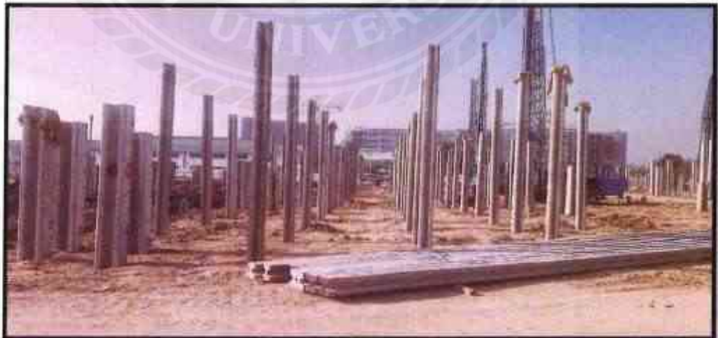
งานติดตั้งเสาเข็ม
