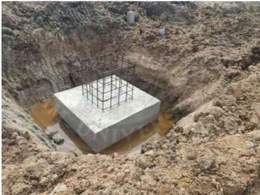
งานเทคอนกรีตขยายฐานราก
