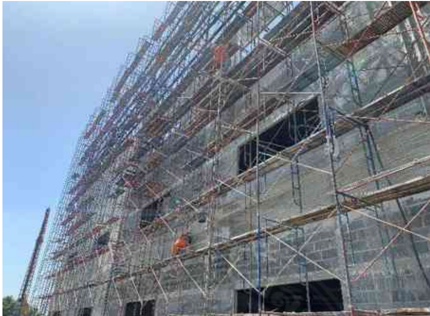
รูปที่ 4.23 แสดงภาพงานก่ออิฐผนัง
