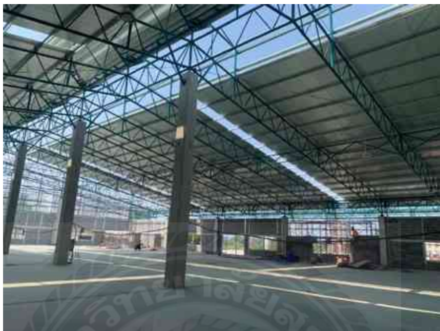
รูปที่ 4.21 แสดงภาพงานมุงหลังคา อาคาร A
