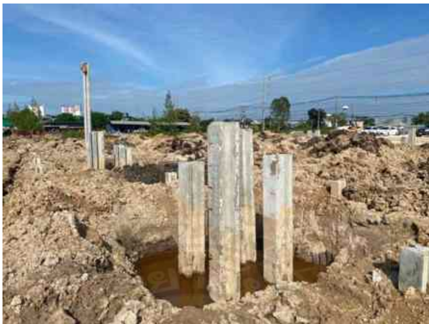
รูปที่ 4.5 แสดงภาพงานเปิดเสาเข็มฐานราก
