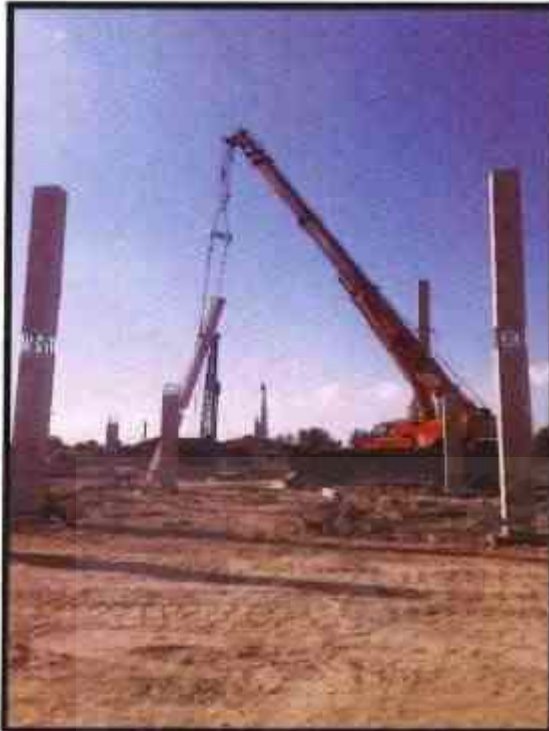
รูปถ่ายติดตั้งเสาแอมเวย์ 1
