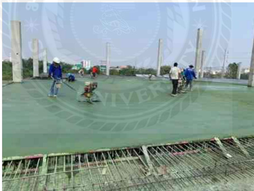
รูปที่ 4.17 แสดงภาพงานเทคอนกรีตชั้น 2 อาคาร A
