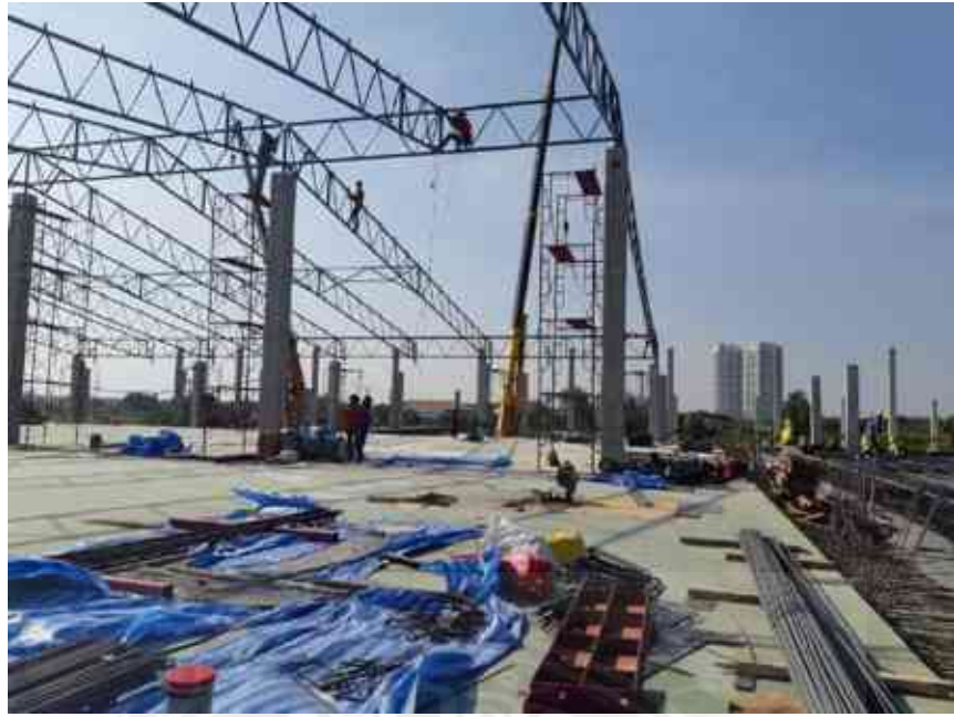
ชั้น โครงหลังคาอาคารโรงงาน
