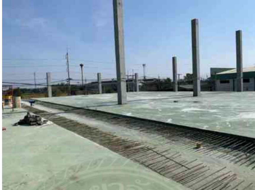
พื้นคอนกรีตอาคาร โรงงาน
