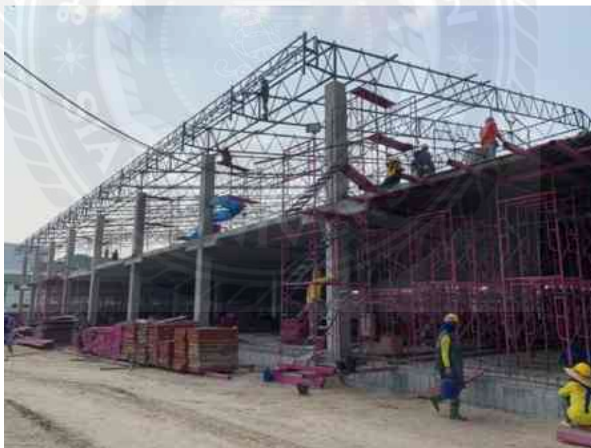
รูปที่ 4.20 แสดงภาพงาน โครงสร้างหลังคาชั้น 2 อาคาร A
