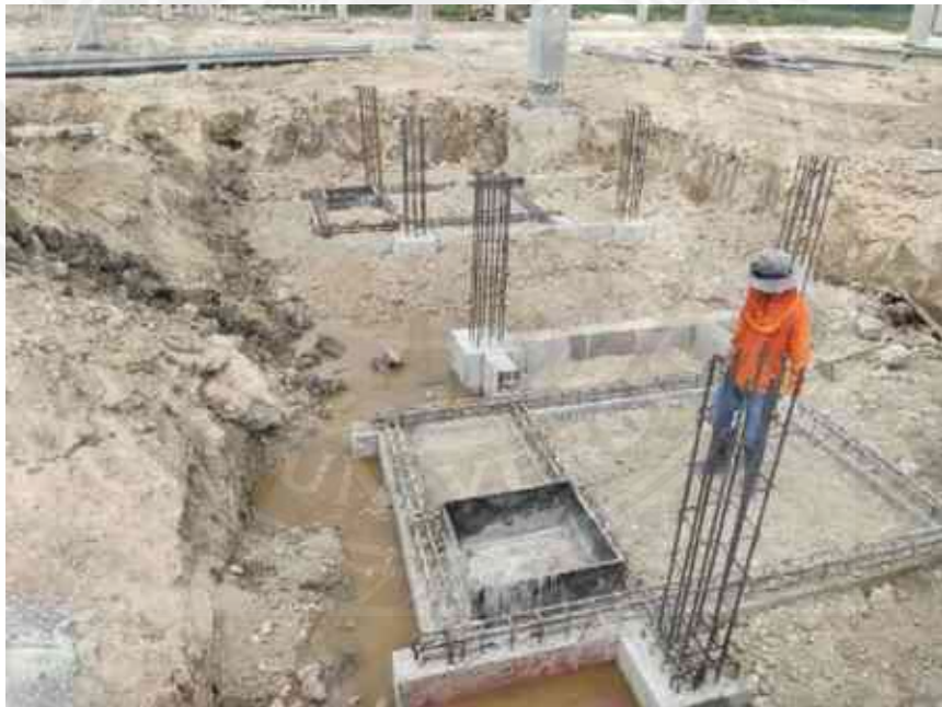
งานเทคอนกรีตห้องลิฟต์
