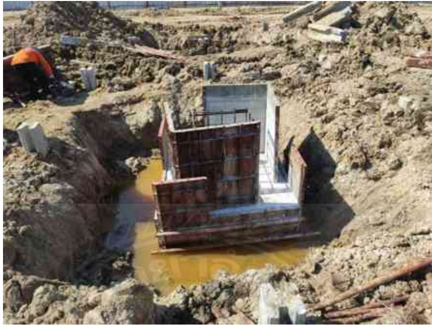
รูปที่ 4.9 แสดงภาพงานเข้าแบบวางเหล็กฐานราก
