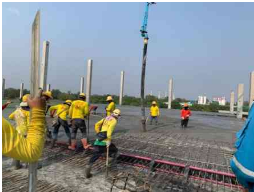
รูปที่ 4.17 แสดงภาพงานเทคอนกรีตชั้น 2 อาคาร A
