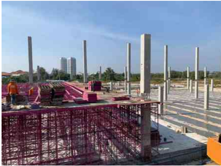
รูปที่ 4.13 แสดงภาพงานตั้งนั่งร้านรับท้องพื้นชั้น 2 อาคาร A
