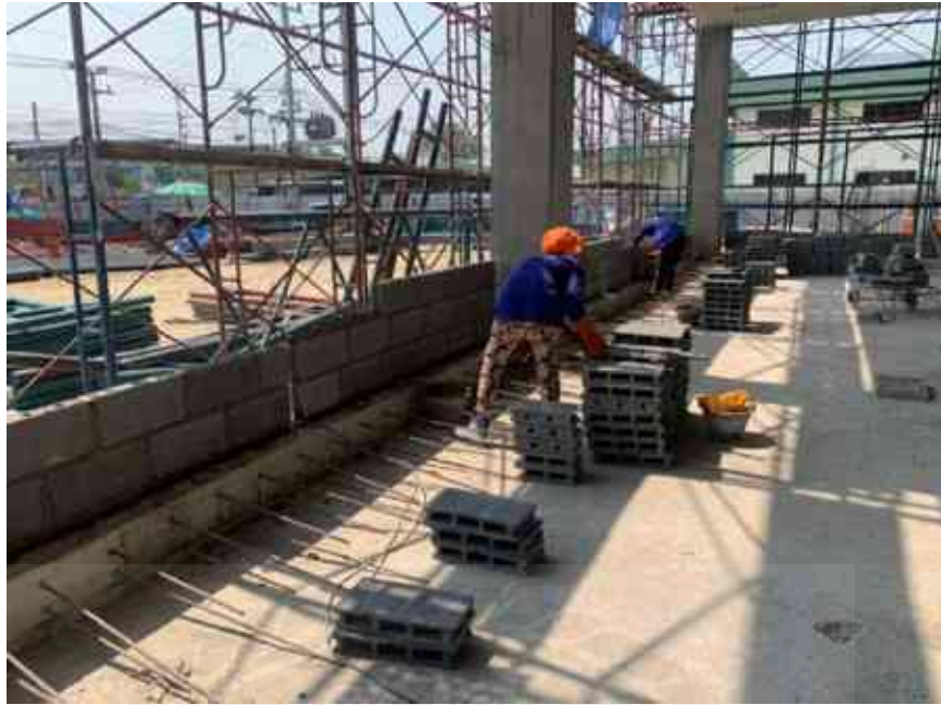
งานก่ออิฐผนัง
