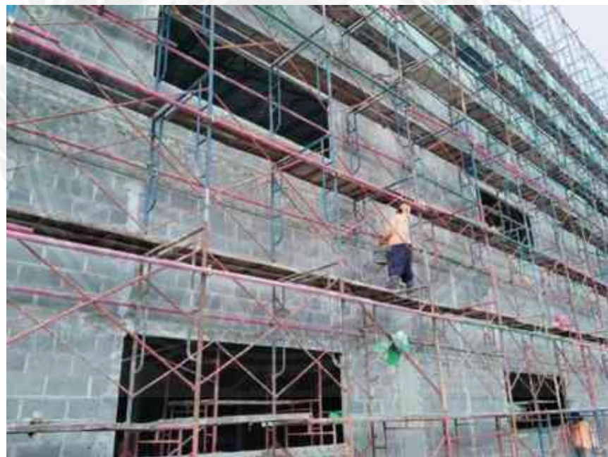
งานก่ออิฐผนัง
