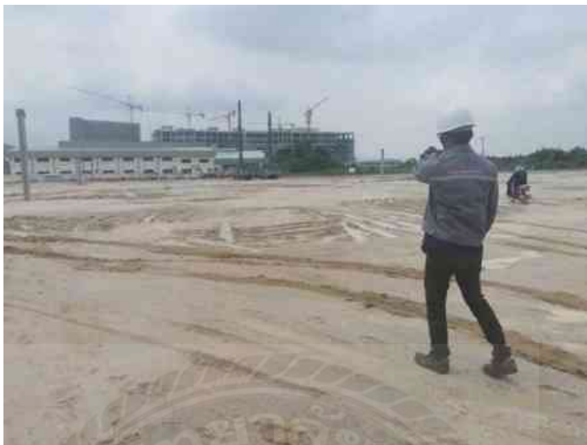
รูปที่ 4.1 แสดงภาพตรวจสอบพื้นที่สำหรับการตอกเสาเข็ม
