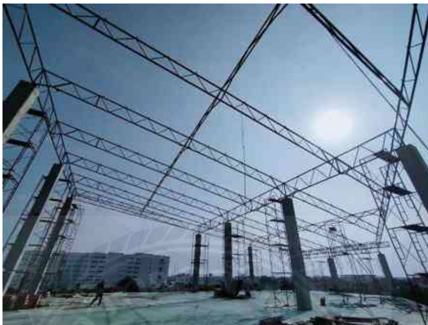
รูปที่ 4.19 แสดงภาพงาน โครงสร้างหลังคาชั้น 2 อาคาร A
