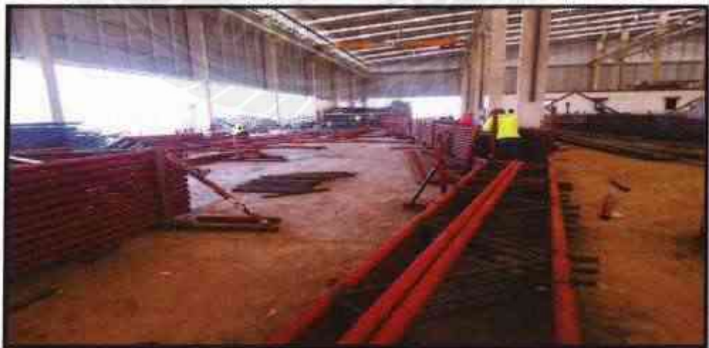
งานประกอบโครงเหล็กห้องจัด อาคาร C
