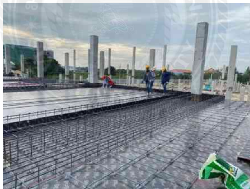
รูปที่ 4.16 แสดงภาพงานวางเหล็กเสริมพื้นชั้น 2 อาคาร A
