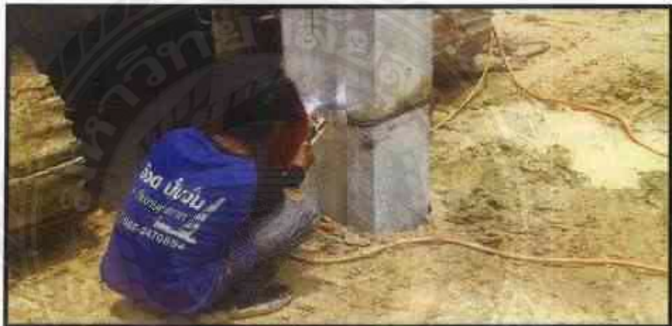
งานเชื่อมเสาเข็ม
