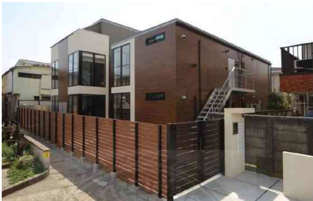
รูปที่ 3.7 แสดงภาพก่อสร้างอพาร์ทเมนท์ 3 ชั้น
