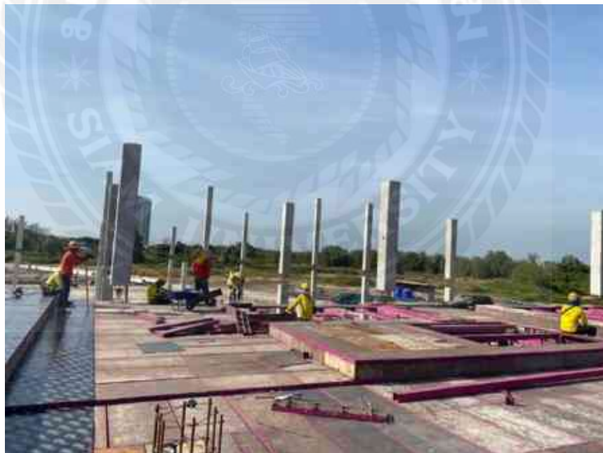
รูปที่ 4.14 แสดงภาพงานปูแบบท้องพื้นชั้น 2 อาคาร A
