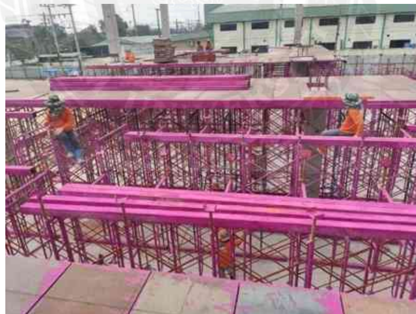
รูปที่ 4.12 แสดงภาพงานติดตั้งนั่งร้านรับท้องพื้นชั้น 2 อาคาร A
