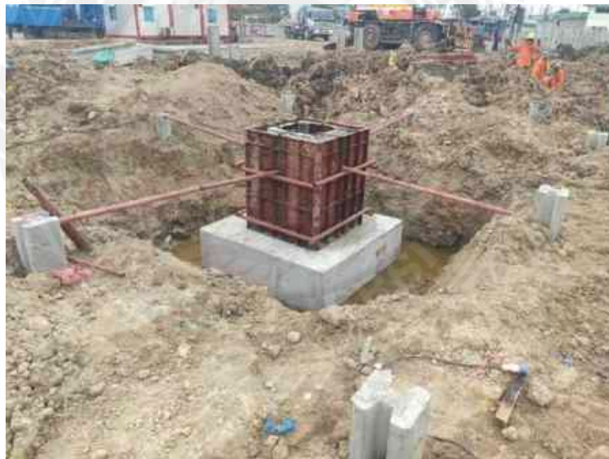
รูปที่ 4.8 แสดงภาพงานเข้า Socket ฐานราก
