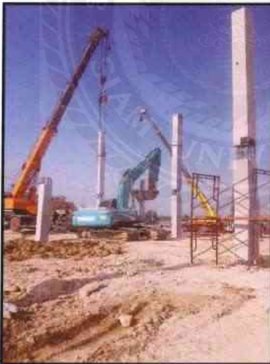
รูปถ่ายติดตั้งเสาแอมเวย์ 3
