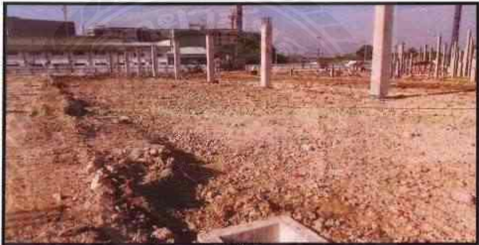
รูปถ่ายงานติดตั้งเสา 01015.4
