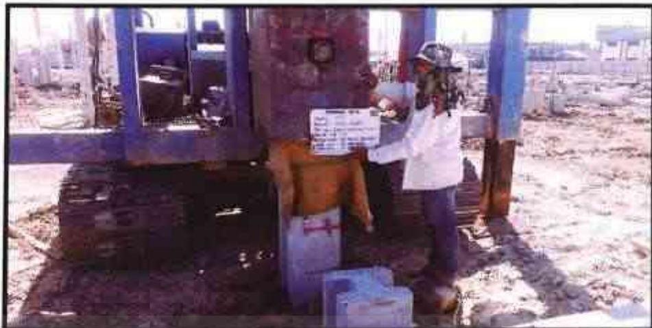
รูปทดสอบเสาเข็ม ๕ เมตร B
