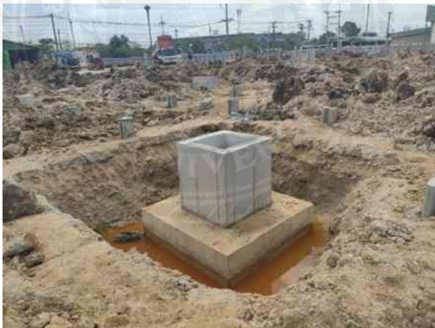
รูปที่ 4.10 แสดงภาพงานเทคอนกรีตหยาบฐานราก
