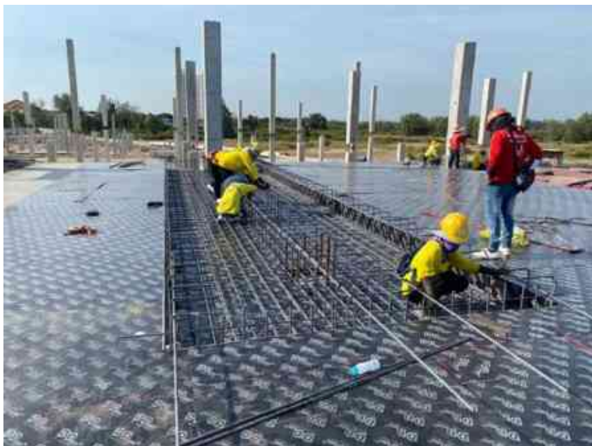
รูปที่ 4.15 แสดงภาพงานวางเหล็กเสริมพื้นชั้น 2 อาคาร A
