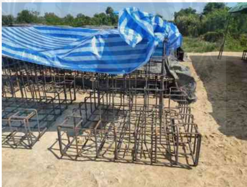
รูปที่ 4.6 แสดงภาพงานผูกเหล็กฐานราก
