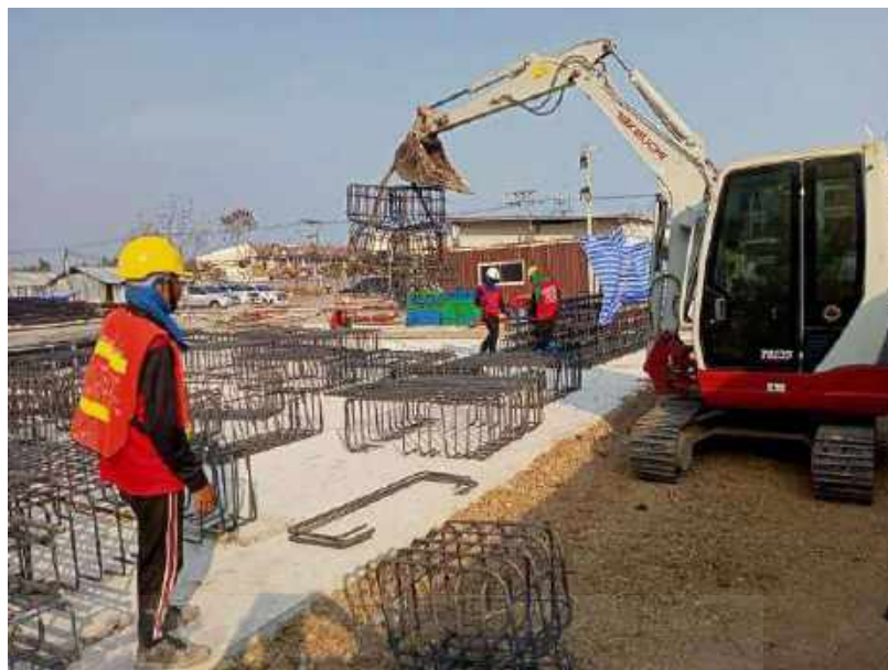
รูปที่ 4-53 เตรียมเหล็กงานฐานราก โครงการอาคารพาณิชย์ห้างโลตัส
