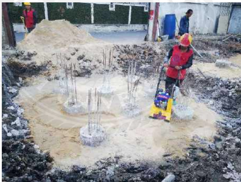
รูปที่ 4-50 บดอัดงานฐานรากงานอาคาร ค.ส.ล. 5 ชั้น
