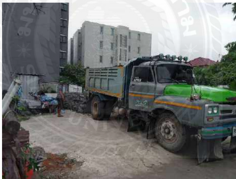
รูปที่ 4-34 ขนหน้าดินไปทำงานอาคาร ค.ส.ล. 5 ชั้น
