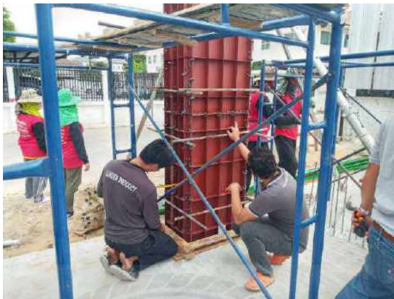
รูปที่ 4-70 ประกอบแบบเสาหล่อในที่งานอาคาร ค.ส.ล. 5 ชั้น
