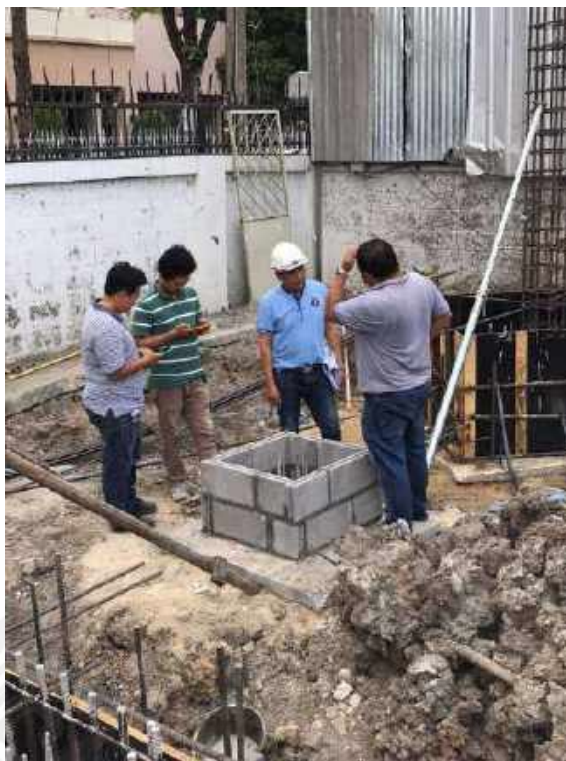
รูปที่ 4-61 ตรวจสอบงานฐานราก อาคาร ค.ส.ล. 5 ชั้น
