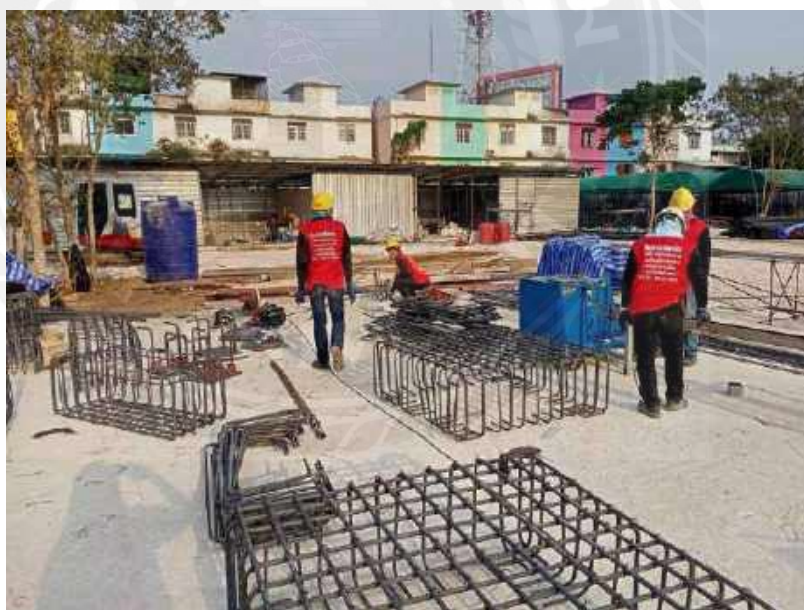
รูปที่ 4-56 เตรียมเหล็กงานฐานราก โครงการอาคารพาณิชย์ห้างโลตัส
