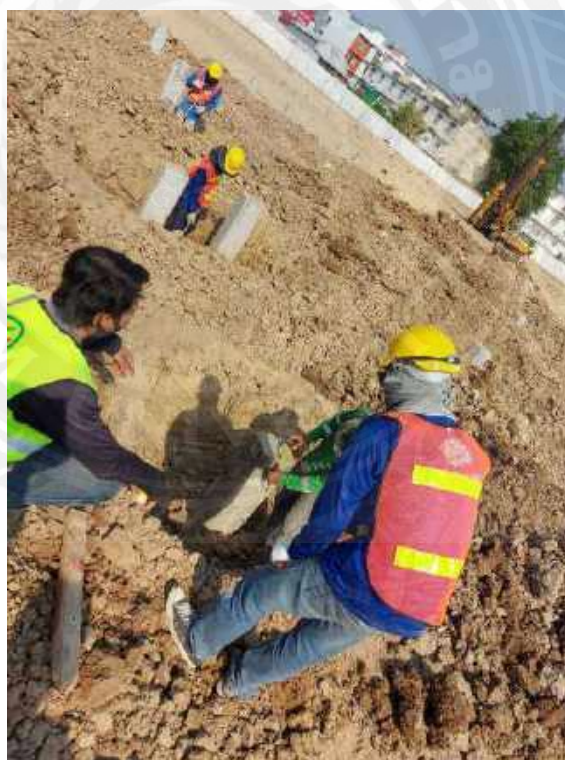
รูปที่ 4-38 หาระดับงานฐานราก โครงการอาคารพาณิชย์ห้างโลตัส
