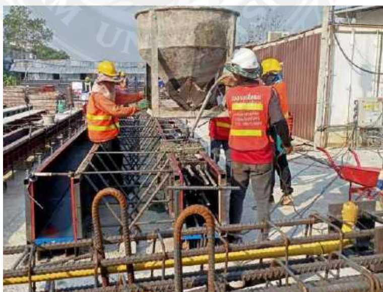
รูปที่ 4-67 หล่อเสาสำเร็จ โครงการอาคารพาณิชย์ห้างโลตัส
