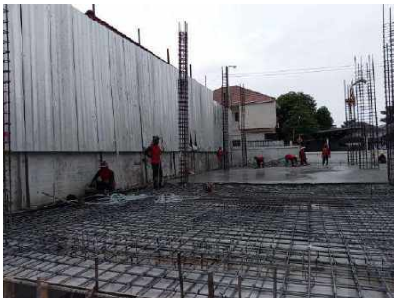
รูปที่ 4-86 เทคอนกรีตพื้นงานอาคาร ค.ส.ล. 5 ชั้น
