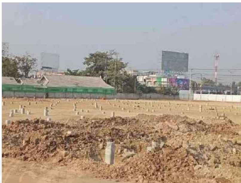
รูปที่ 4-20 เข็มจตุรัส 26 x 26 ซม. ลึก 12 ม. โครงการอาคารพาณิชย์ห้างโลตัส
