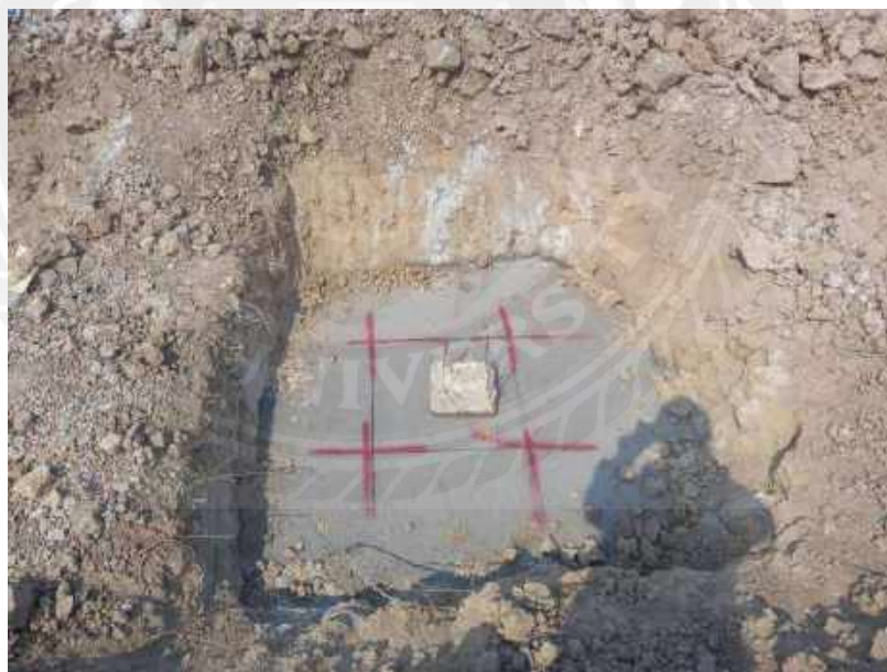
รูปที่ 4-46 เทคอนกรีตหยาบงานฐานราก โครงการอาคารพาณิชย์ห้างโลตัส
