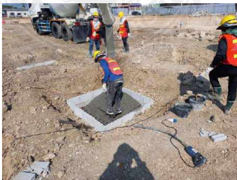
รูปที่ 4-63 เทคอนกรีตงานฐานราก โครงการอาคารพาณิชย์ห้างโลตัส
