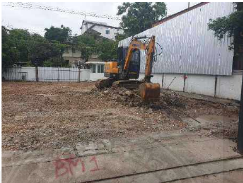
รูปที่ 4-10 หน้าเคลียร์หน้างานอาคาร ค.ส.ล. 5 ชั้น
