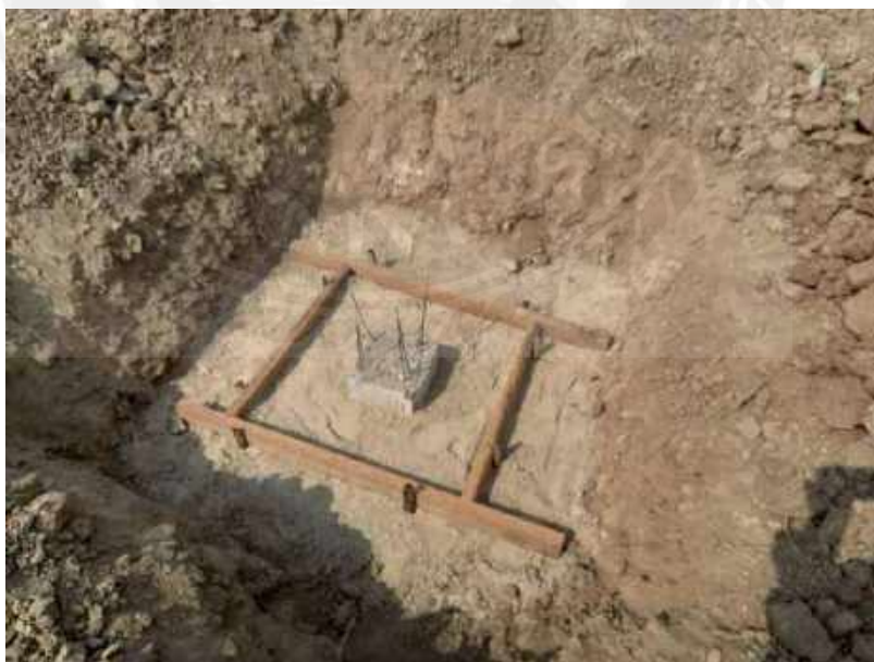
รูปที่ 4-44 ปรับกันหลุม โครงการอาคารพาณิชย์ห้างโลตัส
