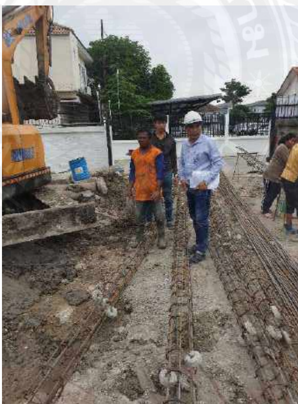
รูปที่ 4-23 ตรวจสอบเหล็กเสาเข็ม งานอาคาร ค.ส.ล. 5 ชั้น
