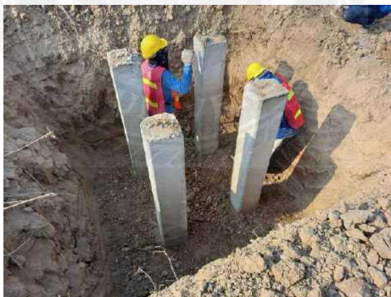
รูปที่ 4-36 ทหาระดับงานฐานราก โครงการอาคารพาณิชย์ห้างโลตัส
