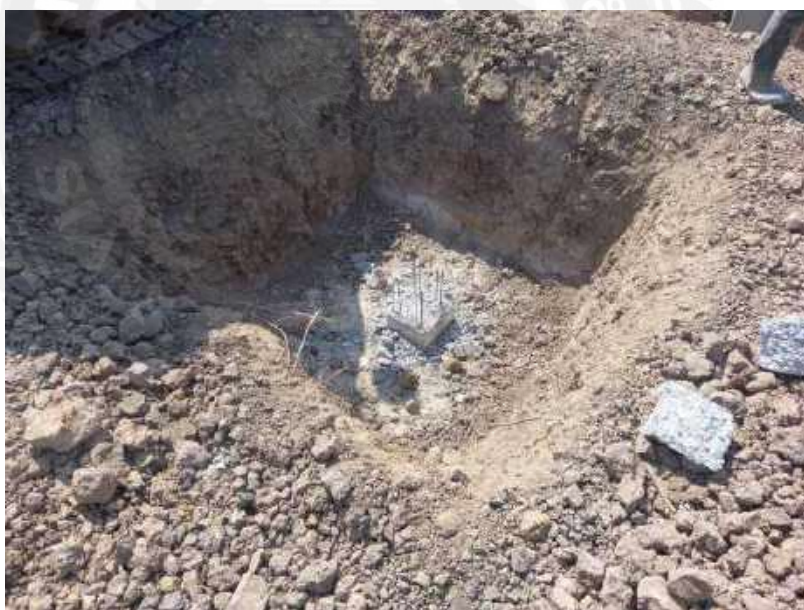
รูปที่ 4-42 ตัดเข็ม โครงการอาคารพาณิชย์ห้างโลตัส
