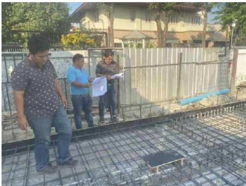
รูปที่ 4-84 ลงเหล็กพื้นงานอาคาร ค.ส.ล. 5 ชั้น
