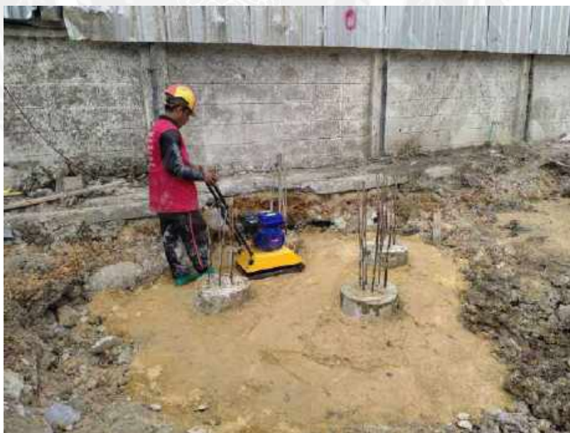
รูปที่ 4-48 บดอัดงานฐานรากงานอาคาร ค.ส.ล. 5 ชั้น
