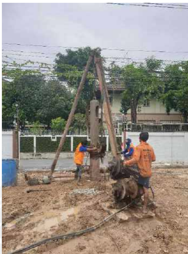
รูปที่ 4-14 เข็มเจาะงานอาคาร ค.ส.ถ. 5 ชั้น
