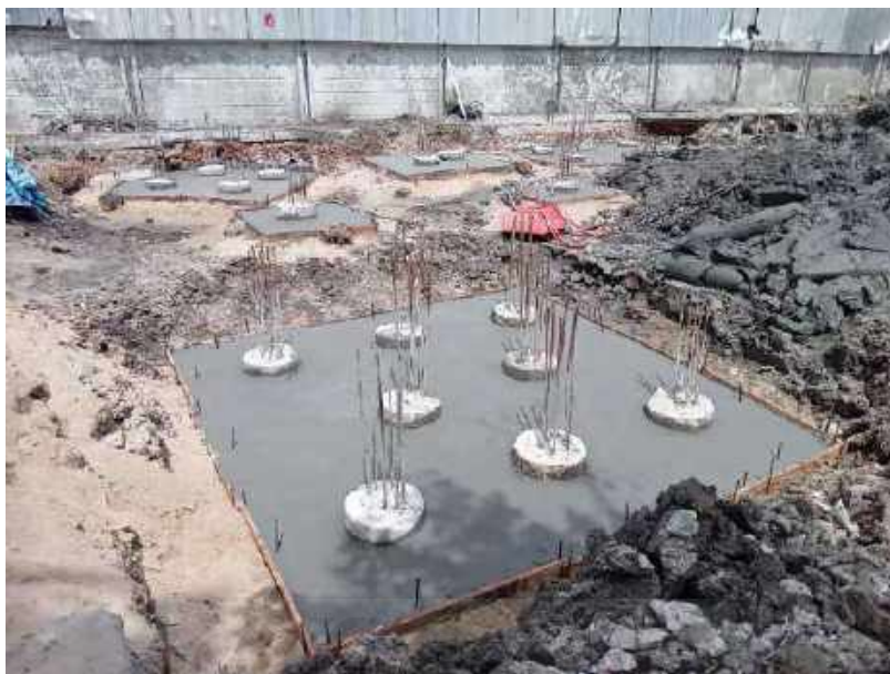
รูปที่ 4-51 เทคอนกรีตหยาบฐานรากงานอาคาร ค.ส.ล. 5 ชั้น
