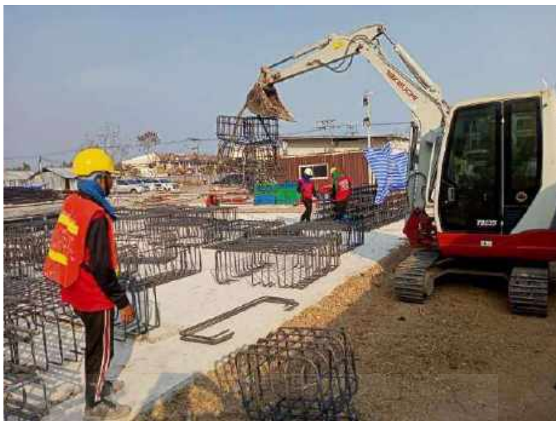
รูปที่ 4-55 เคลื่อนย้ายเหล็กฐานราก โครงการอาคารพาณิชย์ห้างโลตัส
