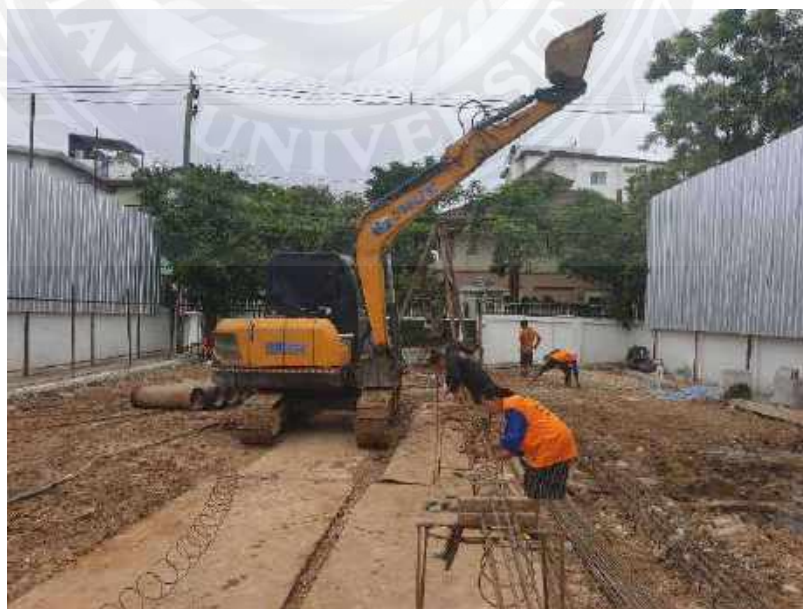
รูปที่ 4-15 เข็มเจาะงานอาคาร ค.ส.ถ. 5 ชั้น
