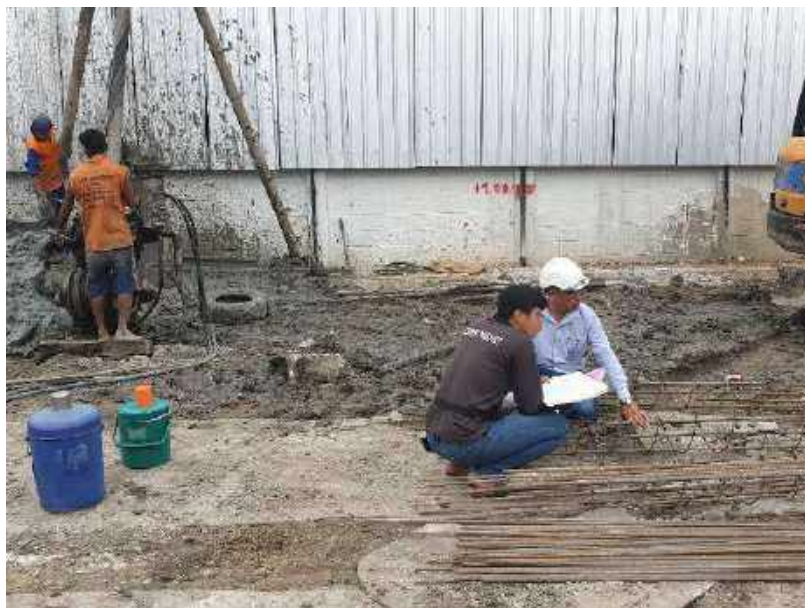
รูปที่ 4-22 ตรวจสอบเหล็กเสาเข็ม งานอาคาร ค.ส.ล. 5 ชั้น
