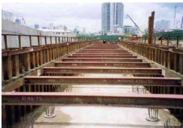
รูปที่ 2-4 กำแพงกันดินเข็มพืดเหล็กสำหรับก่อสร้างอุโมงค์รถไฟฟ้าใต้ดิน
