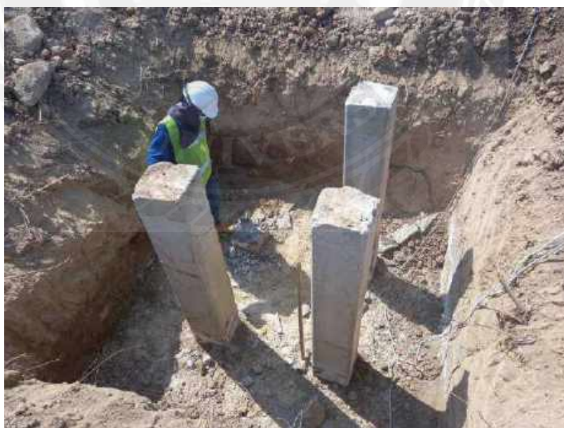
รูปที่ 4-40 ตัดเข็ม โครงการอาคารพาณิชย์ห้างโลตัส
