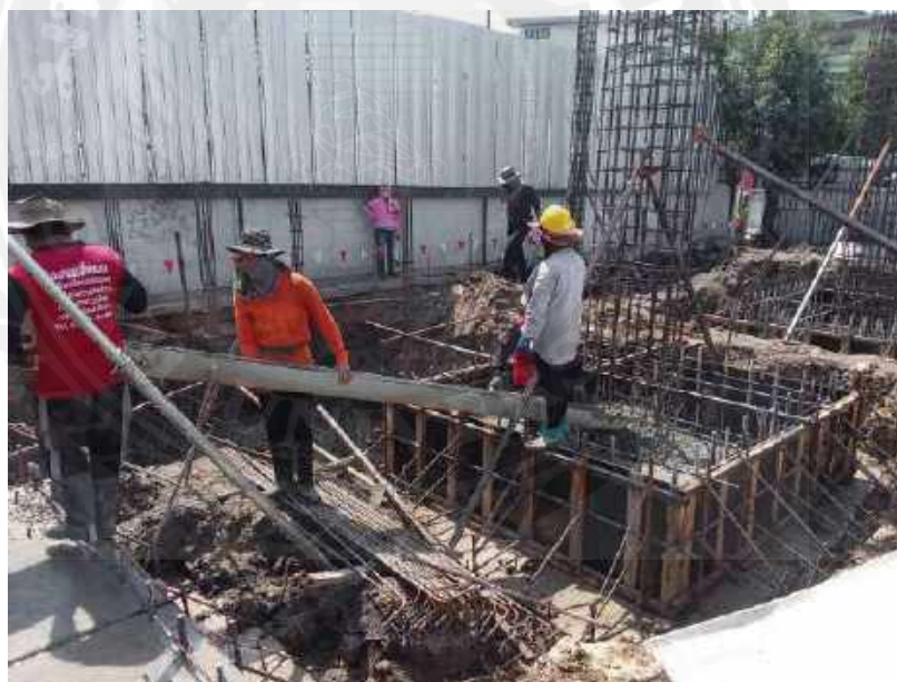
รูปที่ 4-65 เทคอนกรีตงานฐานรากอาคาร ค.ส.ล. 5 ชั้น
