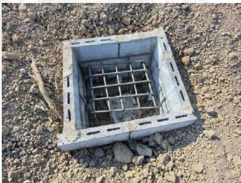
รูปที่ 4-54 ลงเหล็กงานฐานราก โครงการอาคารพาณิชย์ห้างโลตัส
