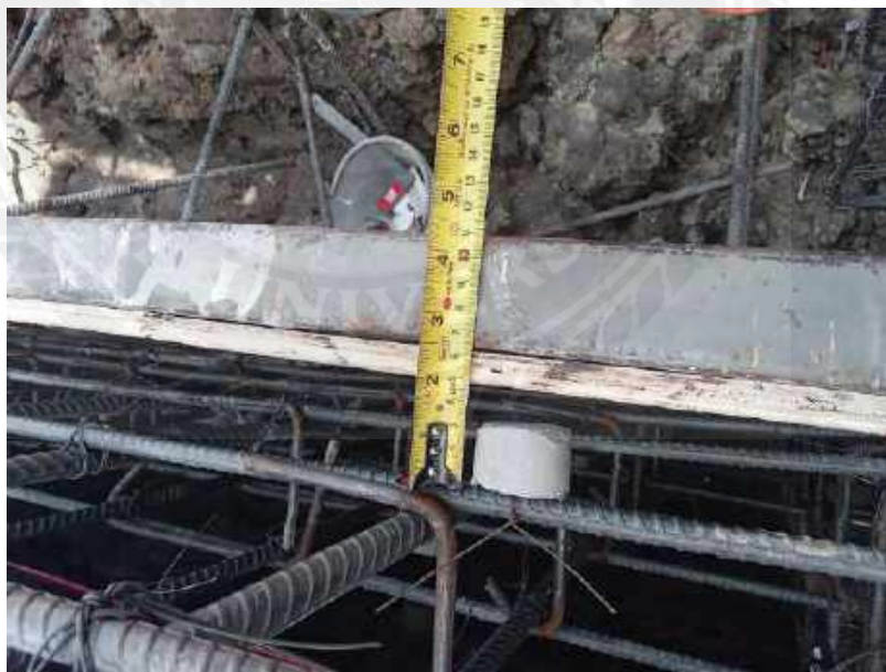
รูปที่ 4-75 ตรวจสอบแบบคานคอดิน โครงการอาคาร ค.ส.ล. 5 ชั้น
