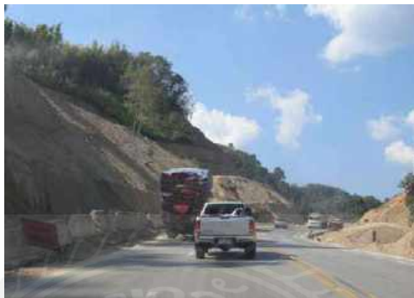
รูปที่ 2-3 ลาดดินขุดเชิงเขาติดกับทางหลวงช่วง แพร่-อุตรดิตถ์
