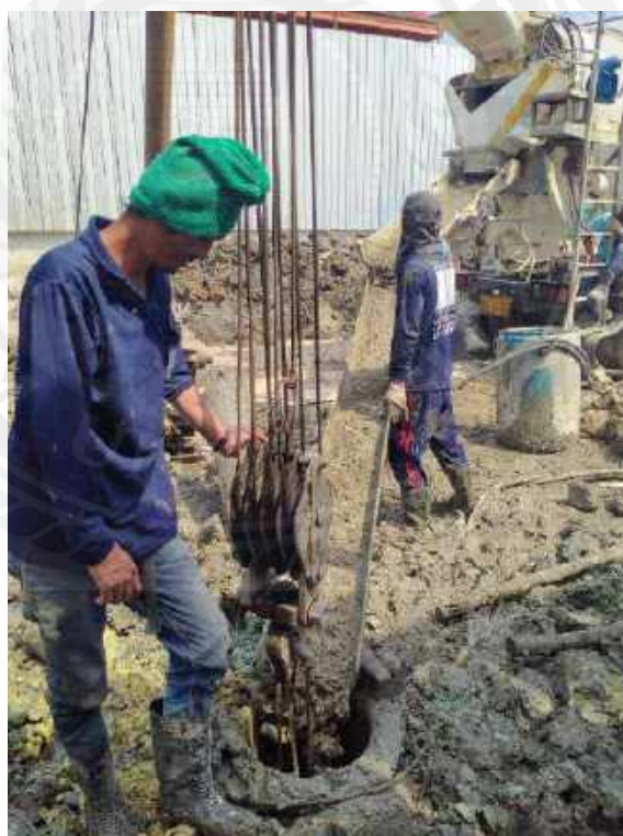
รูปที่ 4-29 ตรวจสอบการดึงปลอกเข็มงานอาคาร ค.ส.ล. 5 ชั้น
