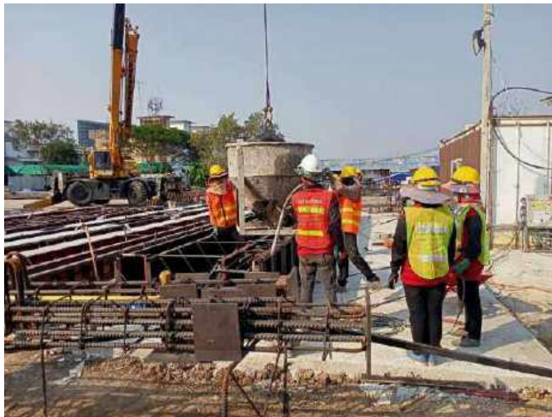
รูปที่ 4-68 หล่อเสาสำเร็จ โครงการอาคารพาณิชย์ห้างโลตัส
