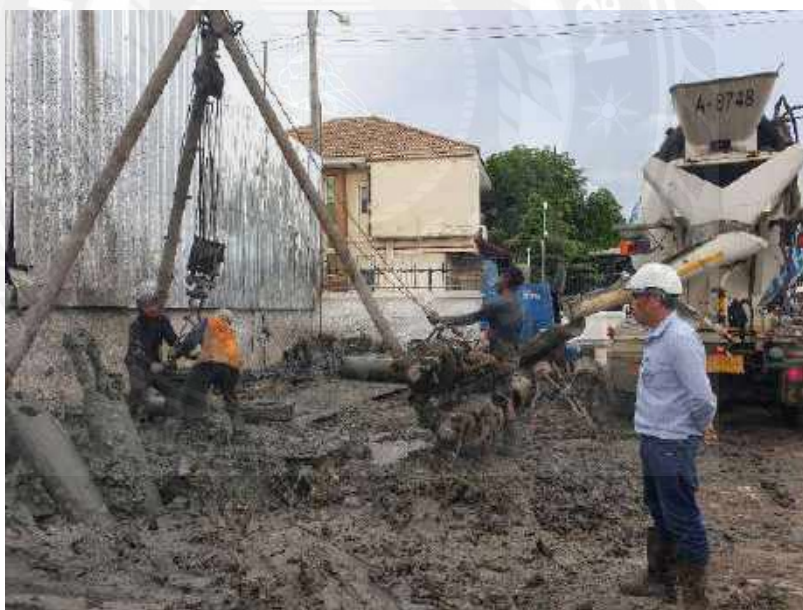
รูปที่ 4-17 เข็มเจาะงานอาคาร ค.ส.ถ. 5 ชั้น
