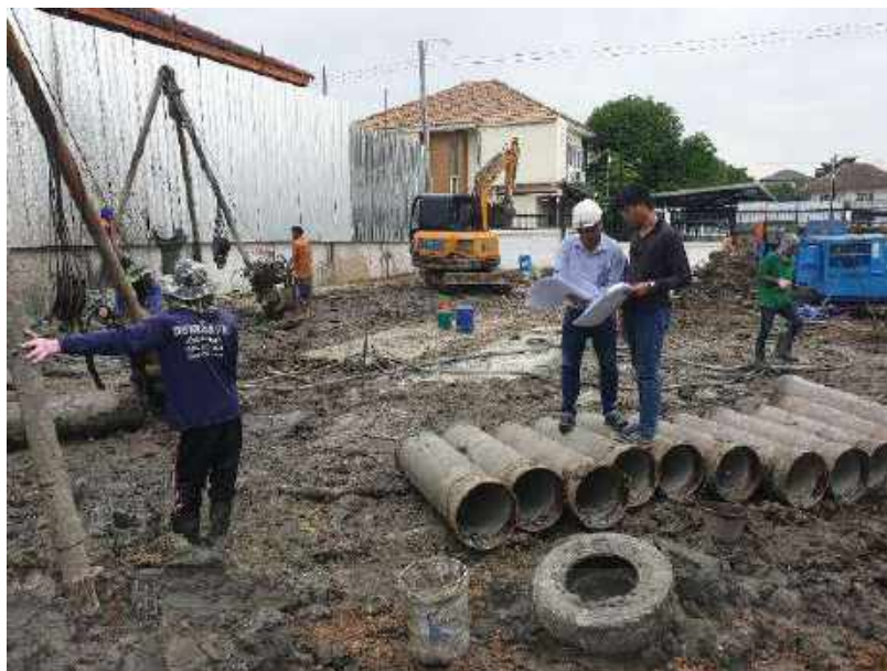
รูปที่ 4-18 เติมเจาะงานอาคาร ค.ส.ล. 5 ชั้น
