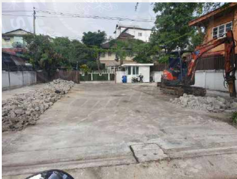
รูปที่ 4-11 หน้าเคลียร์หน้างานอาคาร ค.ส.ล. 5 ชั้น
