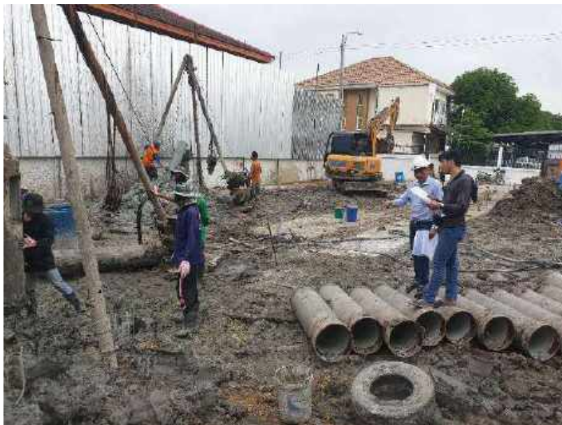
รูปที่ 4-16 เข็มเจาะงานอาคาร ค.ส.ถ. 5 ชั้น
