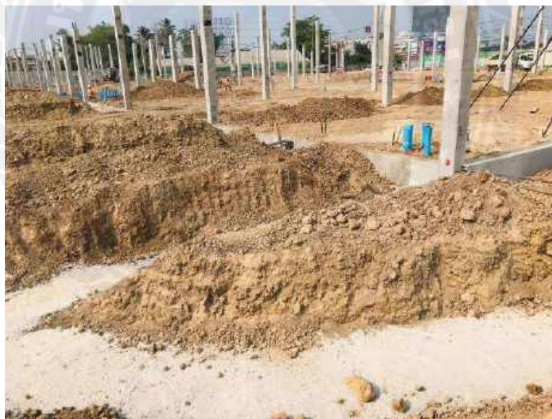
รูปที่ 4-83 ปรับหน้าดินพื้น โครงการอาคารพาณิชย์ห้างโลตัส
