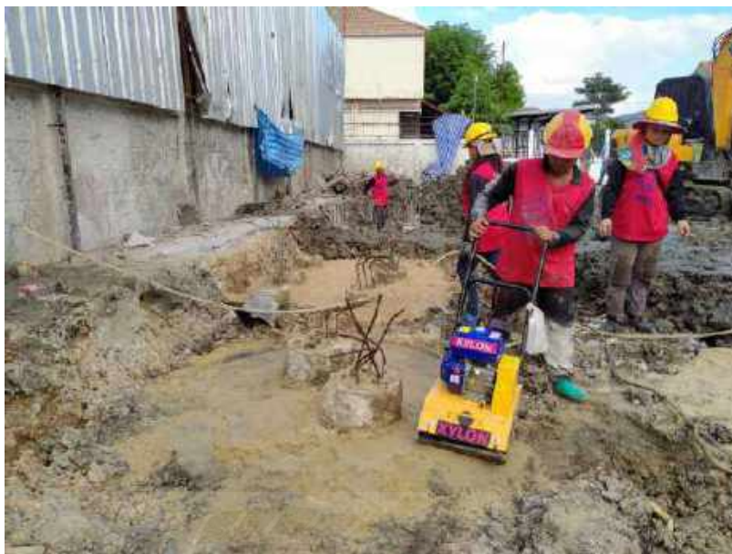
รูปที่ 4-49 บดอัดฐานรากงานอาคาร ค.ส.ล. 5 ชั้น
