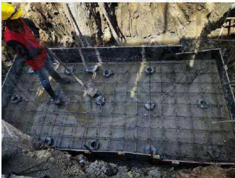
รูปที่ 4-58 ลงเหล็กงานฐานรากอาคาร ค.ส.ล. 5 ชั้น
