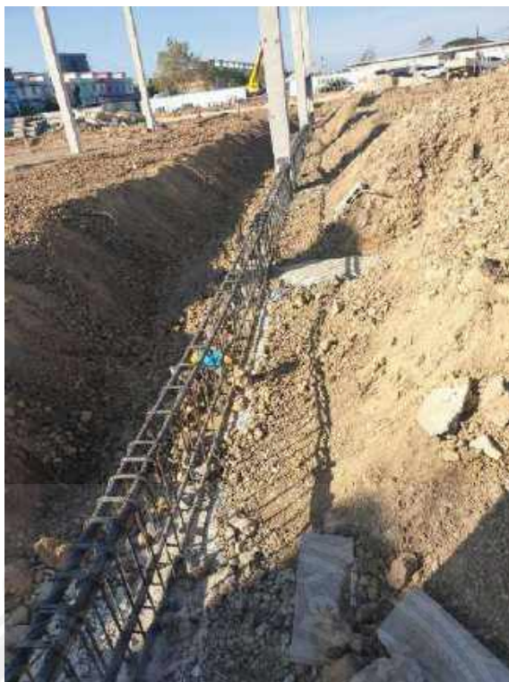
รูปที่ 4-72 ลงเหล็กคานคอดิน โครงการอาคารพาณิชย์ห้างโลตัส
