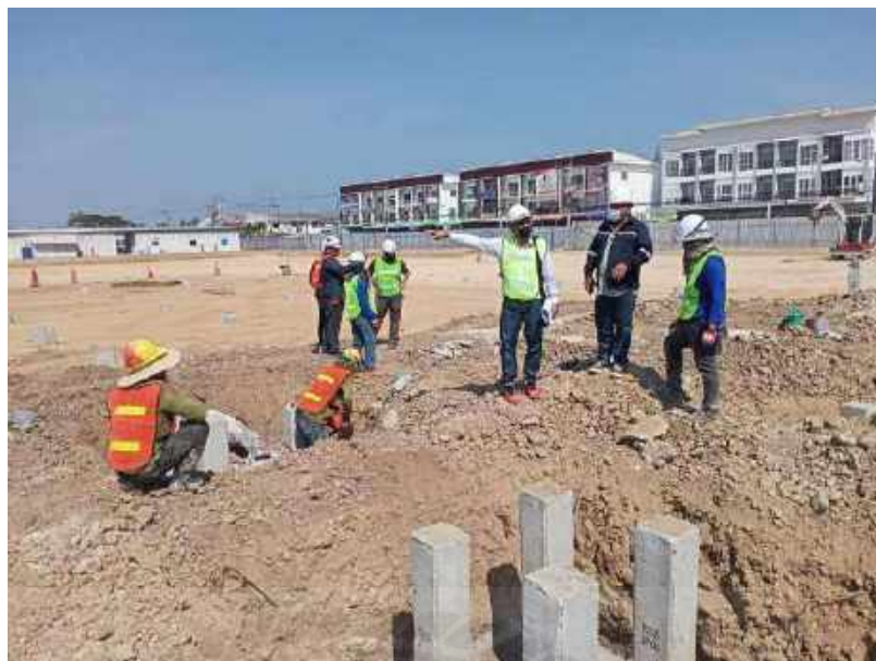
รูปที่ 4-37 หาระดับงานฐานราก โครงการอาคารพาณิชย์ห้างโลตัส
