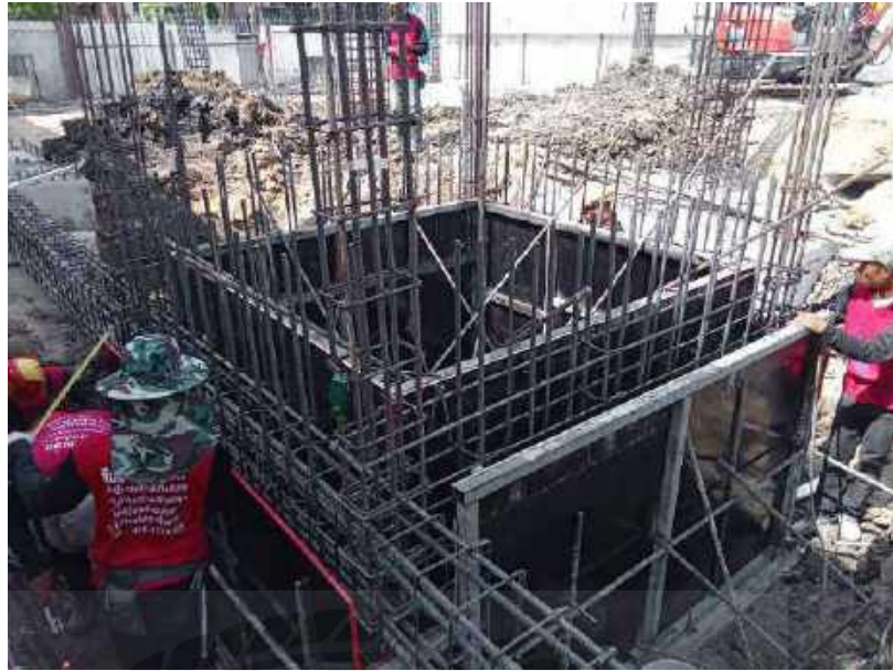
รูปที่ 4-59 ลงเหล็กงานฐานรากอาคาร ค.ส.ล. 5 ชั้น
