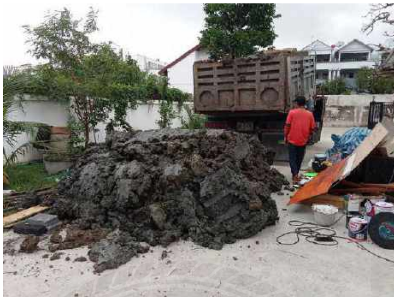
รูปที่ 4-35 ขนหน้าดินไปทำงานอาคาร ค.ส.ล. 5 ชั้น
