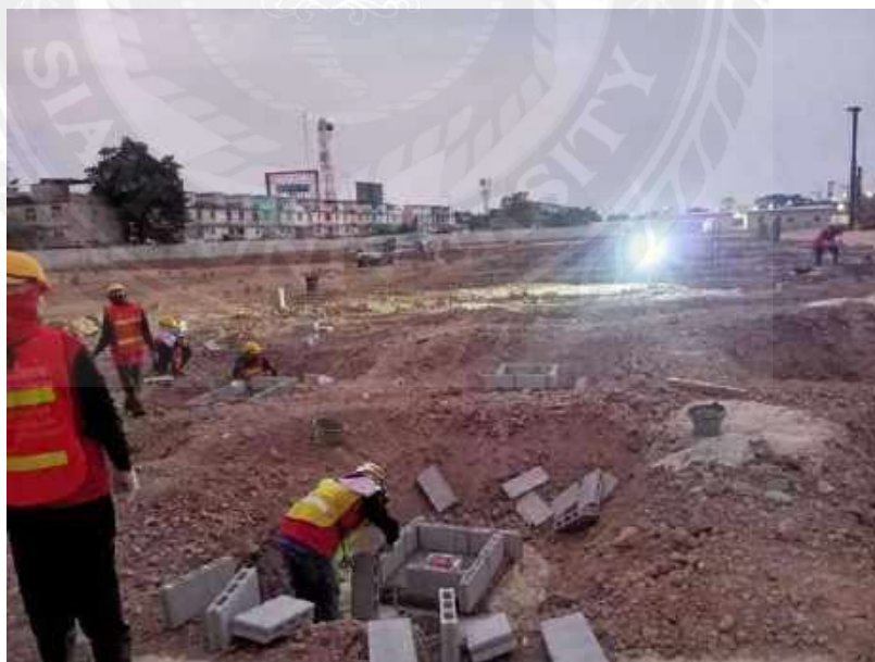
รูปที่ 4-52 เข้าแบบงานฐานราก โครงการอาคารพาณิชย์ห้างโลตัส
