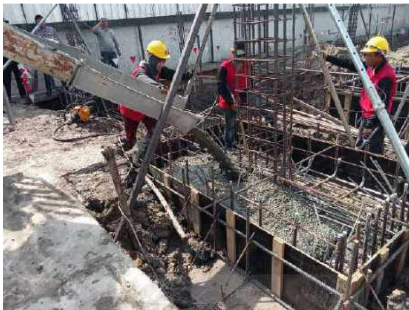
รูปที่ 4-64 เทคอนกรีตงานฐานรากอาคาร ค.ส.ล. 5 ชั้น
