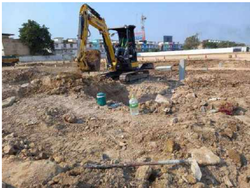
รูปที่ 4-33 เปิดหน้าดินงานฐานราก โครงการอาคารพาณิชย์ห้างโลตัส
