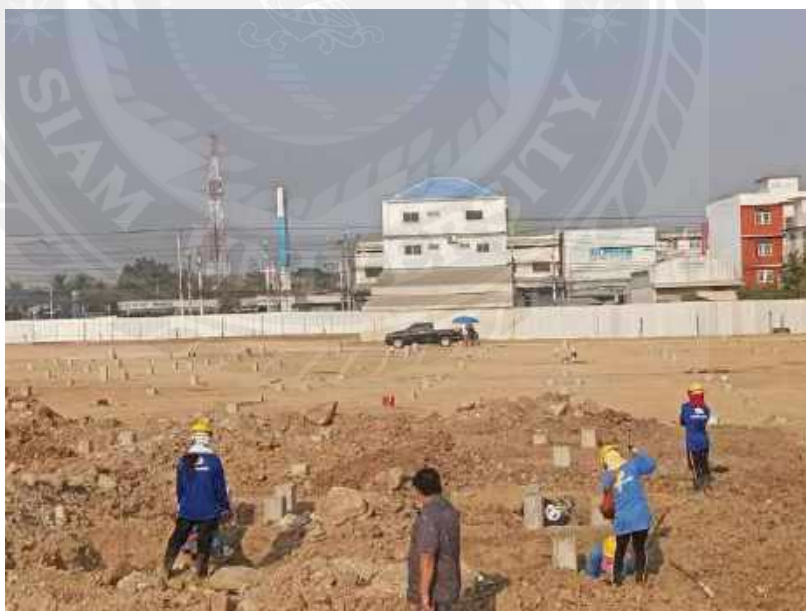
รูปที่ 4-21 เข็มจตุรัส 26 x 26 ซม. ลึก 12 ม. โครงการอาคารพาณิชย์ห้างโลตัส
