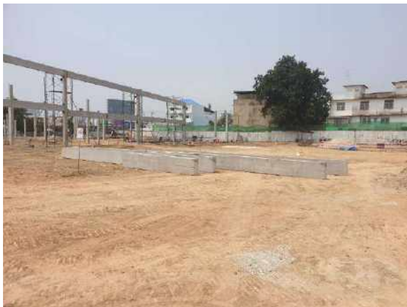
รูปที่ 4-82 ปรับหน้าดินพื้น โครงการอาคารพาณิชย์ห้างโลตัส
