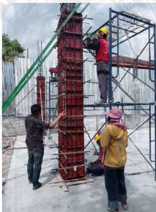
รูปที่ 4-71 ตรวจสอบแบบเสาหล่อในที่งานอาคาร ค.ส.ล. 5 ชั้น
