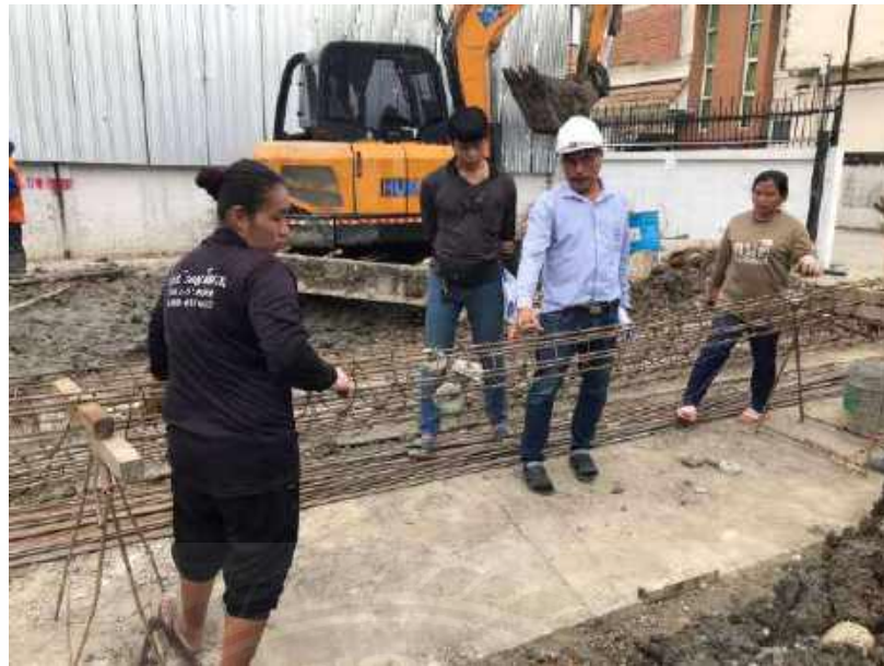
รูปที่ 4-24 ตรวจสอบเหล็กเสาเข็ม งานอาคาร ค.ส.ล. 5 ชั้น
