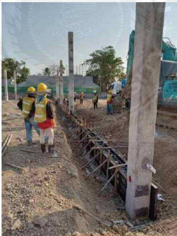
รูปที่ 4-73 ประกอบแบบคานคอดิน โครงการอาคารพาณิชย์ห้างโลตัส
