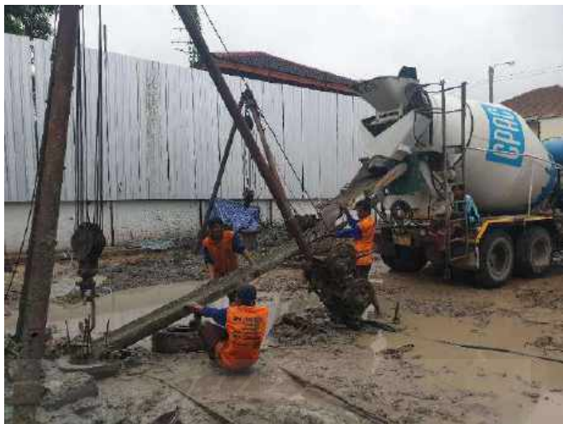
รูปที่ 4-28 ตรวจสอบการเทคอนกรีตเสาเข็มเจาะงานอาคาร ค.ส.ล. 5 ชั้น
