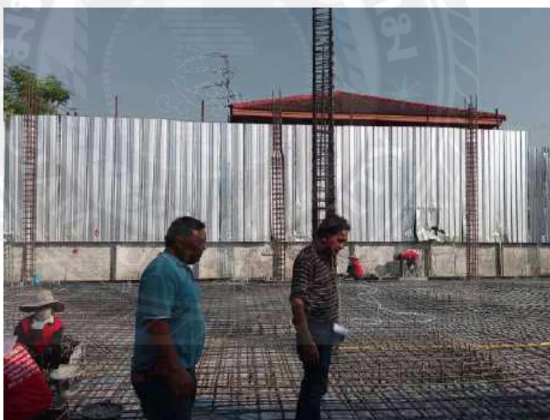
รูปที่ 4-85 ตรวจสอบเหล็กพื้นงานอาคาร ค.ส.ล. 5 ชั้น
