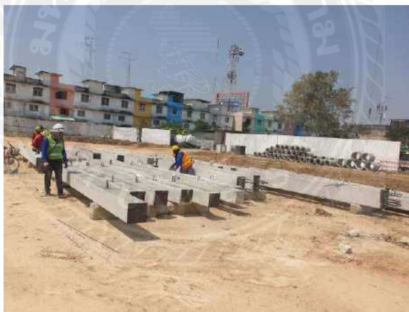
รูปที่ 4-69 ตรวจสอบเสาและคานสำเร็จ โครงการอาคารพาณิชย์ห้างโลตัส
