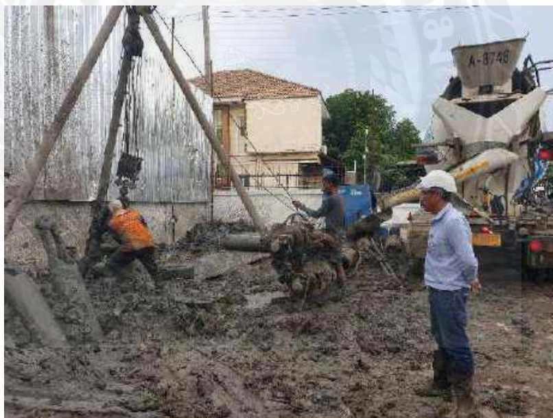
รูปที่ 4-27 ตรวจสอบการเทคอนกรีตเสาเข็มเจาะงานอาคาร ค.ส.ล. 5 ชั้น
