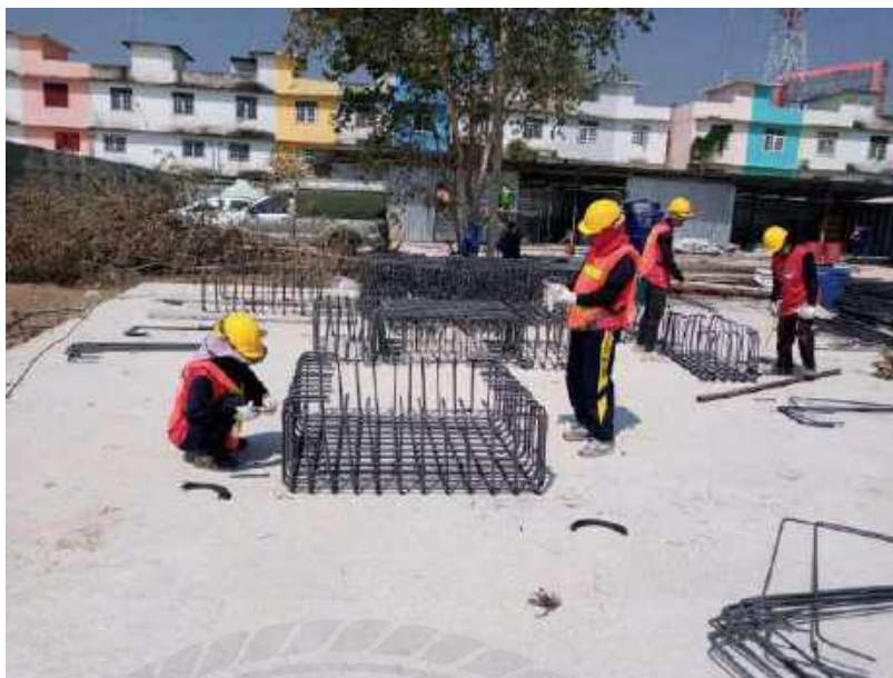
รูปที่ 4-57 เตรียมเหล็กงานฐานราก โครงการอาคารพาณิชย์ห้างโลตัส
