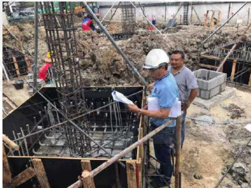
รูปที่ 4-60 ตรวจสอบงานฐานราก อาคาร ค.ส.ล. 5 ชั้น
