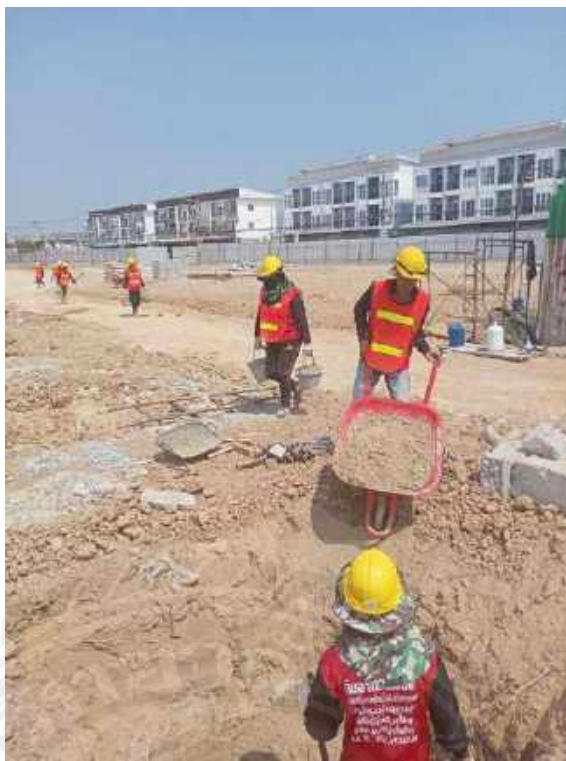
รูปที่ 4-47 บดอัดทรายหยาบฐานราก โครงการอาคารพาณิชย์ห้างโลตัส
