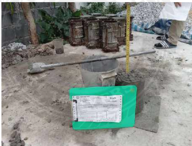
รูปที่ 4-31 ตรวจสอบค่ายุบตัวของคอนกรีตเสาเข็มงานอาคาร ค.ส.ล. 5 ชั้น
