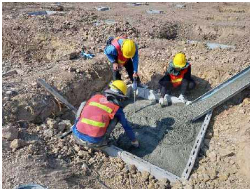
รูปที่ 4-62 เทคอนกรีตงานฐานราก โครงการอาคารพาณิชย์ห้างโลตัส
