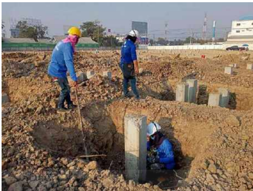
รูปที่ 4-39 หาระดับงานฐานราก โครงการอาคารพาณิชย์ห้างโลตัส
