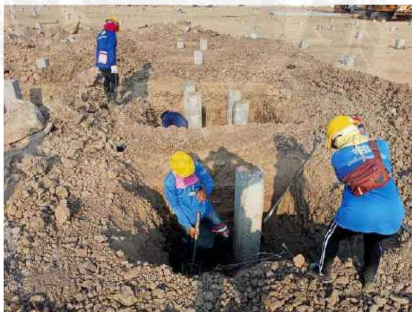
รูปที่ 4-32 เปิดหน้าดินงานฐานราก โครงการอาคารพาณิชย์ห้างโลตัส
