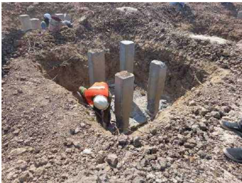
รูปที่ 4-43 ตัดเข็ม โครงการอาคารพาณิชย์ห้างโลตัส
