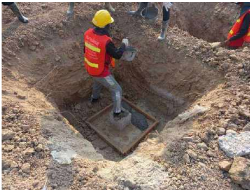
รูปที่ 4-45 เทคอนกรีตหยาบงานฐานราก โครงการอาคารพาณิชย์ห้างโลตัส
