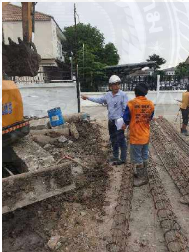
รูปที่ 4-25 ตรวจสอบเหล็กเสาเข็ม งานอาคาร ค.ส.ล. 5 ชั้น
