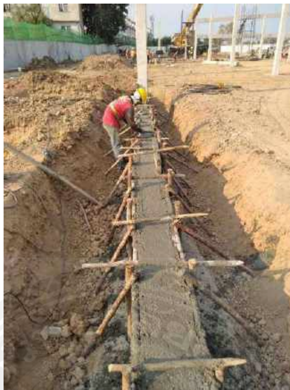
รูปที่ 4-76 เทคอนกรีตคานคอดิน โครงการอาคารพาณิชย์ห้างโลตัส
