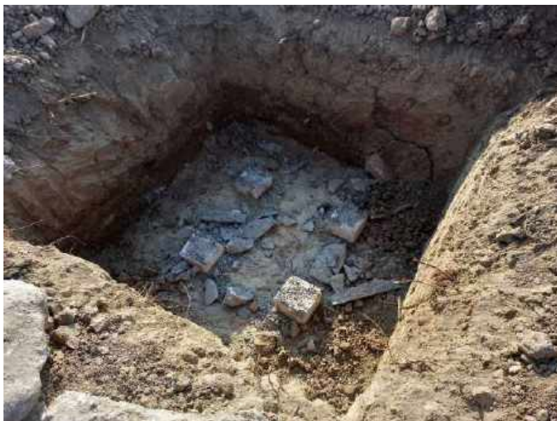
รูปที่ 4-41 ตัดเข็ม โครงการอาคารพาณิชย์ห้างโลตัส
