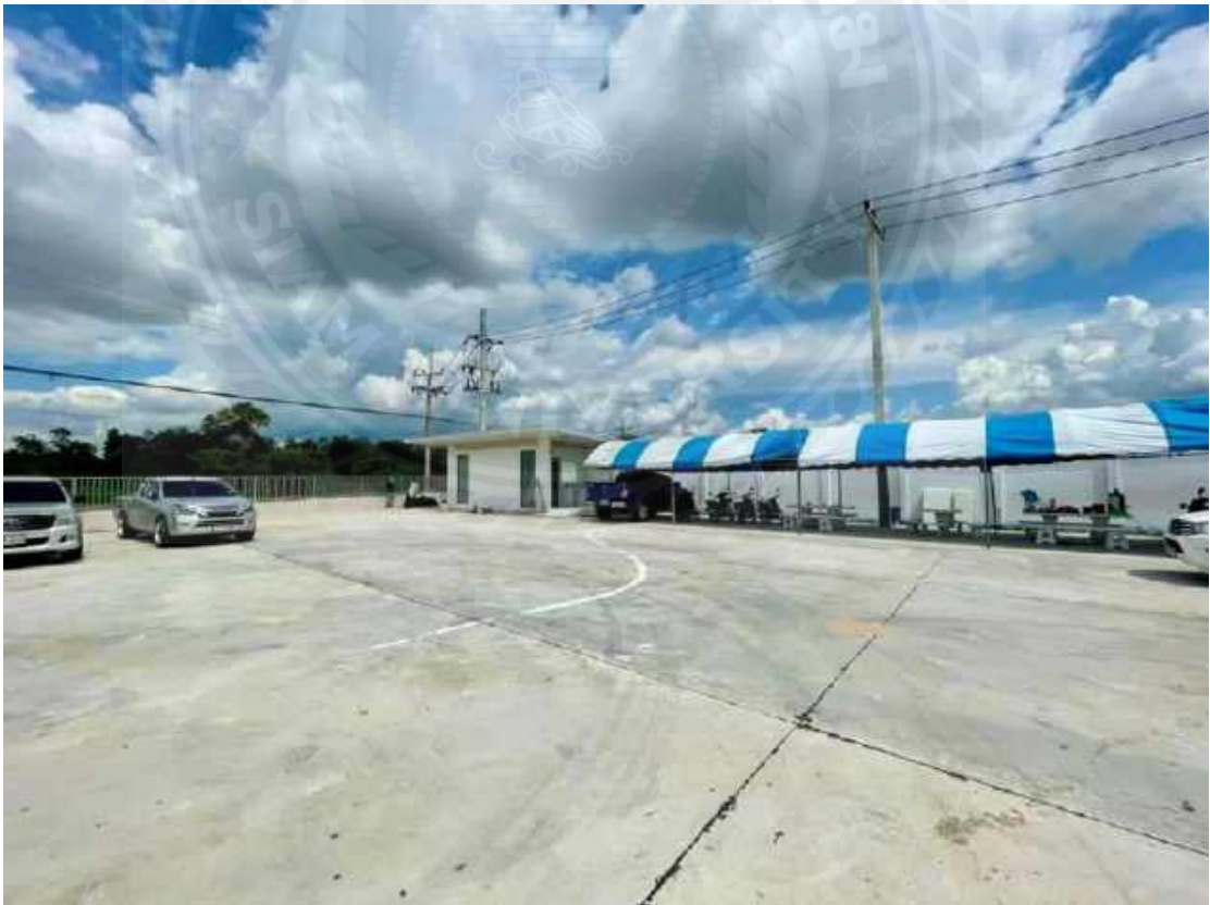
โครงการแล้วเสร็จ
