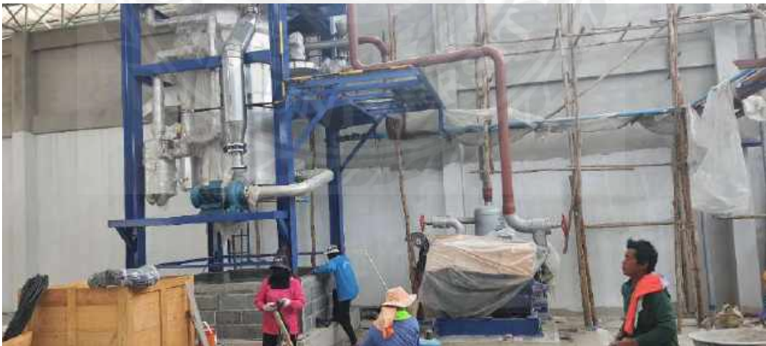
งานวางเครื่องจักร
