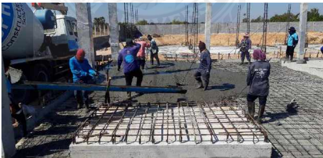
งานเทพื้นอาคาร
