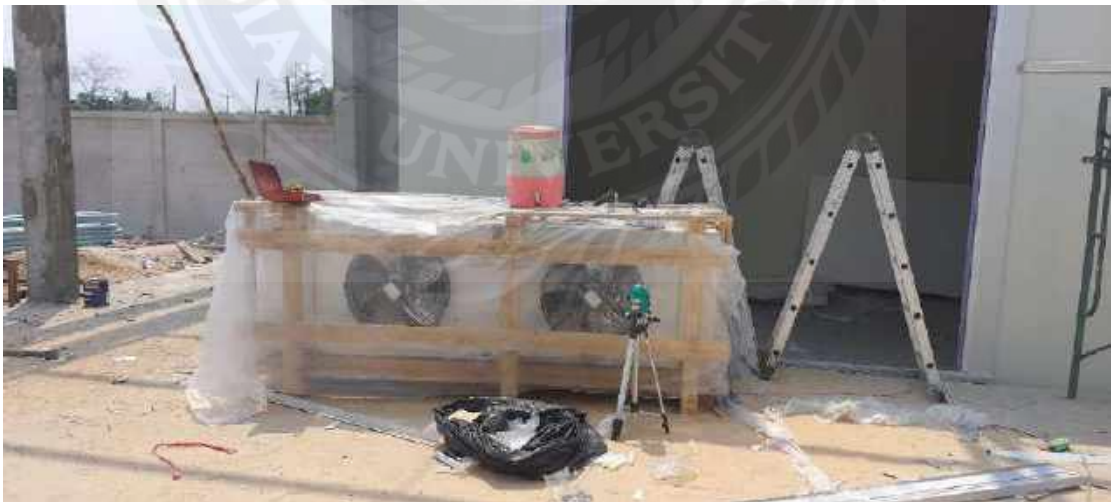
งานติดตั้งห้องเย็นสำหรับเก็บน้ำแข็ง
