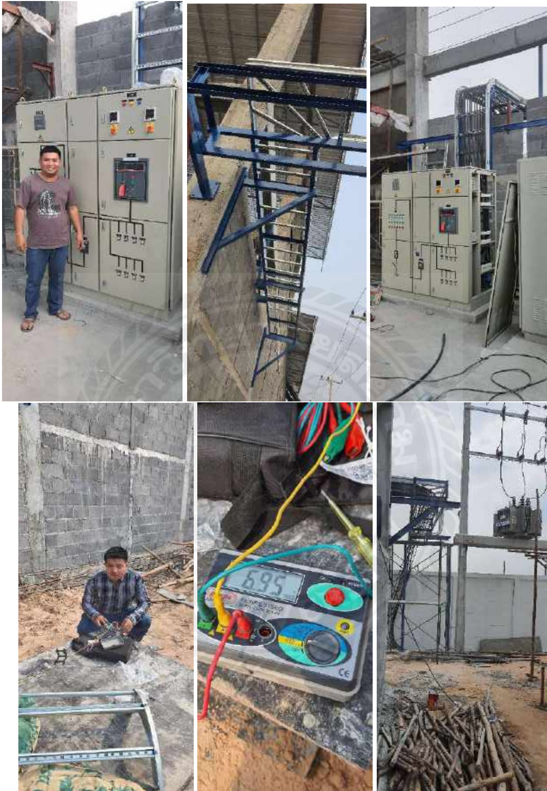
งานติดตั้งหม้อแปลงไฟฟ้าพร้อมตู้เมนรับหม้อแปลง
