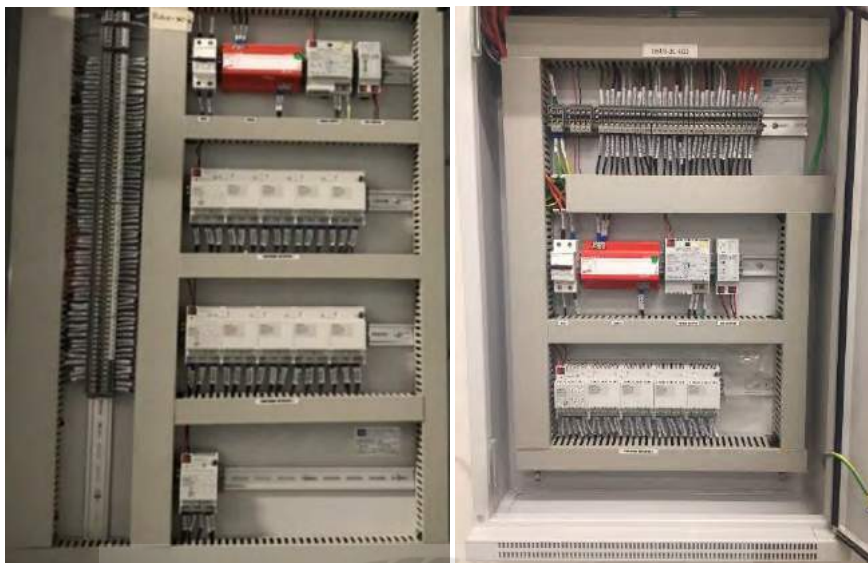
รูปที่ 4.9 เช้าสายและใส่ Cable Marker/Hot Mark ให้เรียบร้อย
