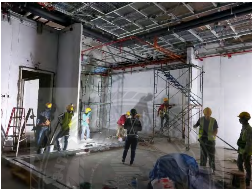
รูปที่ 4.6 งานติดตั้งท่อร้อยสาย
