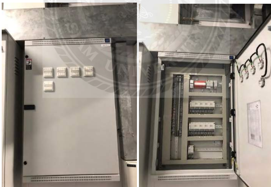
รูปที่ 4.8 ติดตั้งอุปกรณ์ควบคุมระบบแสงสว่าง
