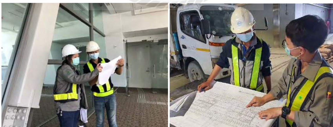
รูปที่ 4.2 ศึกษาแบบและสำรวจความพร้อมพื้นที่ทำงาน
