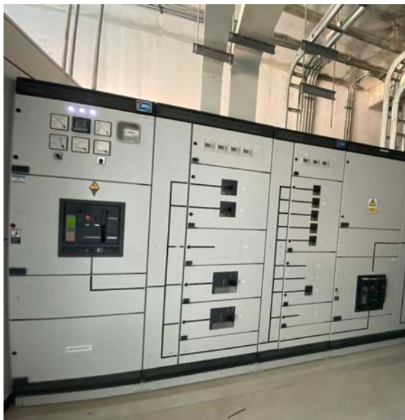
รูปที่ 2. 20 แผงสวิตช์ (Switchboards)
