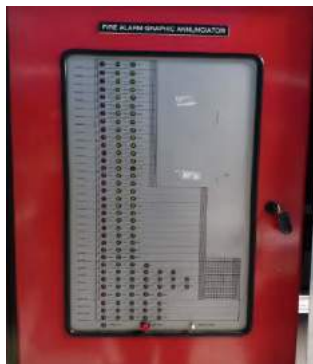
รูปที่ 4.4 ตู้แผงผังแสดงผล (Graphic Annunciator)
