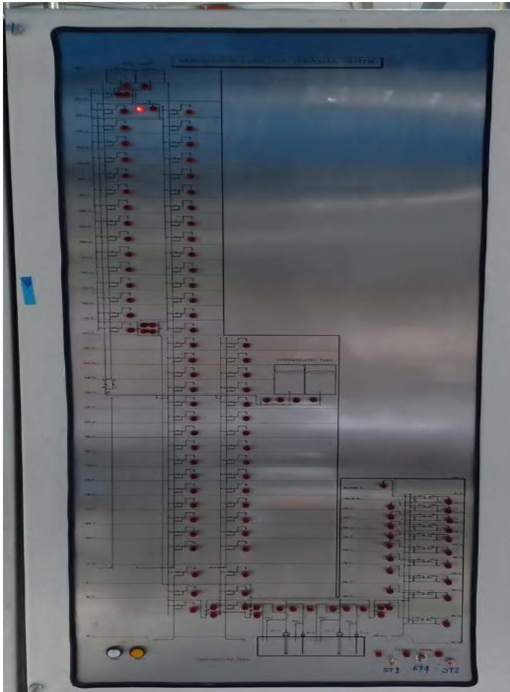
รูปที่ 5.3 ตู้แผงผังแสดงผล (Graphic Annunciator) ระบบดักเพลิง อาคาร
