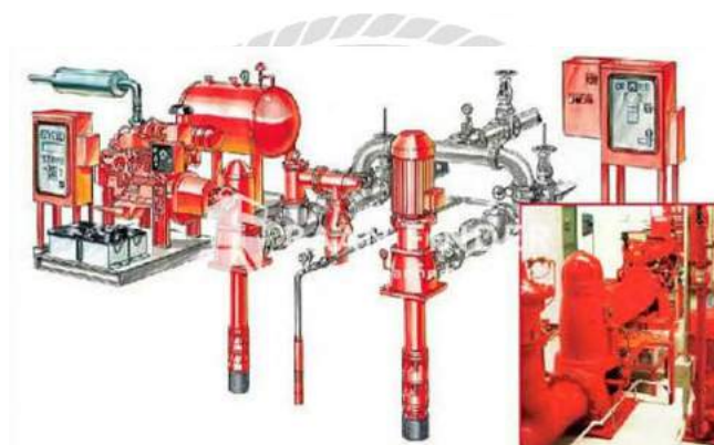
รูปที่ 2.99 ภาพแสดงเครื่องสูบน้ำดับเพลิงแบบนอน
