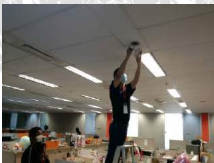
รูปที่ 4.6 การทดสอบอุปกรณ์ตรวจจับความร้อน
