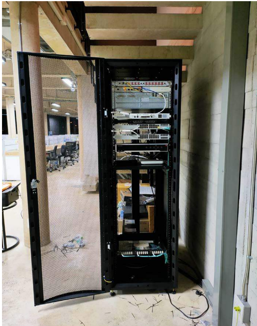
รูปที่ 4.2 รูปตู้ Rack ขนาด 42U และอุปกรณ์ต่างๆในตู้
