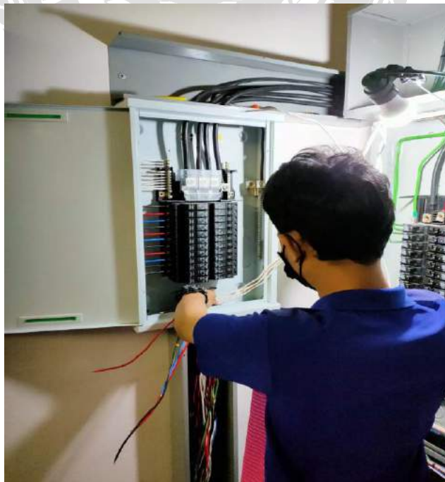
รูปที่ 4.3 การตรวจสอบตู้โหลดเซ็นเตอร์
