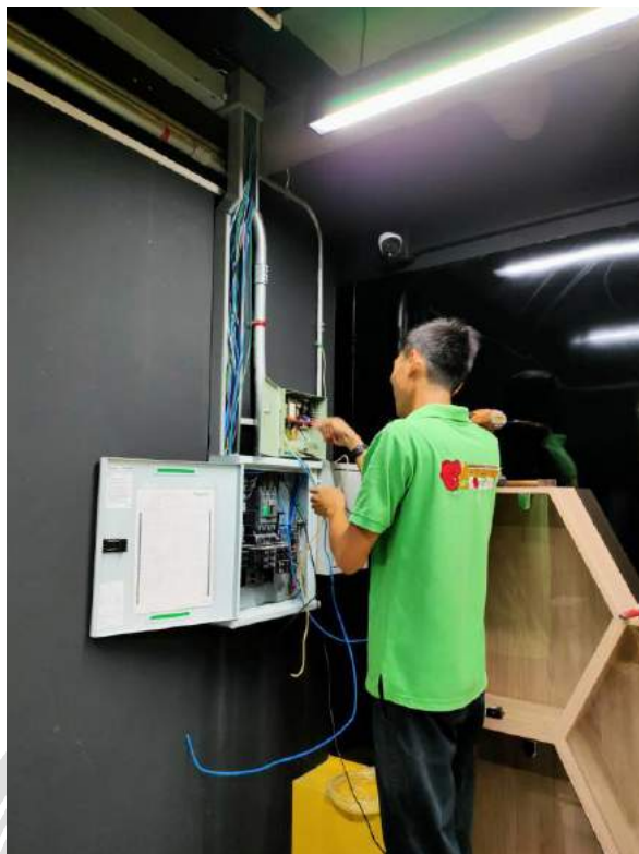
รูปที่ 4.11 การตรวจเช็คการทำงานของตู้ Control
