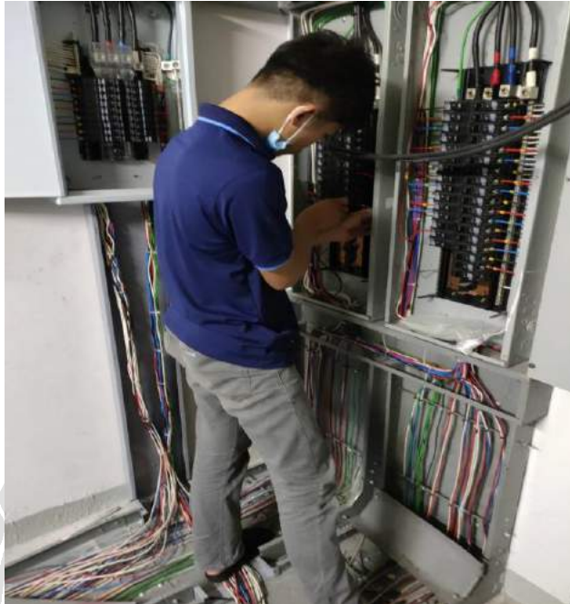
รูปที่ 4.3 การตรวจสอบตู้โหลดเซ็นเตอร์
