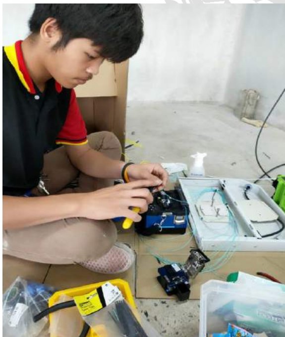
รูปที่ 4.15 การ Ssplice สาย fiber optic
