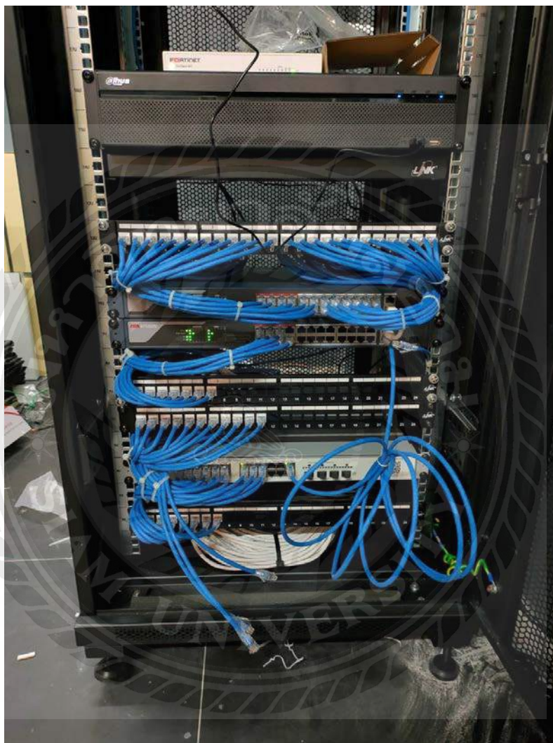
รูปที่ 4.3 รูปแสดงตัว Switch หลังจากติดตั้งและจัดสายเรียบร้อยแล้ว
