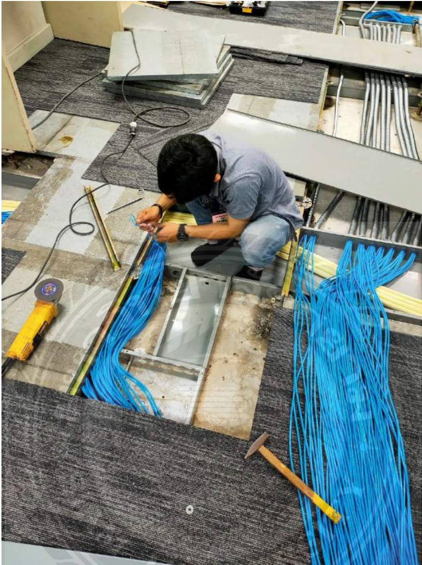
รูปที่ 4.5 รูปแสดงการเดินสายUTPในระบบเน็ตเวิร์ค
