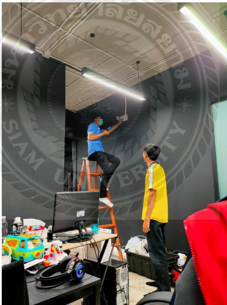
รูปที่ 4.8 รูปแสดงการติดตั้งกล้อง CCTV ระบบ IP
