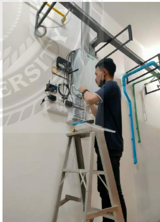
การเดินสายเตรียมติดตั้งกล้อง CCTV
