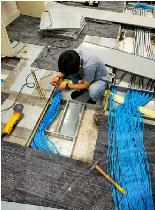
เดินสายเตรียมติดตั้ง Network
