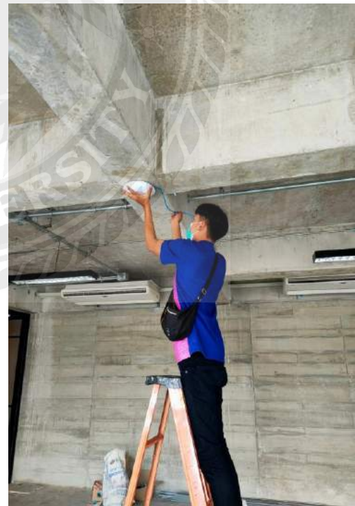
ติดตั้งจุดกระจายสัญญาณ
