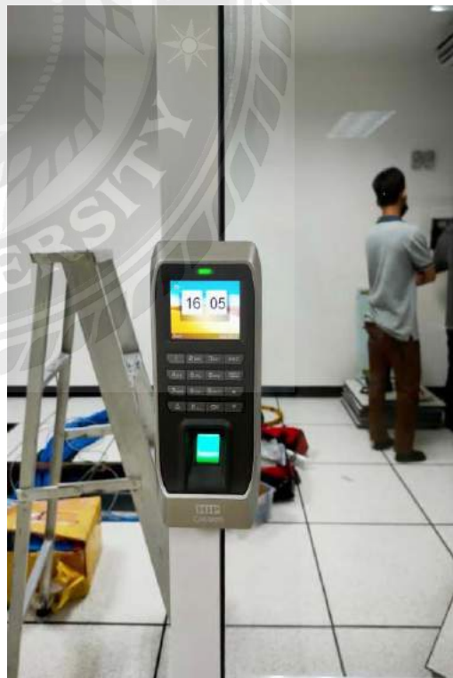
ทดสอบระบบ Access Control
