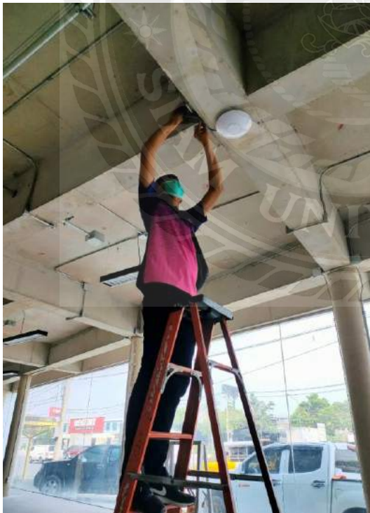
ติดตั้งจุดกระจายสัญญาณ
