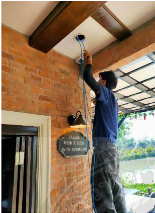
การเดินสายเตรียมติดตั้งกล้อง CCTV
