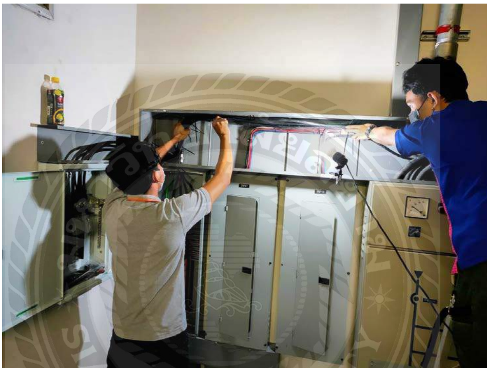
รูปที่ 4.23 รูปแสดงการเดินสายเมนจากตู้โหลดเซ็นเตอร์เข้าสู่ตู้ MDB
