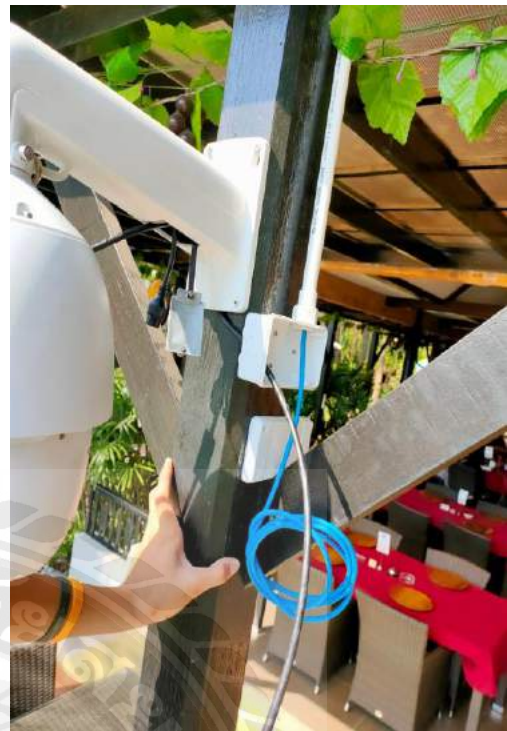
การเดินสายเตรียมติดตั้งกล้อง CCTV
