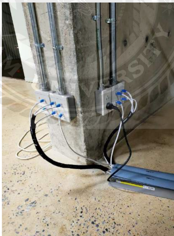
รูปที่ 4.7 รูปแสดง Outlet ที่ติดตั้งเสร็จแล้ว
