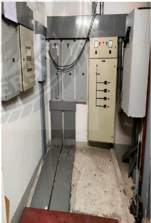
ติดตั้งตู้ Square D และระบบไฟฟ้า
