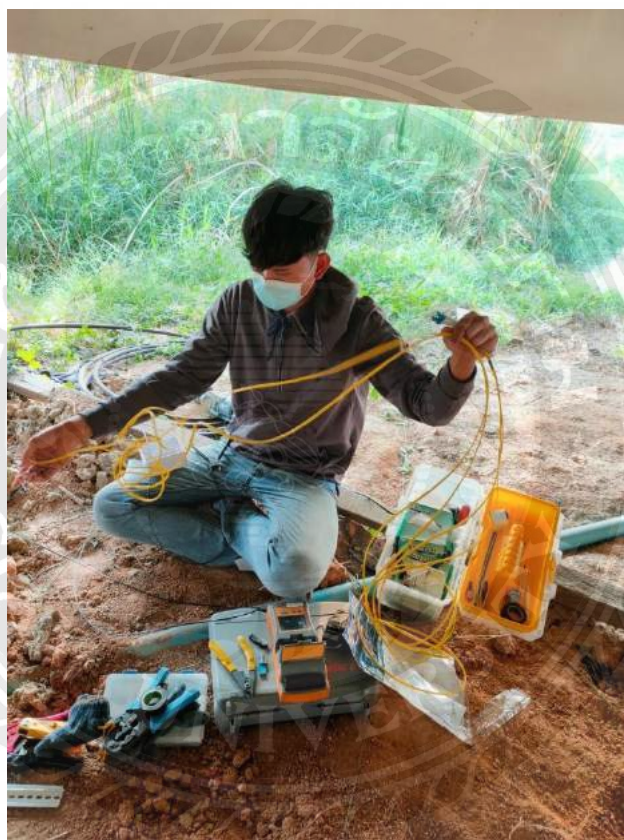
รูปที่ 4.12 รูปแสดงการเตรียมสายสำหรับการเชื่อมสาย Fiber Optic
