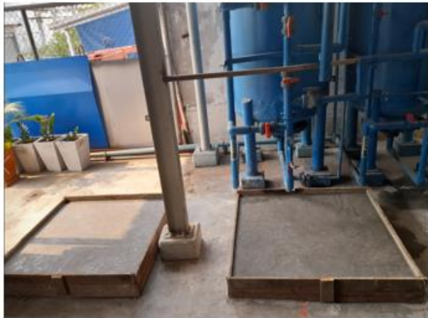
เตรียมพื้นสำหรับติดตั้งปั้มน้ำ
