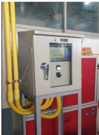
ตู้ควบคุมระบบอ่านค่าน้ำและไฟฟ้า
