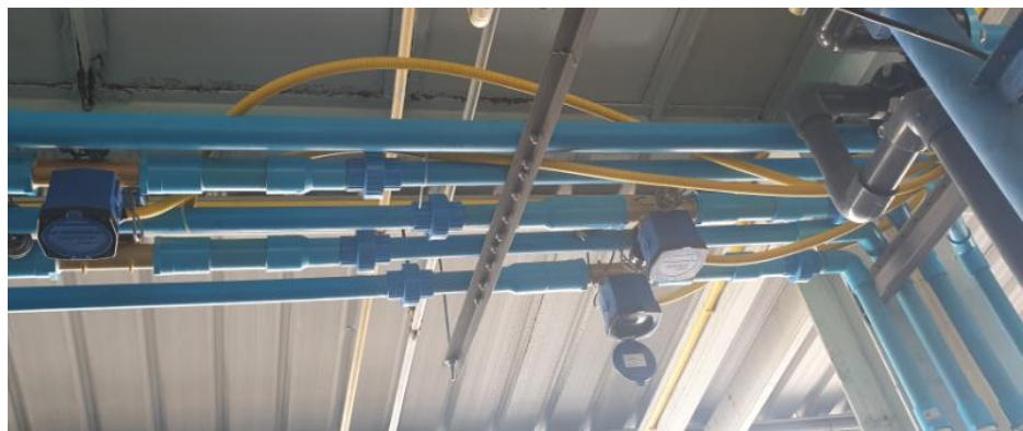
รูปที่ 4.6 ภาพก่อนและหลังการติดตั้ง Ultrasonic water meter
