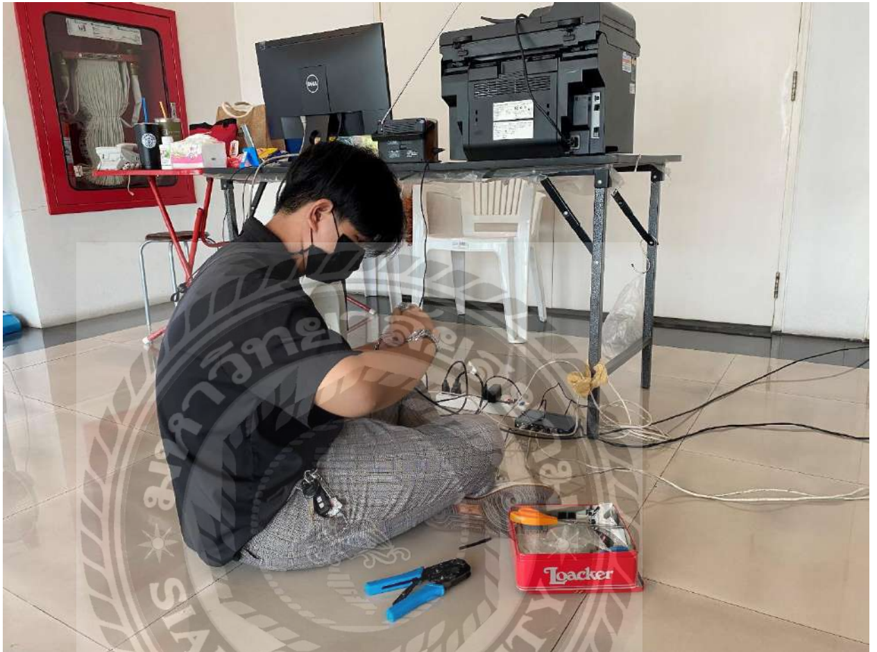
ภาพที่ ก.2 ติดตั้งสายอินเทอร์เน็ตให้ห้องประชุม
