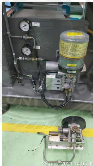
รูปที่ 4.5 ติดตั้งอุปกรณ์ตู้คอนโทรล ระบบน้ำมันอัตโนมัติเรียบร้อยแล้ว
