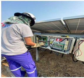
รูปที่ 12 การติดตั้งกล่องSSM
