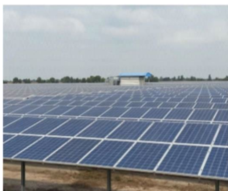
รูปที่ 11 แสดงแผงโซลาร์เซลล์ของโรงไฟฟ้าพลังงานแสงอาทิตย์โซลาร์ ไทรเพชร
