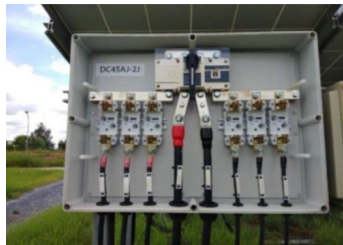
รูปที่ 13 การติดตั้งกล่อง AJ Box
