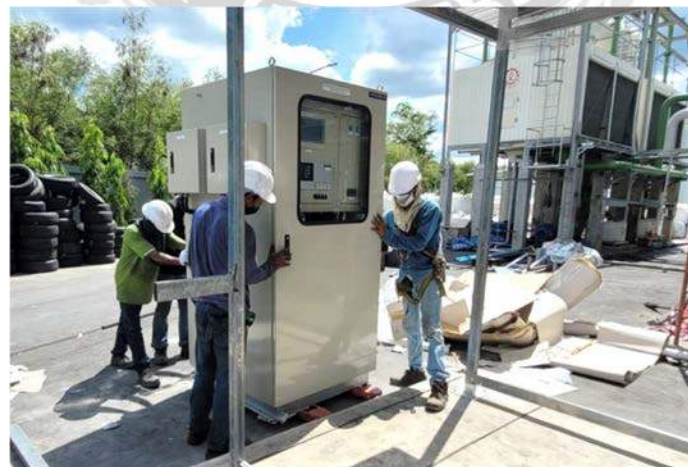
รูปที่ 4.19 การติดตั้งอุปกรณ์ตรวจวัดค่าอากาศที่ปล่อยออกที่ Stack (1)
