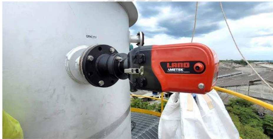
รูปที่ 4.21 การติดตั้งอุปกรณ์ตรวจวัดค่าอากาศที่ปล่อยออกที่ Stack (3)
