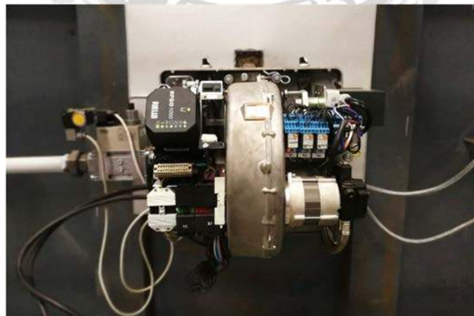
รูปที่ 4.4 การทดสอบการทำงานของ Burner
