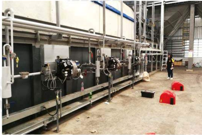
รูปที่ 4.3 การติดตั้ง Burner สำหรับ Reactor (2)
