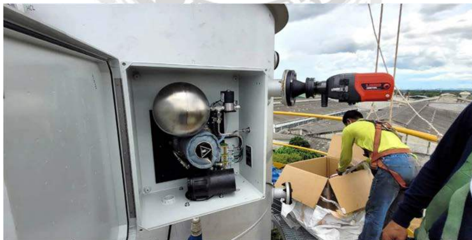
รูปที่ 4.22 การติดตั้งอุปกรณ์ตรวจวัดค่าอากาศที่ปล่อยออกที่ Stack (4)
