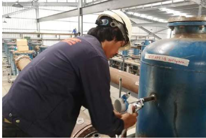
รูปที่ 4.5 การติดตั้งอุปกรณ์เครื่องมือวัด (Temperature Transmitter)
