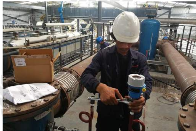
รูปที่ 4.6 การติดตั้งอุปกรณ์เครื่องมือวัด (Pressure Transmitter)
