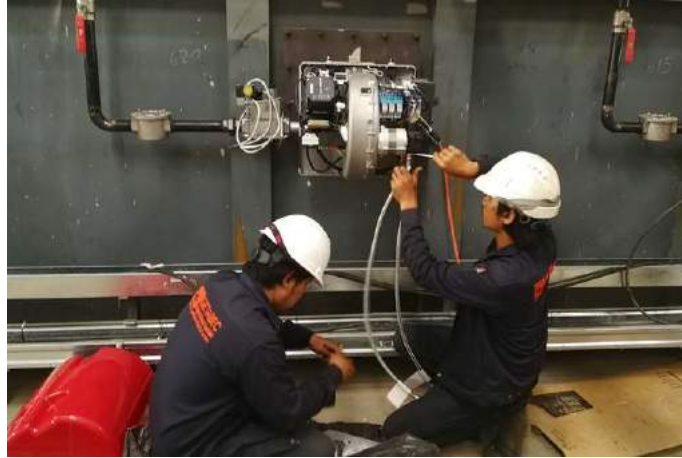
รูปที่ 4.2 การติดตั้ง Burner สำหรับ Reactor (1)
