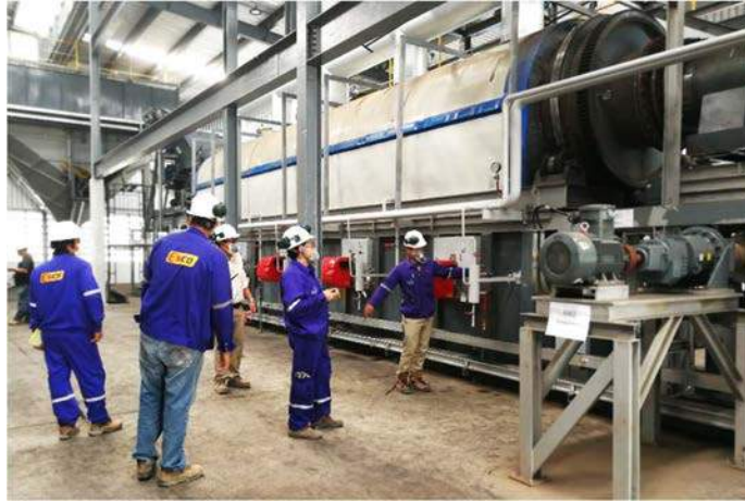
รูปที่ 4.8 ติดตามงานเดินระบบ Pyrolysis
