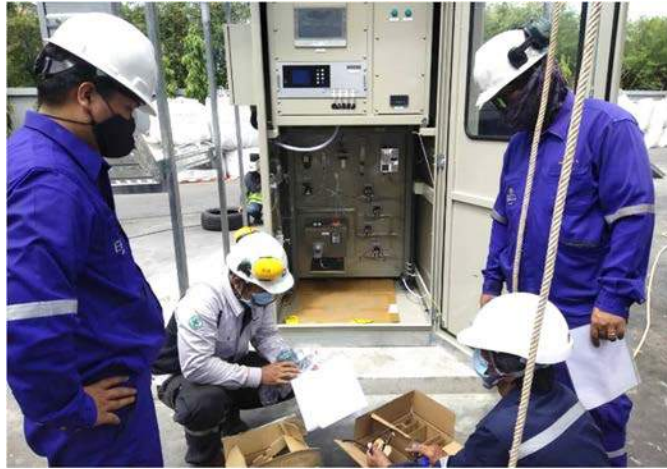
รูปที่ 4.20 การติดตั้งอุปกรณ์ตรวจวัดค่าอากาศที่ปล่อยออกที่ Stack (2)
