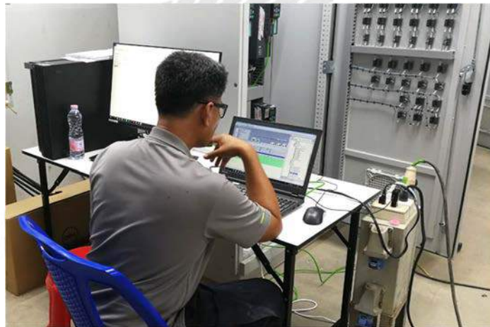
รูปที่ 4.18 การเขียน Logic Ladder สำหรับการควบคุมกระบวนการผลิต
