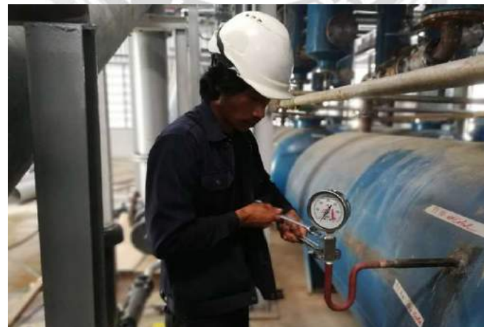
รูปที่ 4.7 การติดตั้งอุปกรณ์เครื่องมือวัด (Pressure Gauge)
