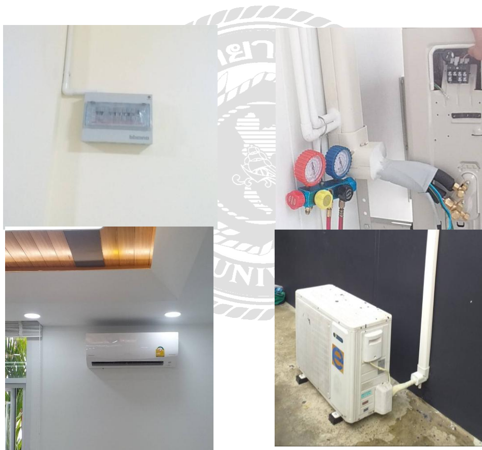
รูปที่ 4.6 ตัวอย่างงานติดตั้ง (4)
