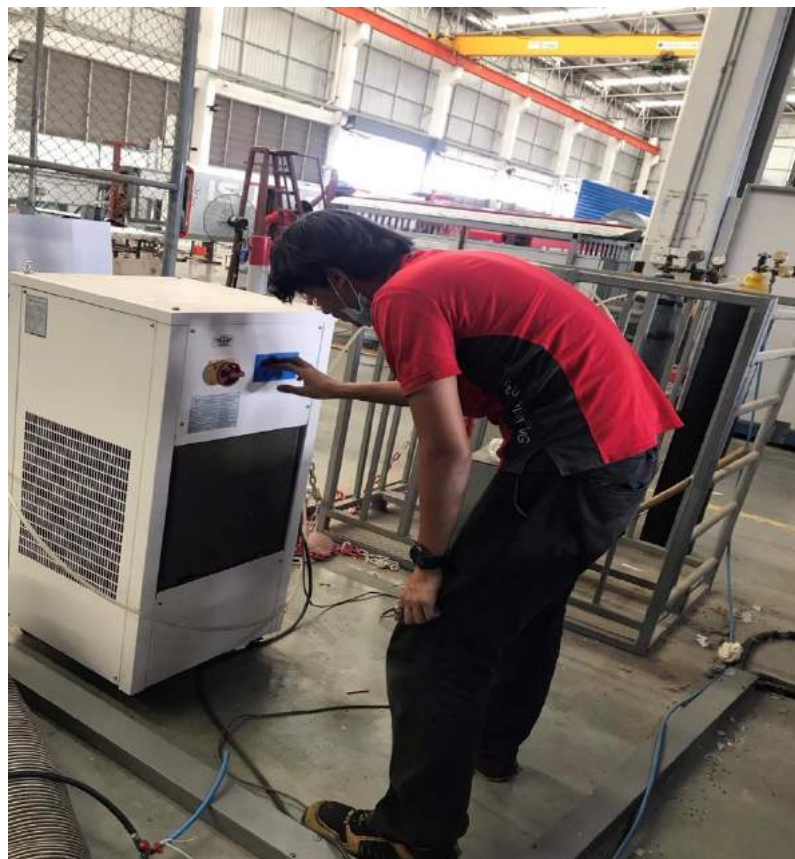
รูปที่ 4.3 แสดงการตรวจสอบการทำงานของเครื่องระบายความร้อนด้วยน้ำ
