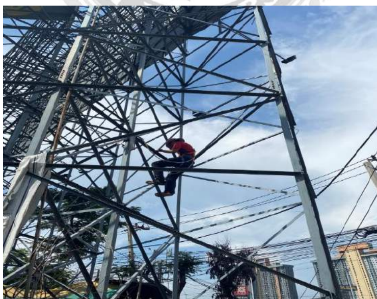
รูปที่ 4.8 แสดงการซ่อมบำรุงป้ายบิลบอร์ดภายนอก
