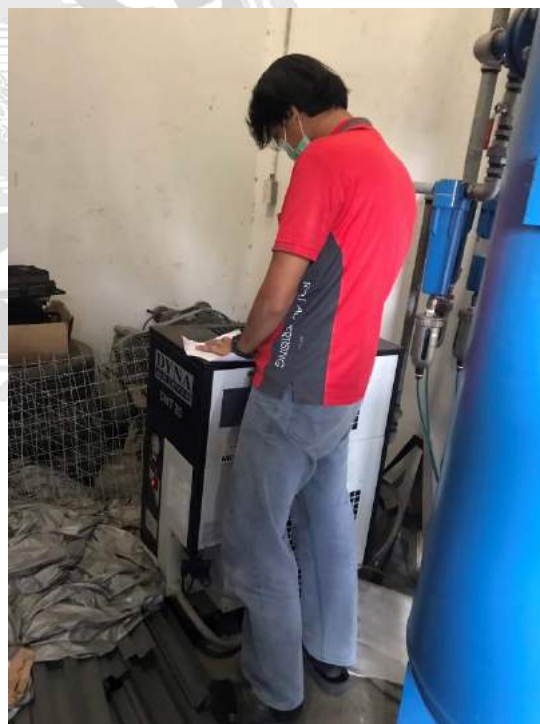
รูปที่ 8 การตรวจเช็คระบบทำลมแห้ง
