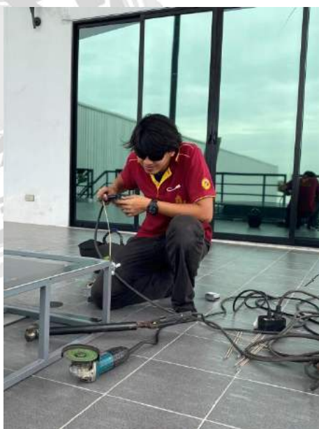
รูปที่ 4 งานเชื่อมโครงหลังคา
