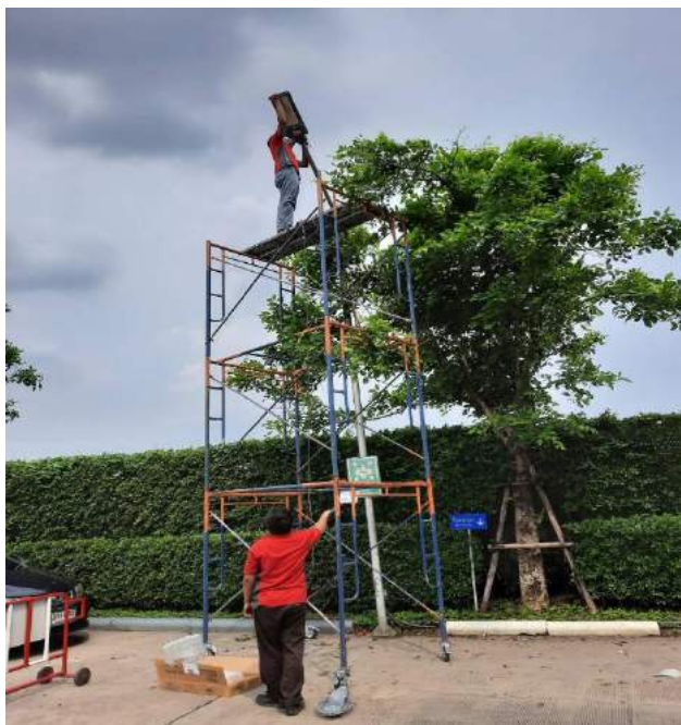
รูปที่ 4.7 แสดงการติดตั้งคอมไฟโซล่าเซลล์
