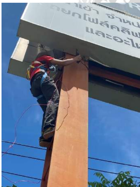
รูปที่ 3 การซ่อมไฟป้ายภายนอกอาคาร
