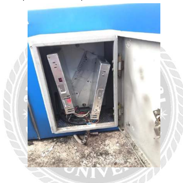
รูปที่ 4.9 แสดงการเปลี่ยนชุดแปลงไฟฟ้า 12 V
