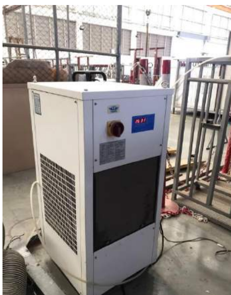
รูปที่ 3.8 แสดงเครื่อง Chiller
