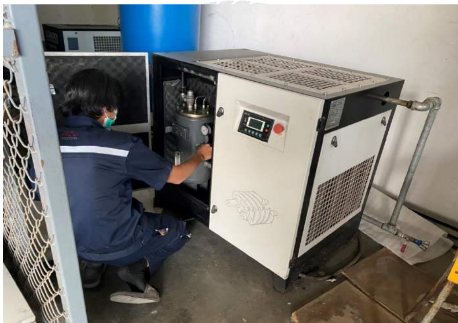
รูปที่ 4.4 แสดงการตรวจเช็คการทำงานของปั๊มลม
