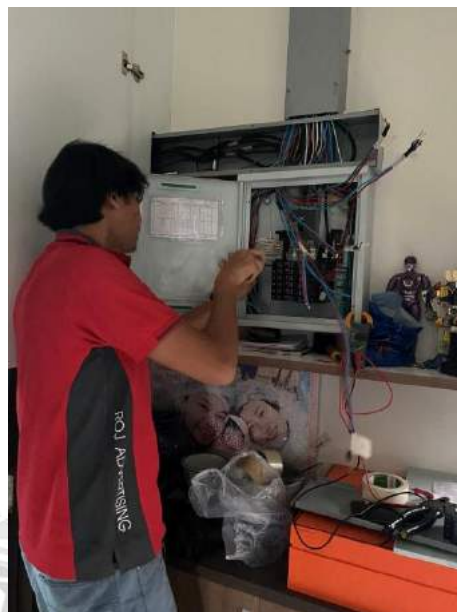
รูปที่ 2 การตรวจเช็คระบบไฟฟ้าในอาคาร
