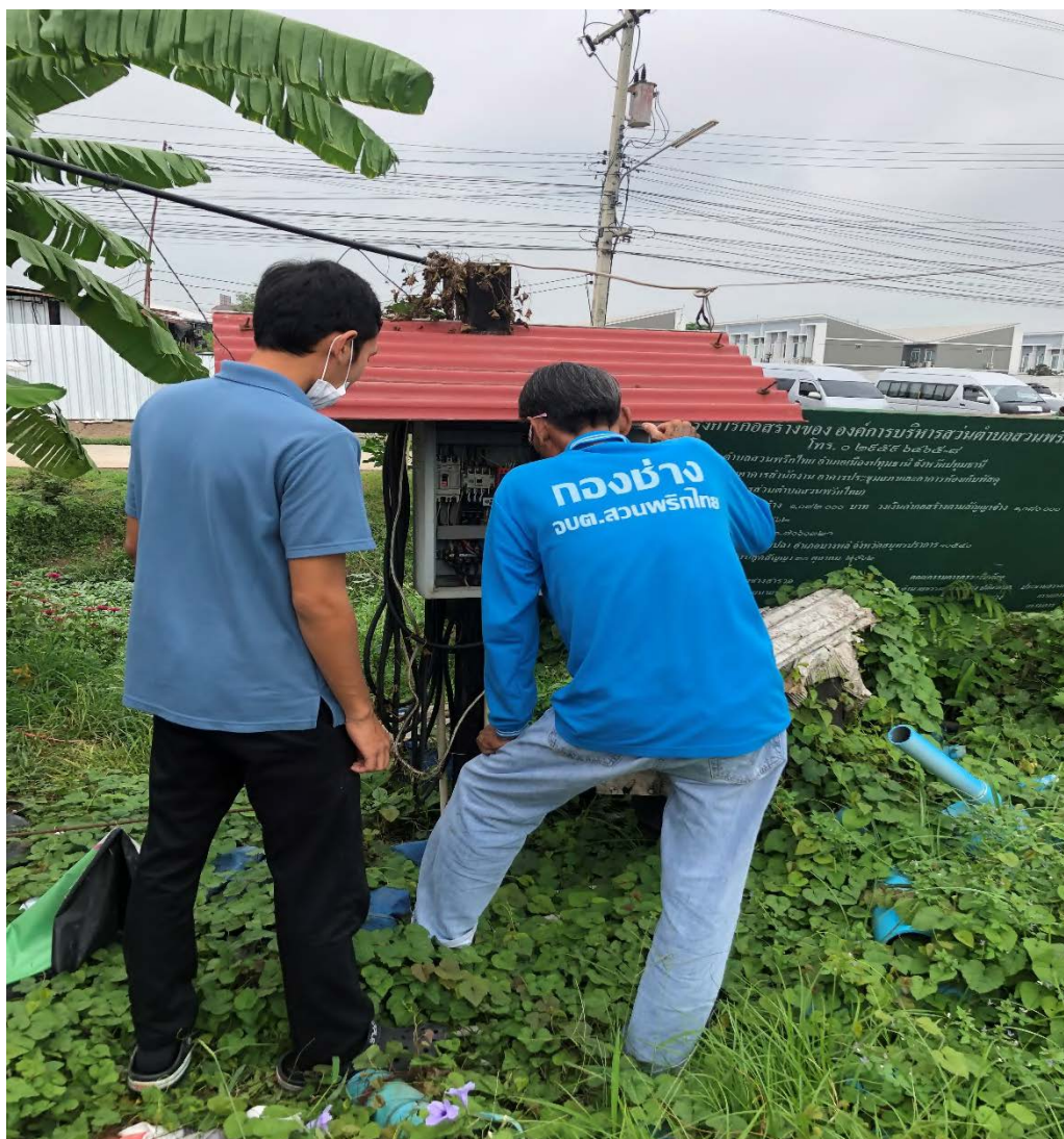
รูปที่ 4.5 เปลี่ยนครีซแฮ้าส์และสายไฟ
