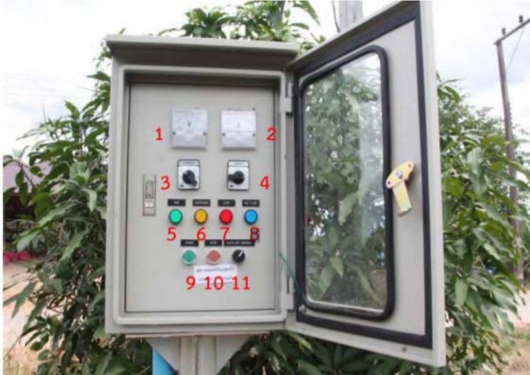
รูปที่ 4.7 อุปกรณ์ภายนอกด้านหน้าตู้ควบคุม
